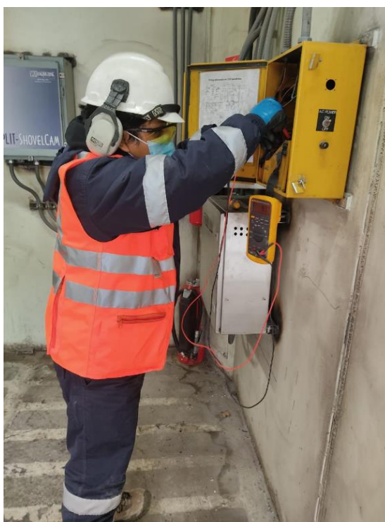
Figura 20. Inspección de alimentación eléctrica y UPS
