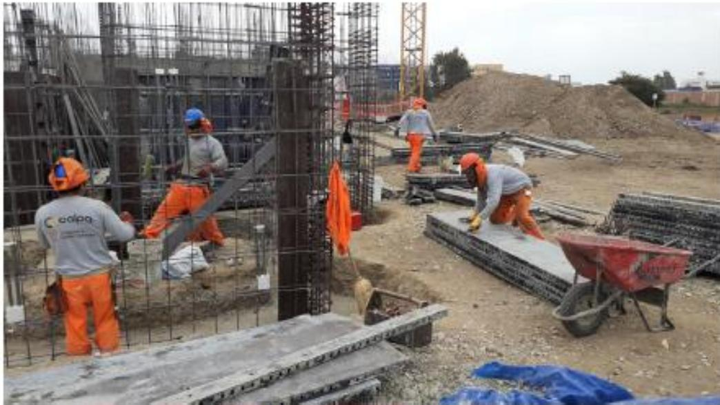
Trabajo de encofrado metálico del sector 01
