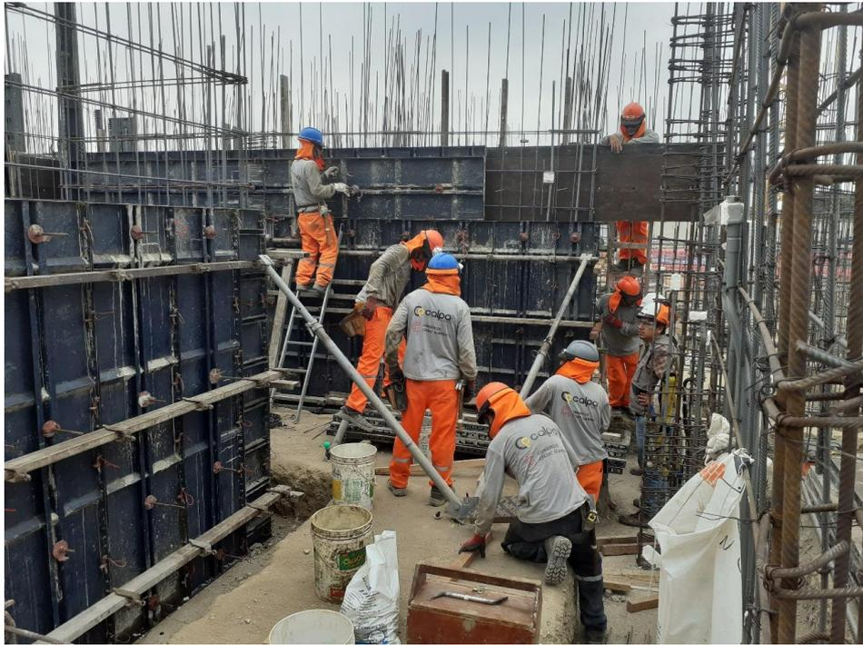
*Figura 43: Proceso de encofrado metálico en verticales*
