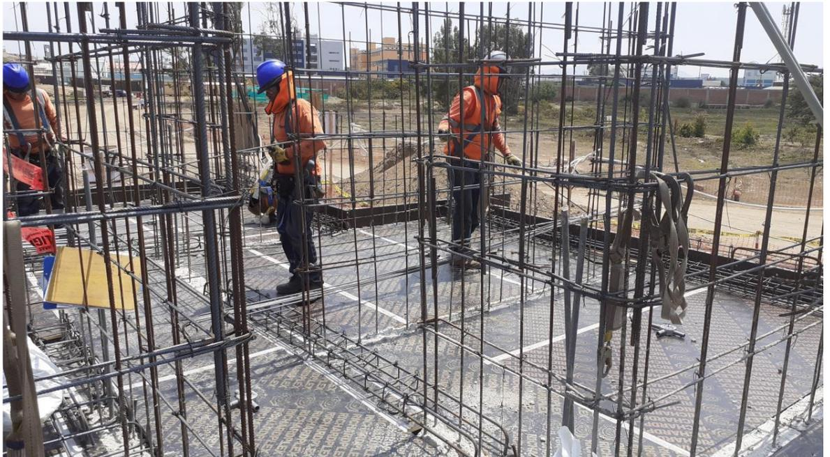
*Figura 38: Colocación de acero de refuerzo horizontal en placas*
