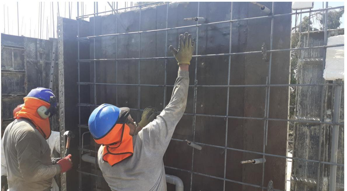
*Figura 44: Colocación de escantillones para encofrado verticales*
