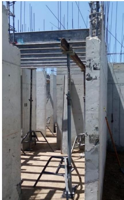
*Figura 48: Apuntalamiento de encofrado de losa maciza*
