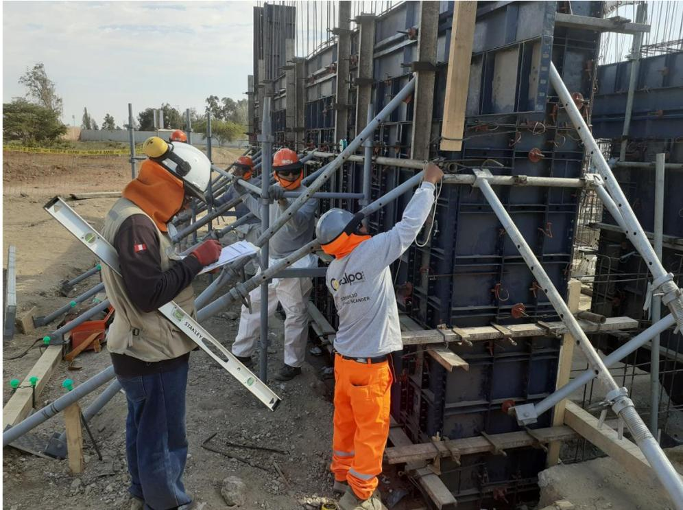
*Figura 45: Liberación de encofrado vertical previo al vaciado de concreto*
