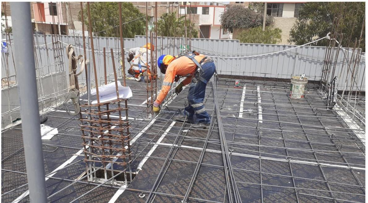
*Figura 39: Colocación de acero de refuerzo en losa maciza*
