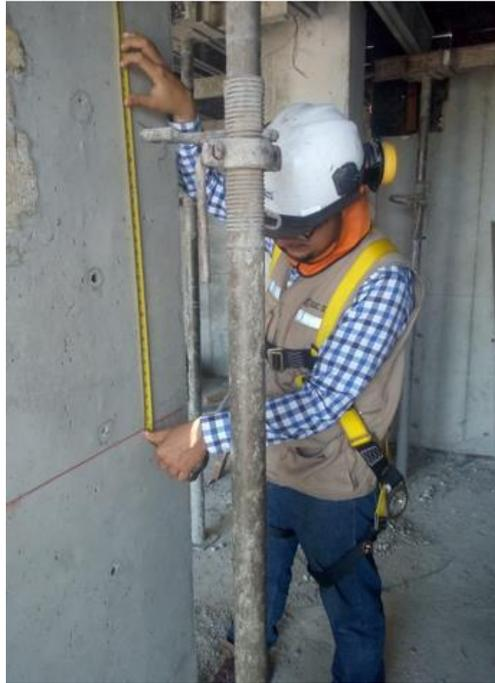
*Figura 47: Liberación de encofrado de losa maciza*
