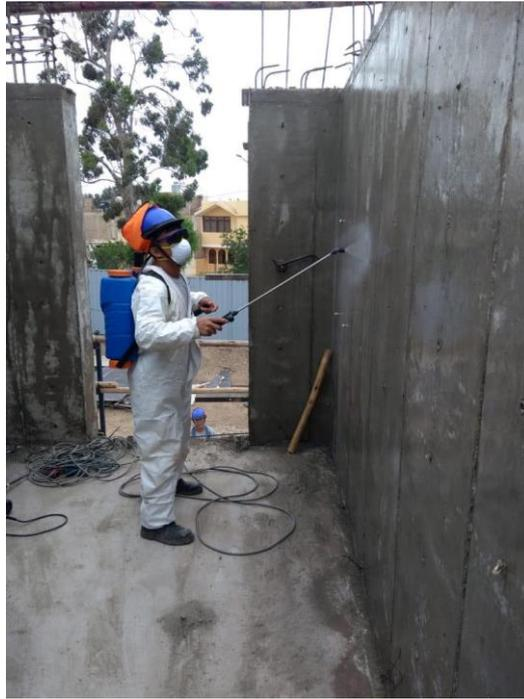
*Figura 55: Curado de placas de concreto con curador químico*
