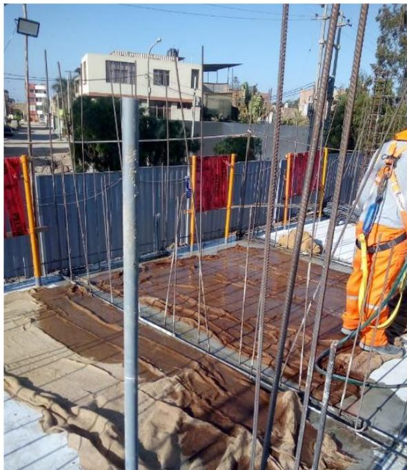
*Figura 56: Curado de losa maciza de concreto con arrocera de yute y agua*
