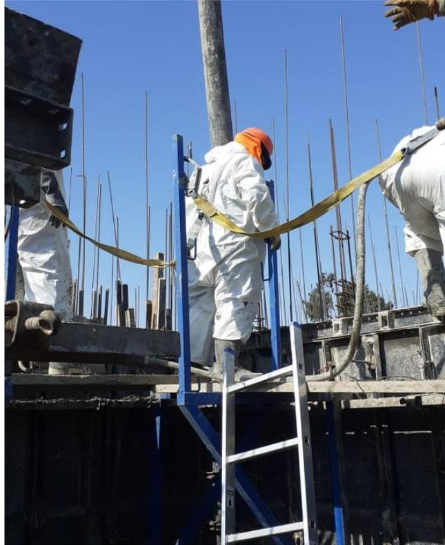
*Figura 51: Vaciado de concreto en verticales*
