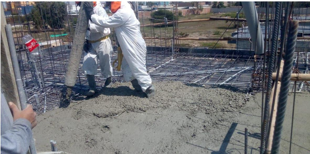
*Figura 52: Vaciado de concreto en losa maciza*
