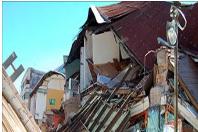
Figura 8 : Vulnerabilidad en Viviendas
