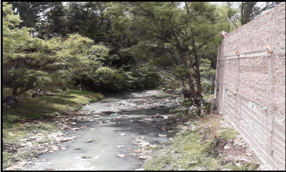
Figura 17 Construcciones en el cauce del río
