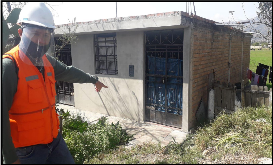
Figura 23 Viviendas autoconstruida en terrenos inapropiados
