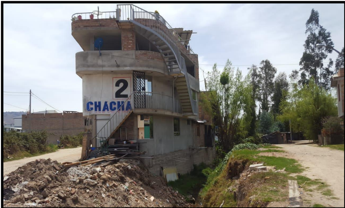
Figura 16 Viviendas construidas en el cauce de Río
