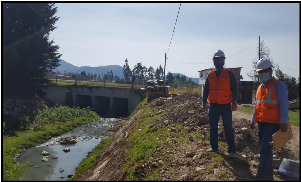
Figura 20 Realizando visita de campo
