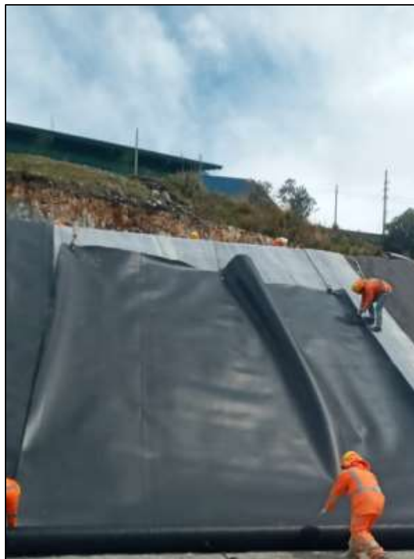
Figura 21. Tendido de geomembrana.
