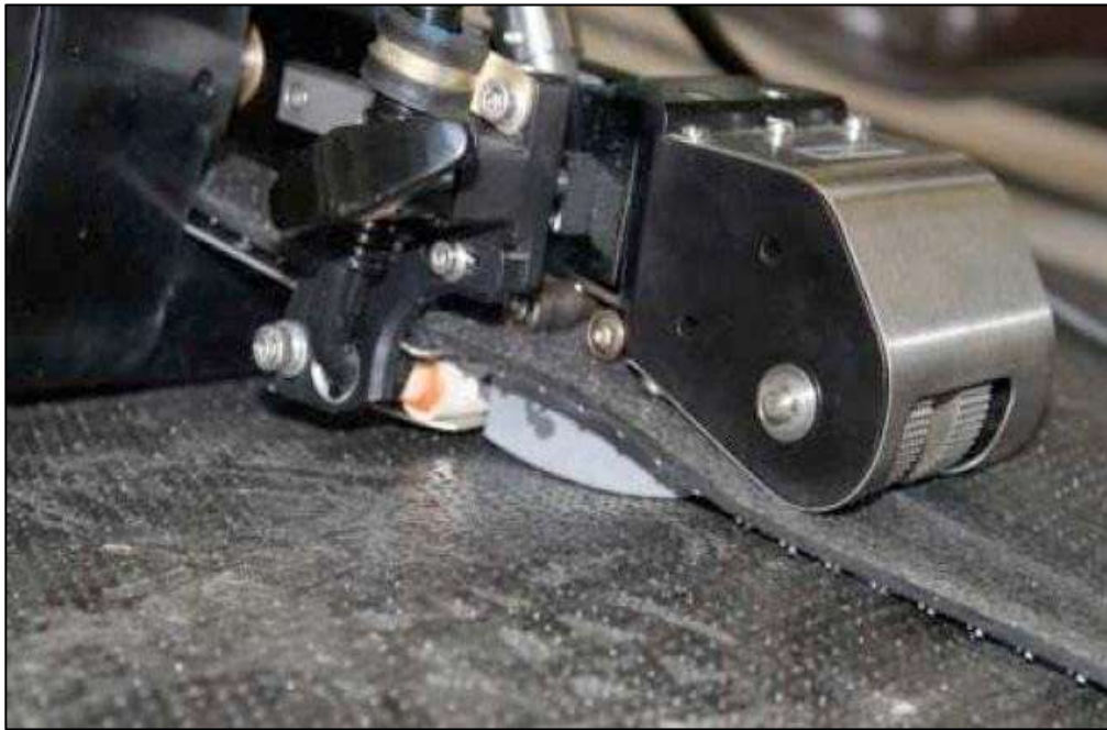
Figura 17. Soldadura de geomembrana.
