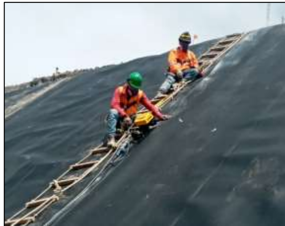
Figura 24. Verificación de grietas.
