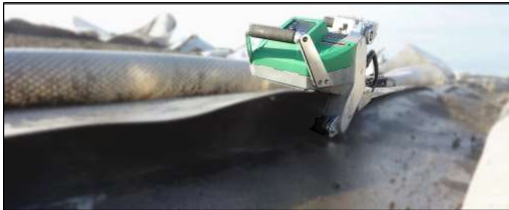
Figura 19. Soldadura en cuña.
