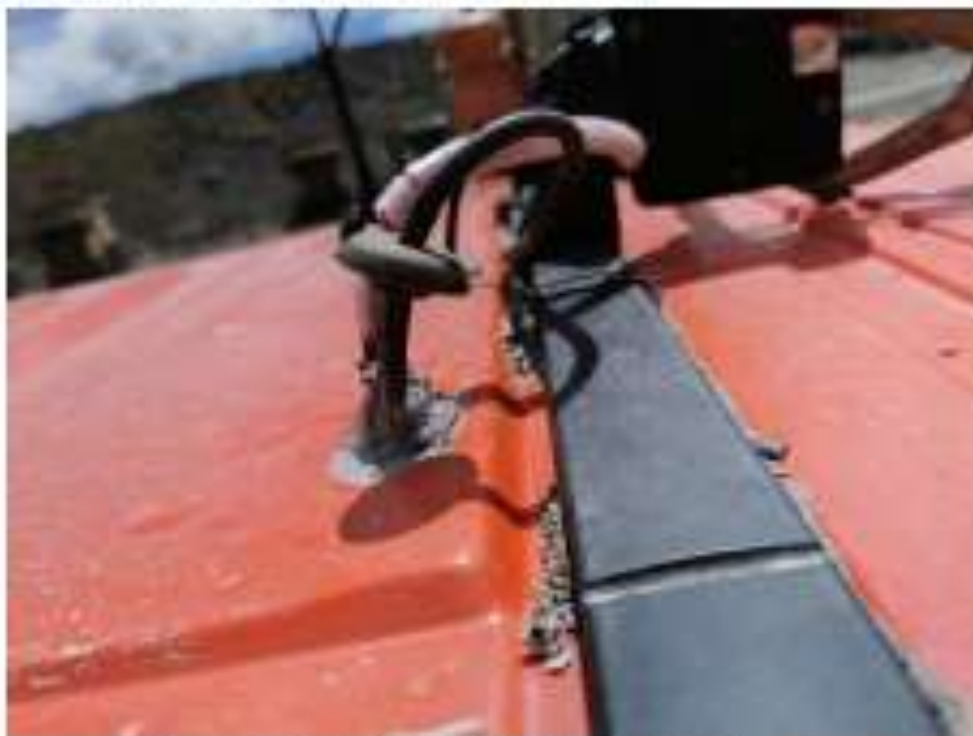
Ilustración 3: Guía de cables de alimentación y comunicación
