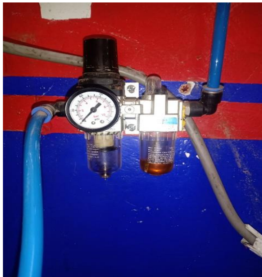
Figura 40. Cambio de filtros del compresor
