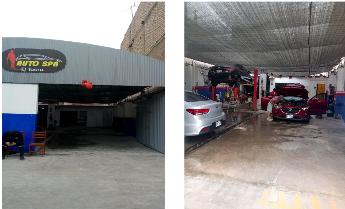
Figura 30. Foto de la fachada
