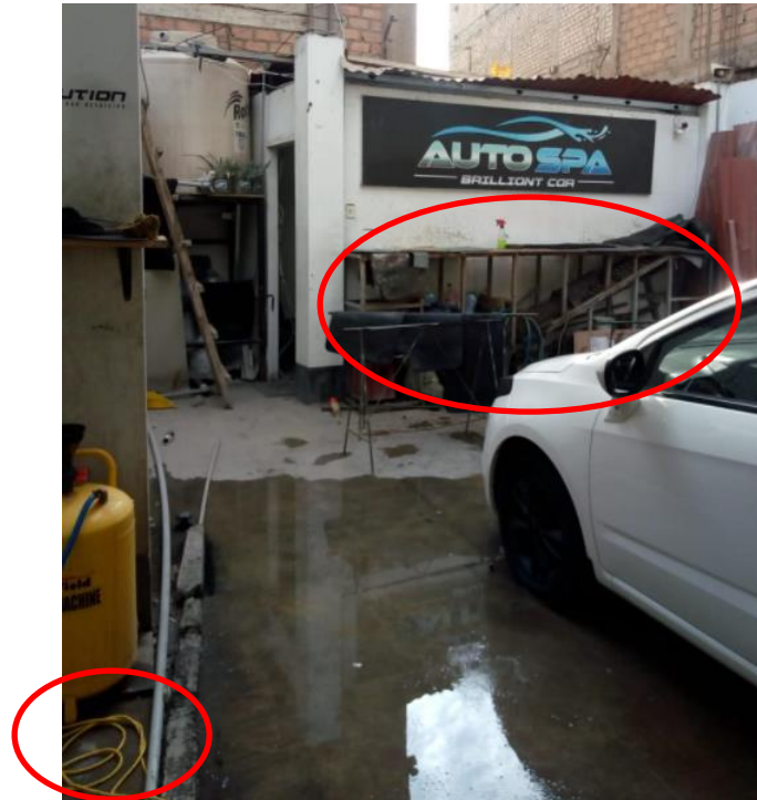
Figura 11. Desorden en área del taller donde se realiza el servicio de carwash y cableado de aparatos eléctricos sobre el agua
