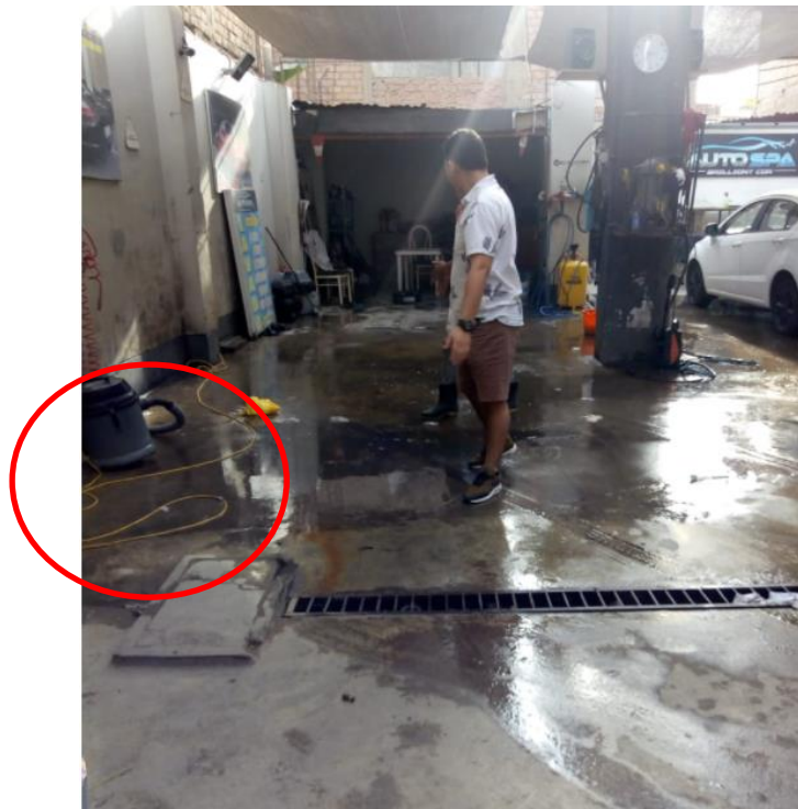
Figura 12. Riesgos eléctricos donde se realiza el servicio de carwash
