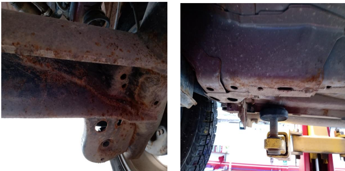
Figura 22. Chasis con principios de corrosión, antes de aplicar el procedimiento Undercoating
