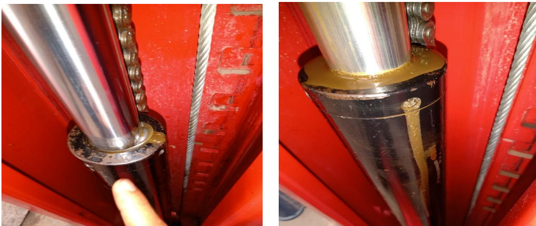
Figura 44. Mantenimiento correctivo del elevador hidráulico
