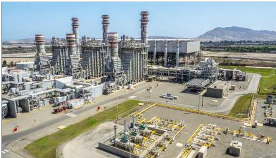
Figura 1. Foto panorámica de la Central Termoeléctrica Kallpa.
