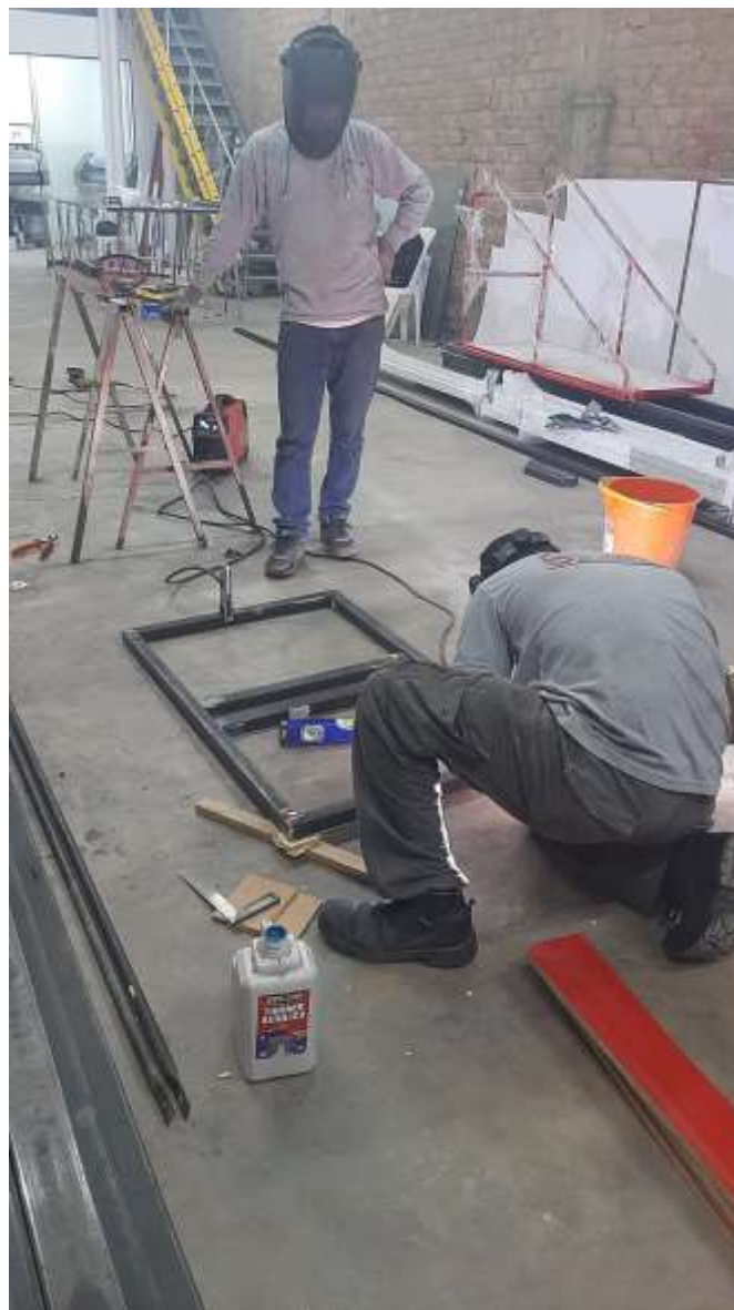
Figura 6. Condición insegura de trabajo: fallas en infraestructura para ejecutar labores Fuente: Jomigraf Group, S.A.C. (2021).
