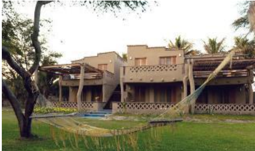
FIGURA N° 3.5: HOSPEDAJE LOS HORCONES DE TÚCUME
