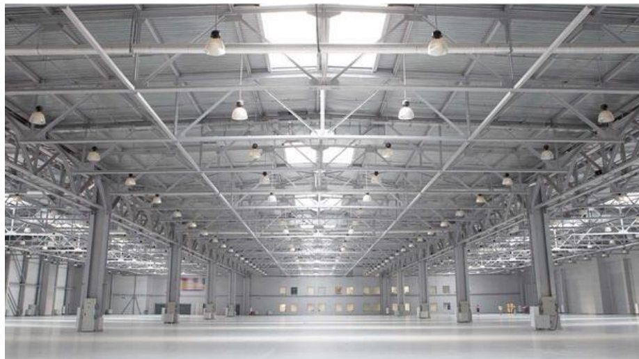
Figura 43 Ejemplo de nave industrial
