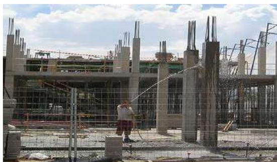
Figura 12. Curado del concreto
