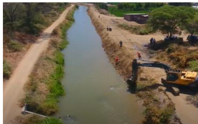
Figura 10. Descolmatación del canal Miguel Checa Fuente: Gobierno Regional de Piura (2017).
