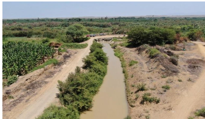
Figura 7. Canal Miguel Checa progresiva 0+25 – 0+ 585 Fuente: peruconstruye.net (2020)
