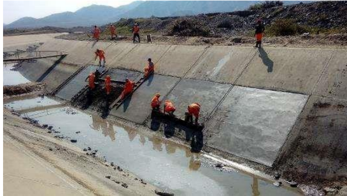
Figura 29. Impermeabilización de canales con concreto Fuente: Gobierno Regional de la Libertad
