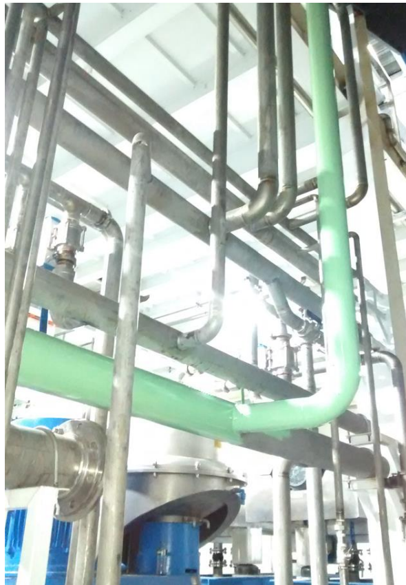
Figura 26. Detalle de Instalación de las Tuberías CIP a Centrifugas
