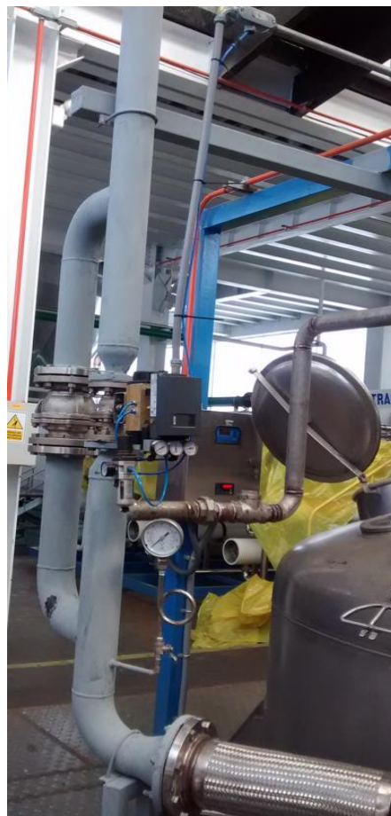
Figura 16. Instalación de línea de Vapor a cada Reactor
