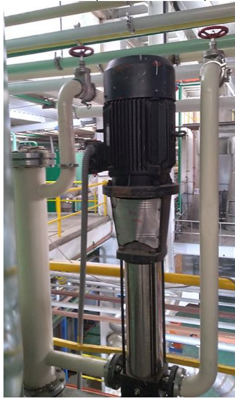
Figura 58. Ensamble terminado de Bomba Multi-etapica de 20Bar.
