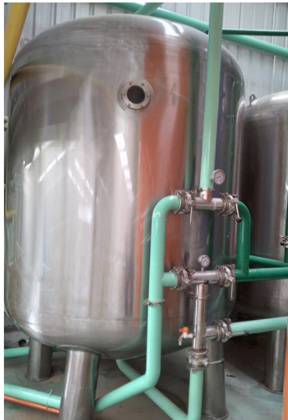
Figura 58. Ensamble terminado de tanques de filtro de Grava.
