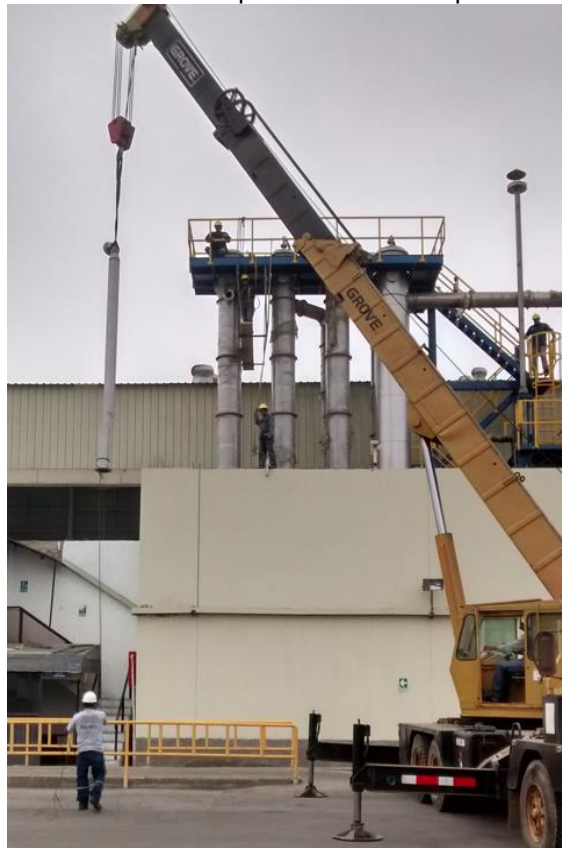
Figura 53. Montaje de tuberías en el Evaporador.
