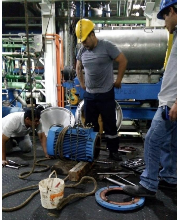
Figura 27. Equipo de Trabajo en el Montaje de Motores de Sedicanter
