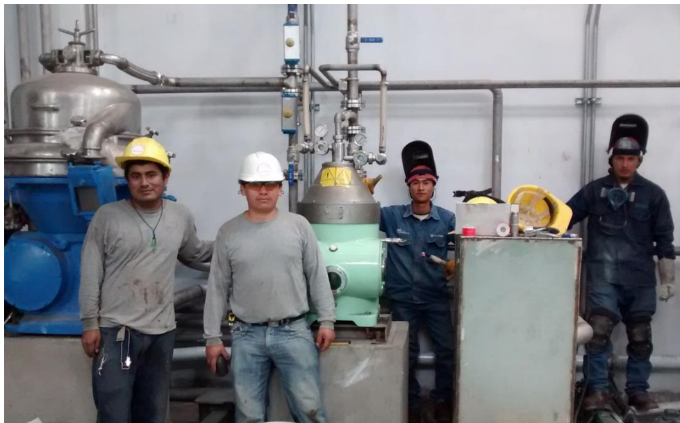
Figura 28. Equipo de Trabajo en el Montaje de Tuberías, Bombas y Centrifugas
