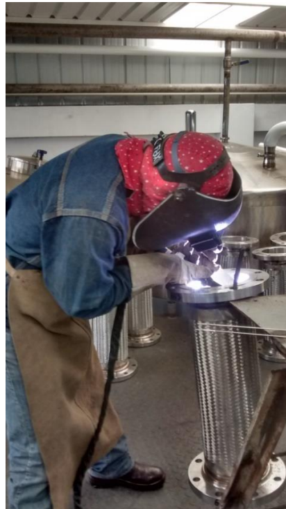
Figura 37. Soltado TIG de tubos flexible de Vapor para Secador RCD
