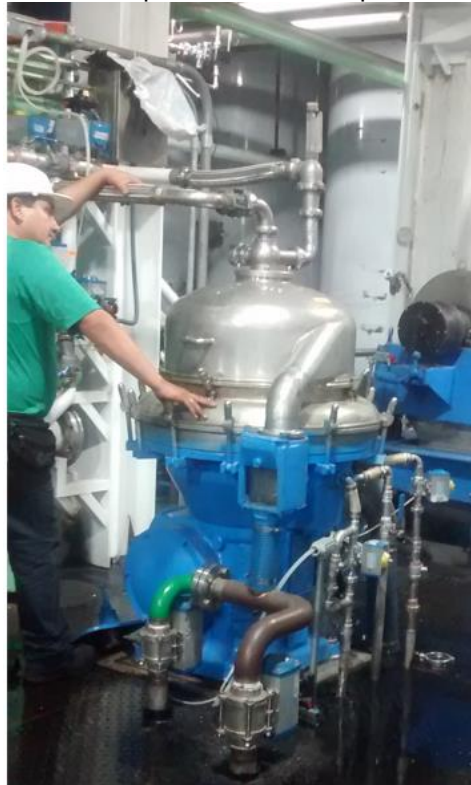
Figura 29. Operador haciendo Pruebas en los Equipos Instalados
