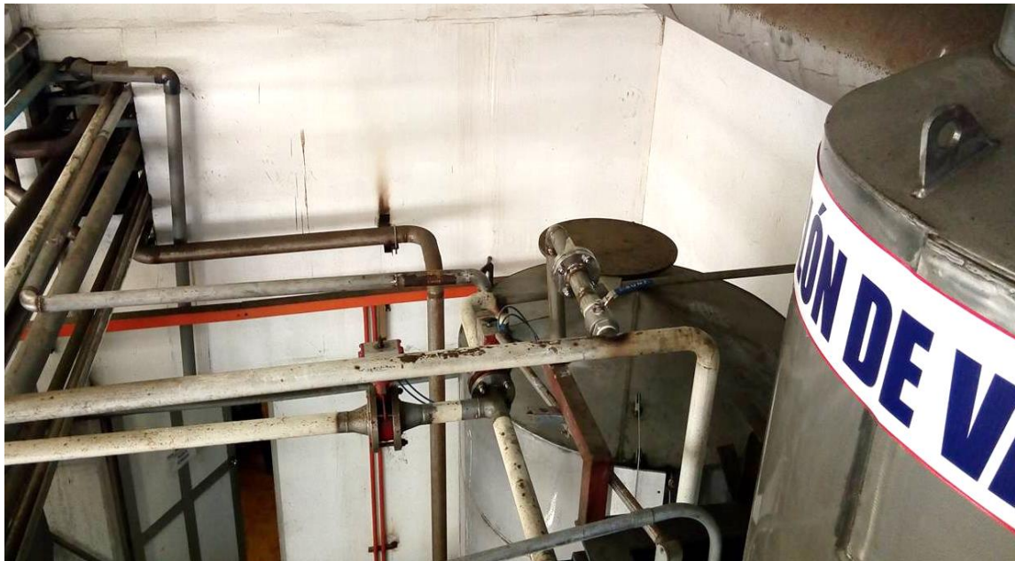
Figura 54. Corte de la tubería para la interconexión de válvulas de desvío de los líquidos.
