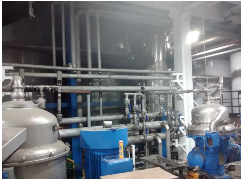
Figura 25. Detalle de Instalación de las Tuberías a Centrifugas
