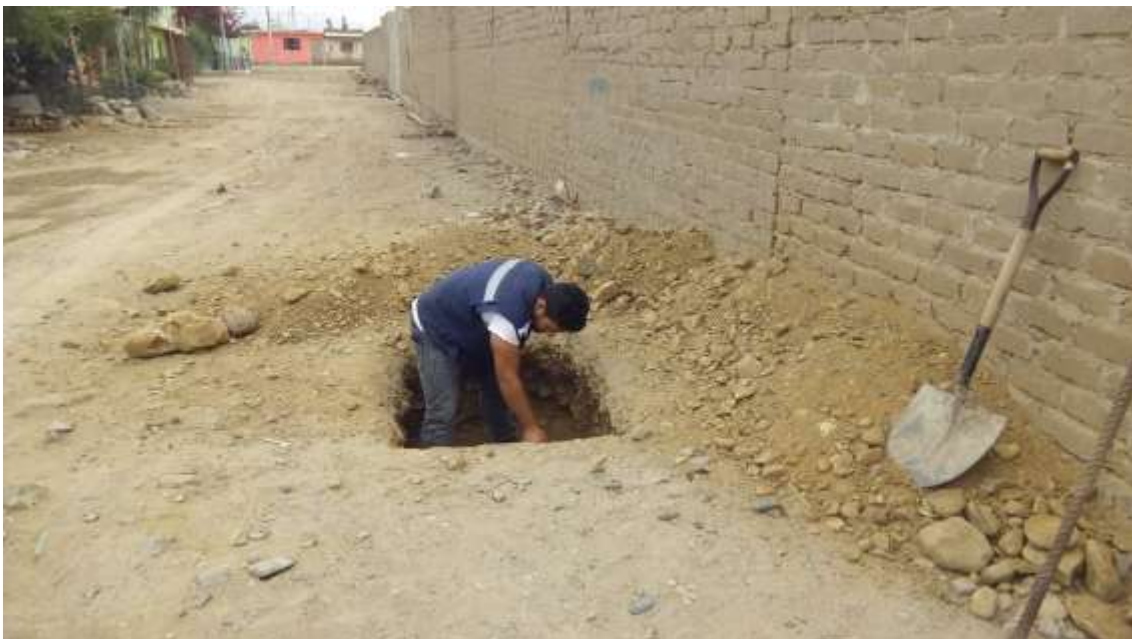
Figura 115: perforación de calicata
