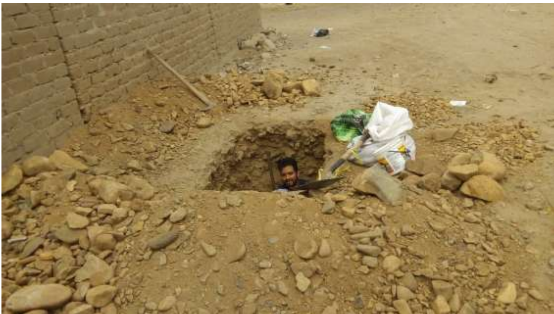
Figura 117: Termino de calicata y obtención de muestras
