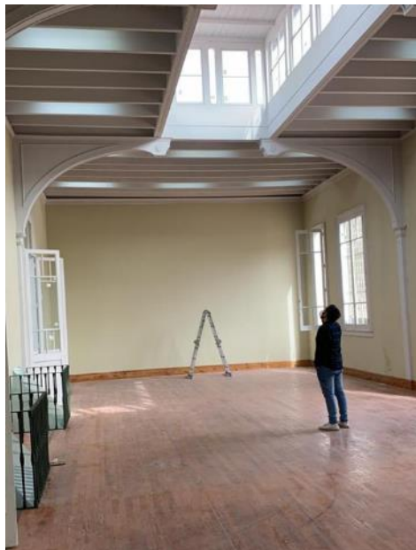
Revisión de Instalación pintura en techos
