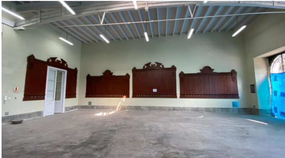
Colocación de panoplias terminadas
