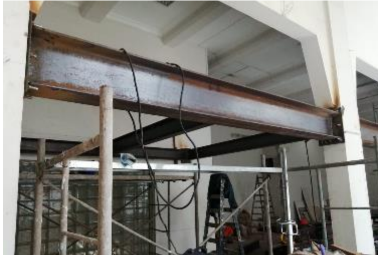
Figura 69. Instalación y Soldadura de Vigas Metálicas 2
