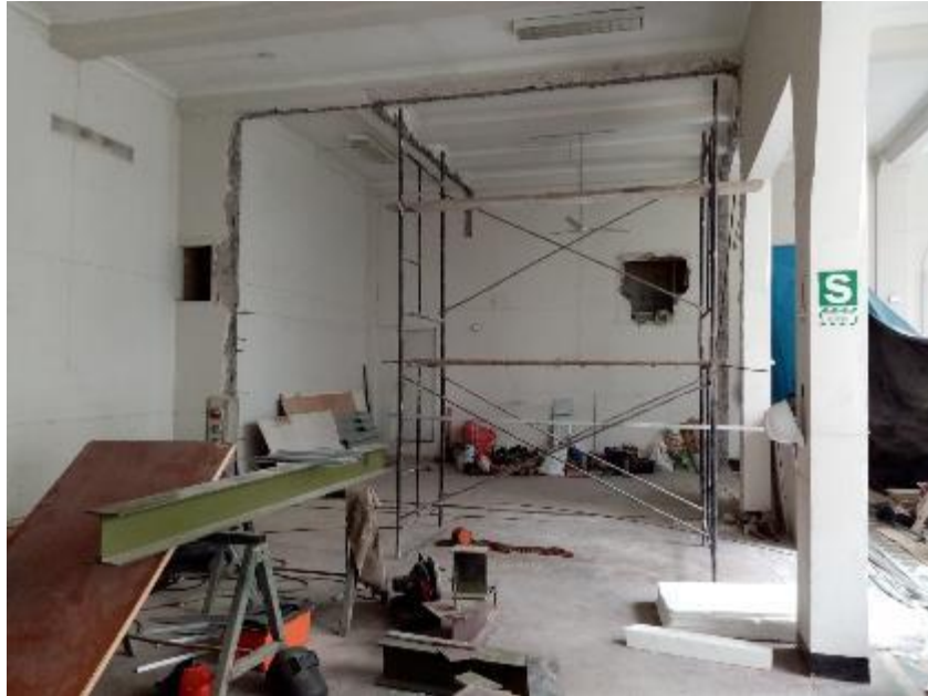
Figura 56. Demolición de muros de concreto 1
