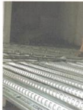
COLOCACION PLANCHA DE ACERO GAGE 22 AD-9000
