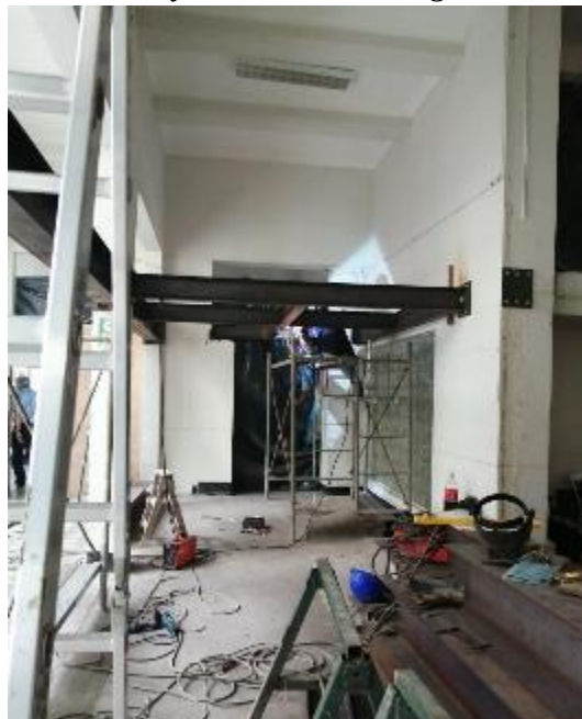
Figura 68. Instalación y Soldadura de Vigas Metálicas 1
