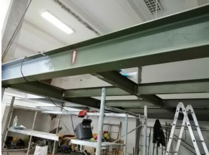
Figura 71. Aplicación de Anticorrosivo
