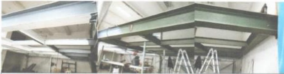
PINTADO DE VIGAS
