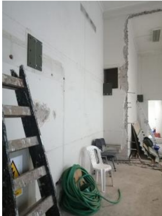
Figura 64. Colocación de soporte de Vigas Metálicas 2
