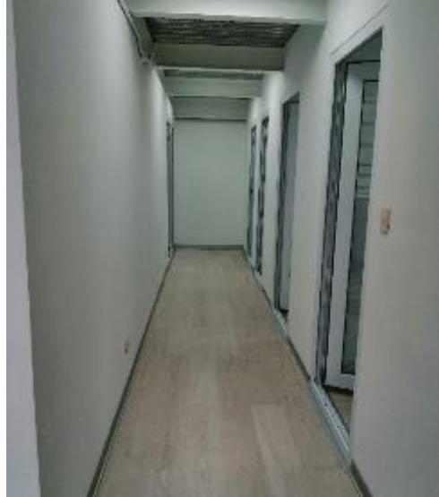
Figura 83. Acabado de Corredor del 1er Nivel
