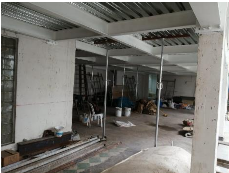
Figura 72. Pintado de Esmalte epóxica de color blanco
