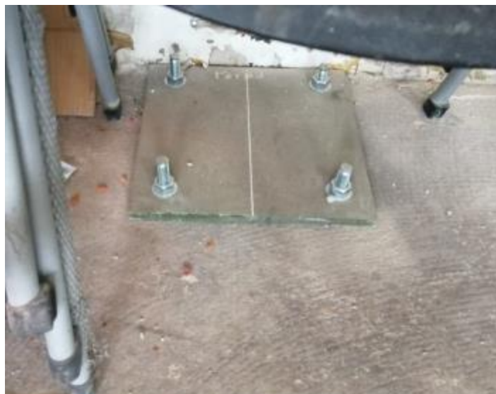
Figura 65. Colocación de Base de Columna Metálica ubicado en eje 1
