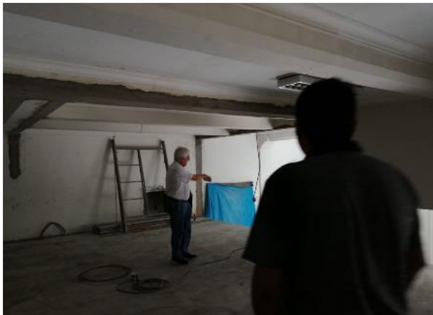
Figura 76. Inspección de Obras de Concreto
