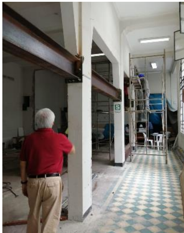
Figura 70. Inspección de Instalación de Vigas
