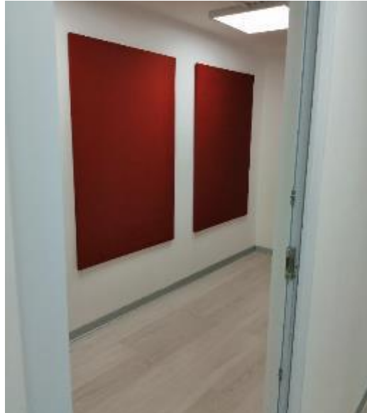
Figura 85. Colocación de Paneles Acústicos
