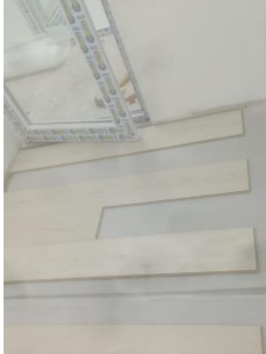
Figura 79. Instalación de Piso
