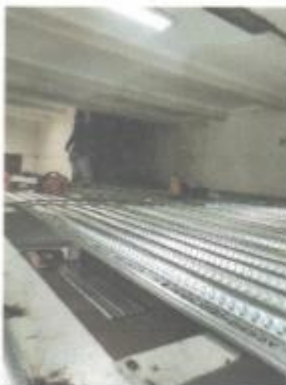
COLOCACION PLANCHA DE ACERO GAGE 22 AD-9000
