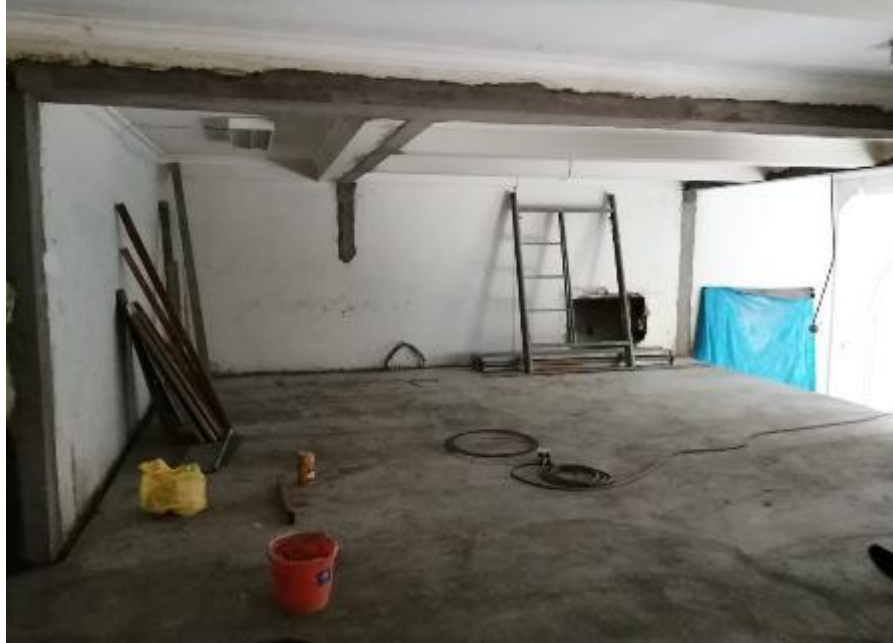
Figura 75. Obras de Concreto
