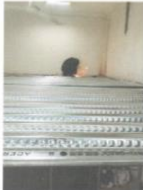
COLOCACION PLANCHA DE ACERO GAGE 22 AD-9000
