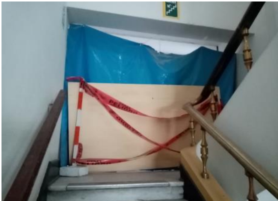
Figura 59. Escalera existente para Acceso de Mezanine
