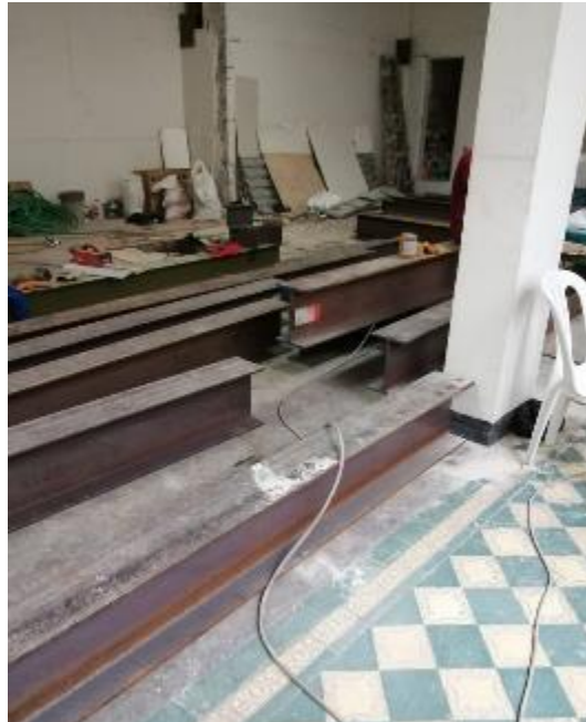
Figura 67. Traslado de material para Vigas Metálicas 2
