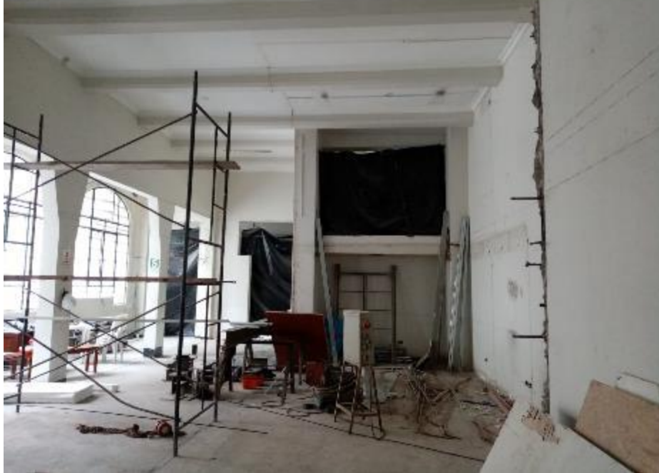
Figura 58. Colocación de andamio fijo
