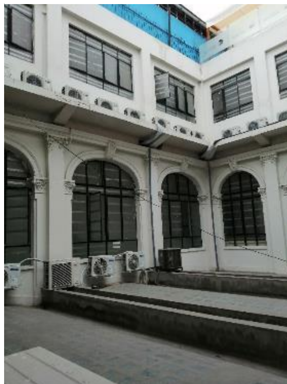
Figura 88. Ubicación de Unidades Condensadoras
