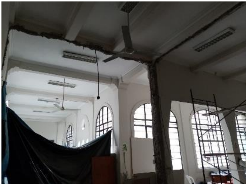
Figura 57. Demolición de muros de concreto 2
