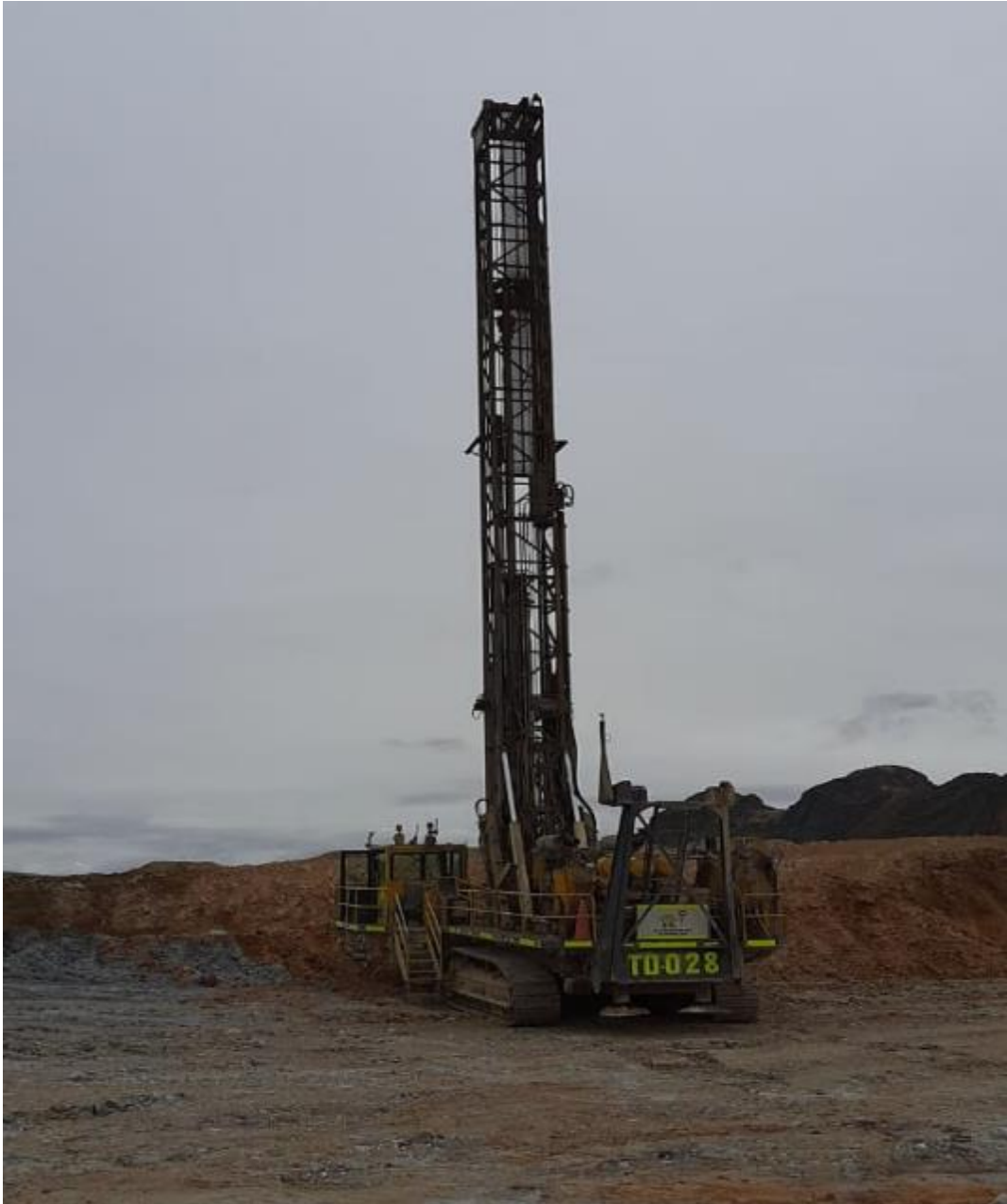
Foto 01: Perforadora DML en área de perforación.
