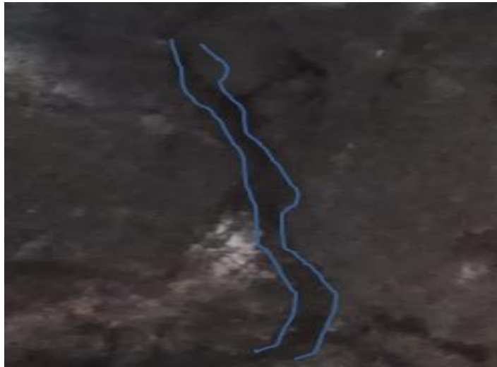
Figura 3. Abertura de la discontinuidad, mapeo geomecánico.
