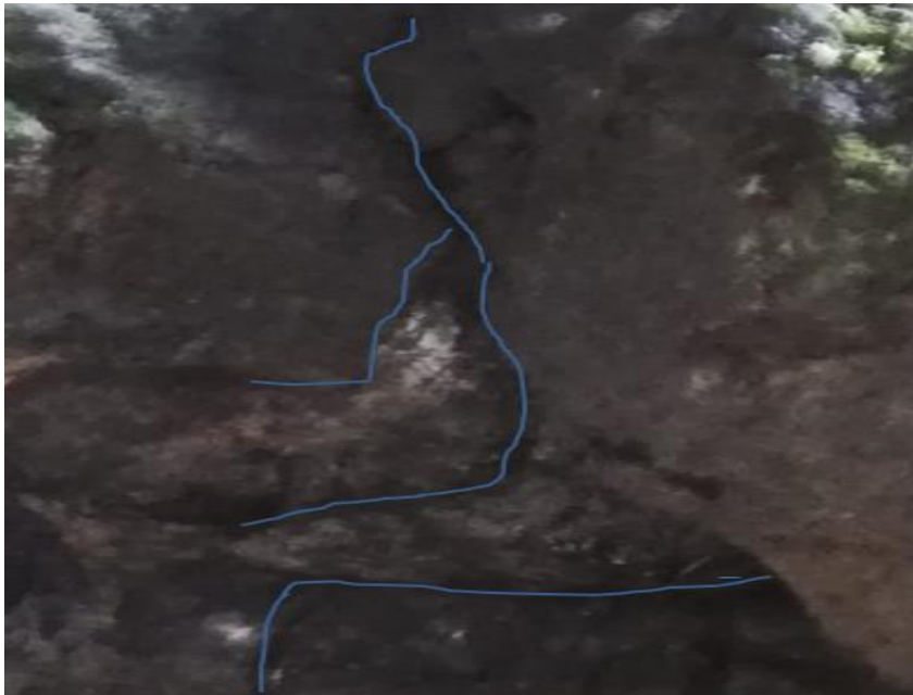
Figura 2. Persistencia de la discontinuidad, mapeo geomecánico de las galerías.
