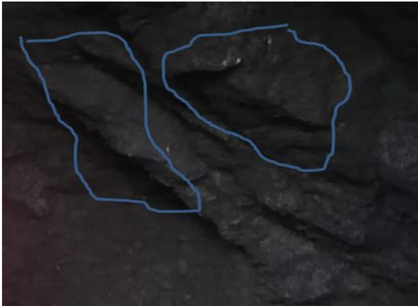
Figura 7. Presencia de agua en la discontinuidad, mapeo geomecánico de las galerías.
