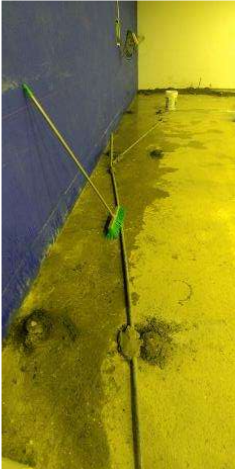
Figura 66. FOTO OBRA TEATRO - Preparación del contrapiso para vaciado de piso de cemento pulido
