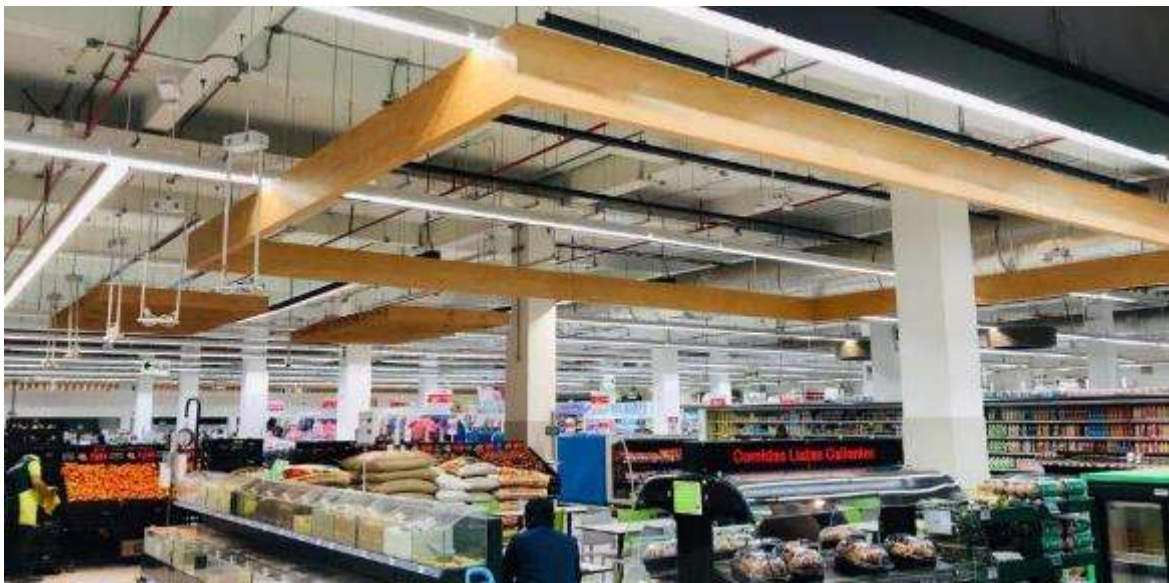
Figura 30. FOTO OBRA - Suministro e instalación cenefa tipo madera
