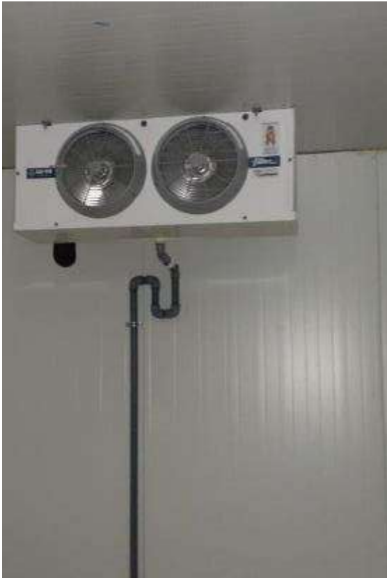
Figura 47. FOTO OBRA - Instalación de nuevos equipos condensadores en cámaras y laboratorios
