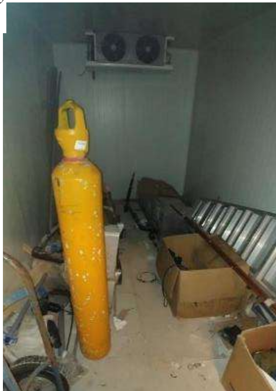
Figura 48. FOTO OBRA - Instalación de nuevos equipos condensadores en cámaras y laboratorios
