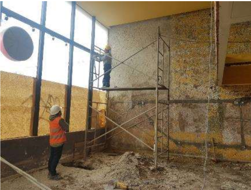
Figura 123. FOTO OBRA Tienda saludable - Retiro de revestimiento de ladrillo rococho.
