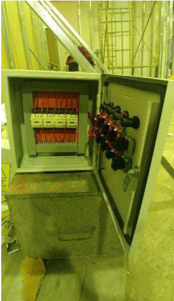
Figura 87. FOTO OBRA TEATRO - Suministro e instalación tablero estabilizado
