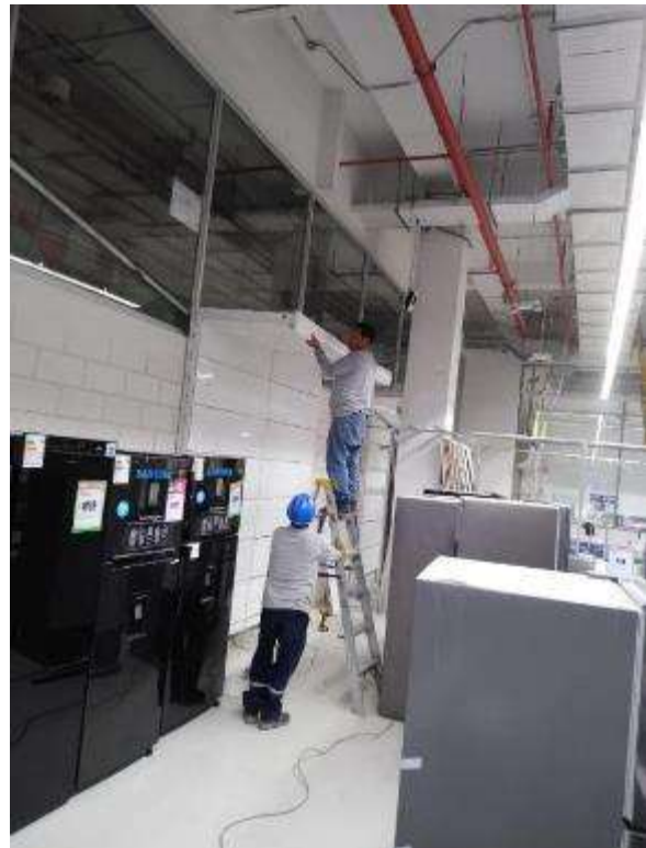
Figura 20. FOTO OBRA - Suministro e instalación de góndolas en zona de electro
