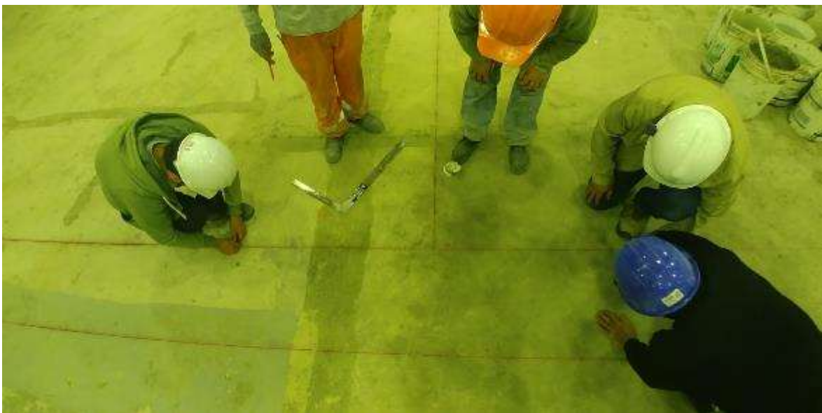
Figura 72. FOTO OBRA TEATRO - Trazado en piso según diseño de planos
