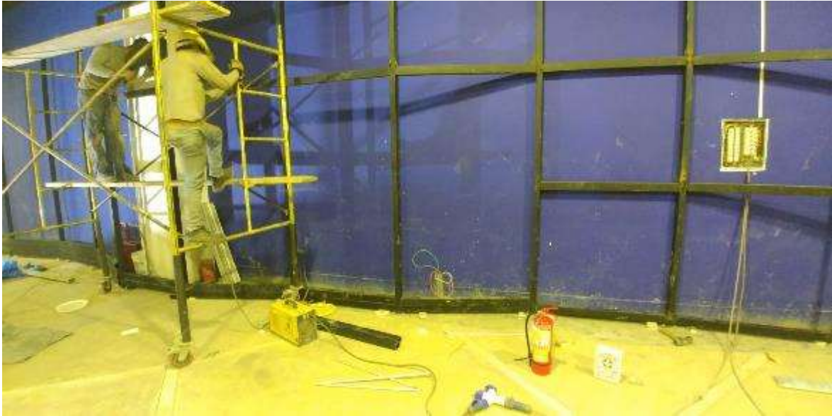
Figura 95. FOTO OBRA TEATRO - Instalación de perfilería metálica para recibir planchas de OSB
