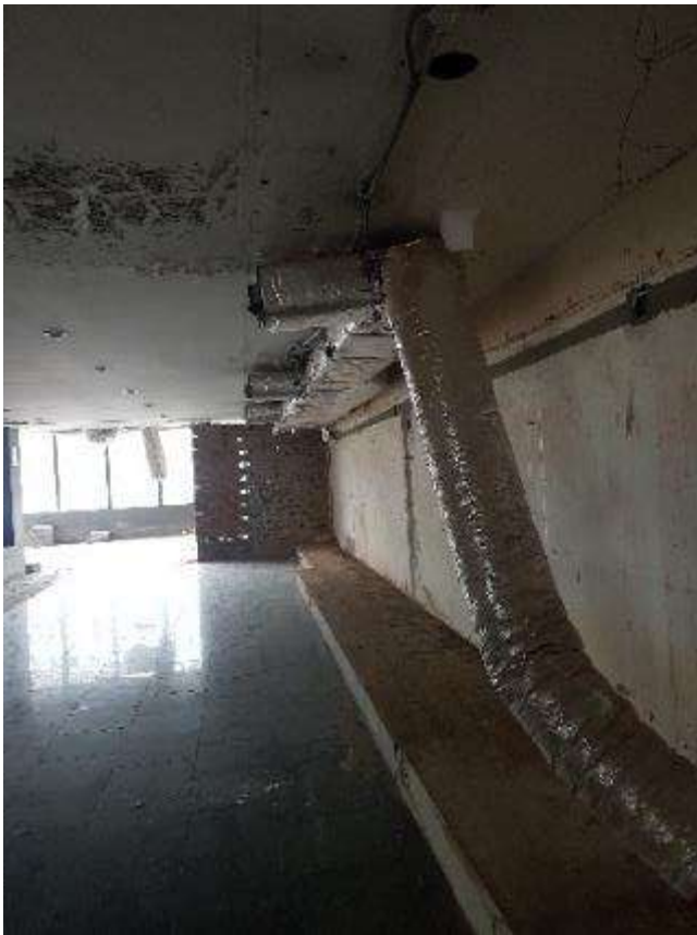
Figura 115. FOTO OBRA Tienda saludable - Retiro de ductería
