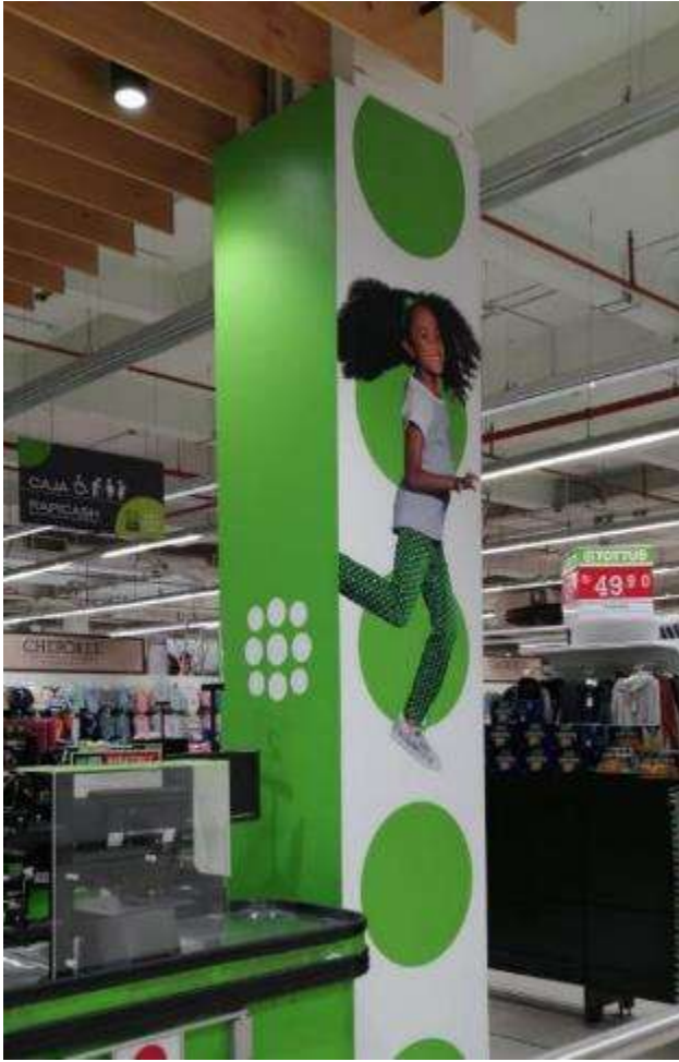
Figura 27. FOTO OBRA - Instalación vinil en muros y columnas
