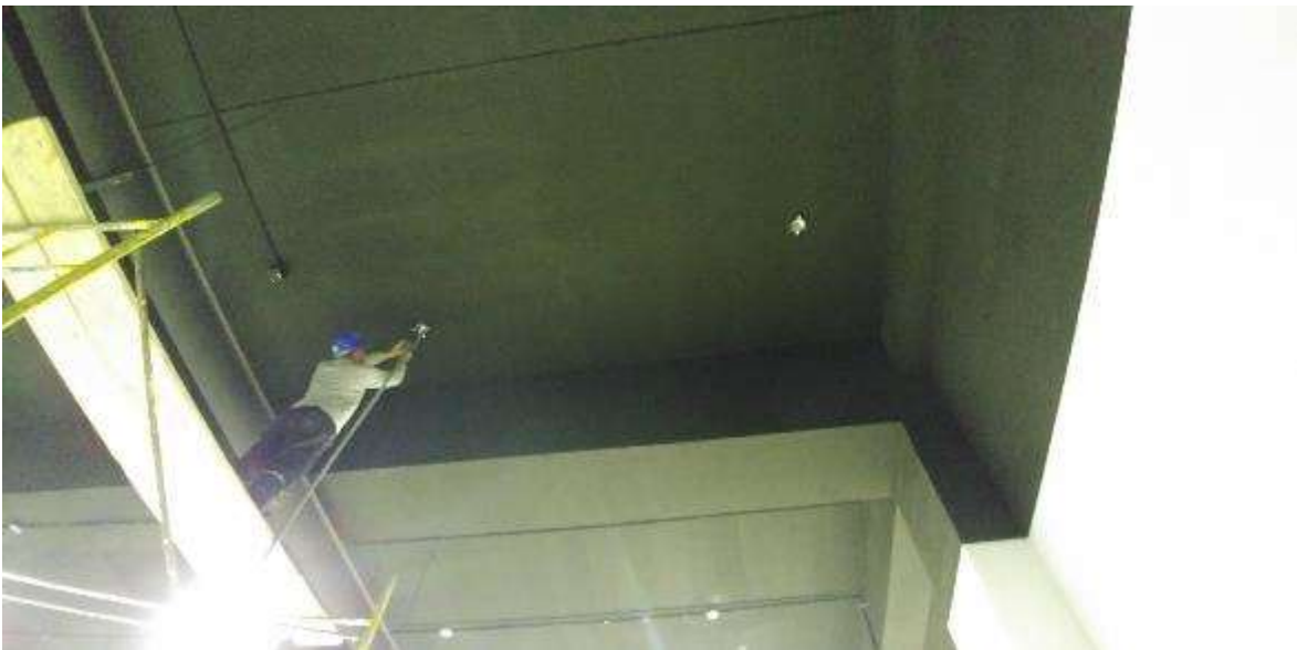
Figura 65. FOTO OBRA TEATRO - Colocación de cajas pase en losa
