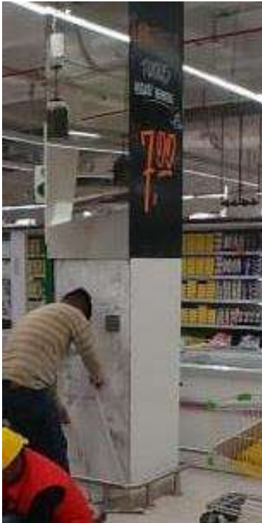
Figura 52. FOTO OBRA - Preparación, resane y pintado en muro para cambio de gabinete contra incendio
