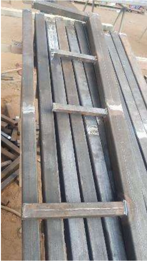
Figura 91. FOTO OBRA TEATRO - Suministro e instalación perfilería metálica para marquesina
