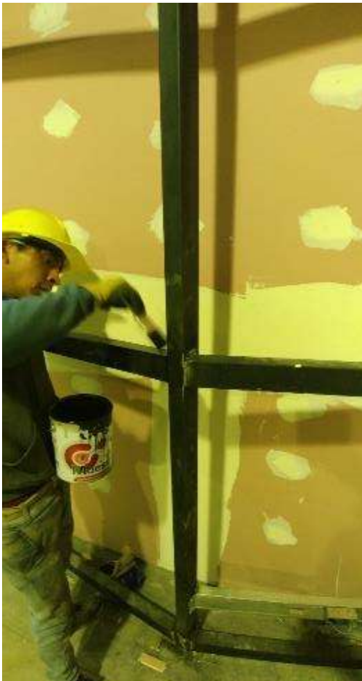
Figura 96. FOTO OBRA TEATRO - Pintado de perfilería metálica
