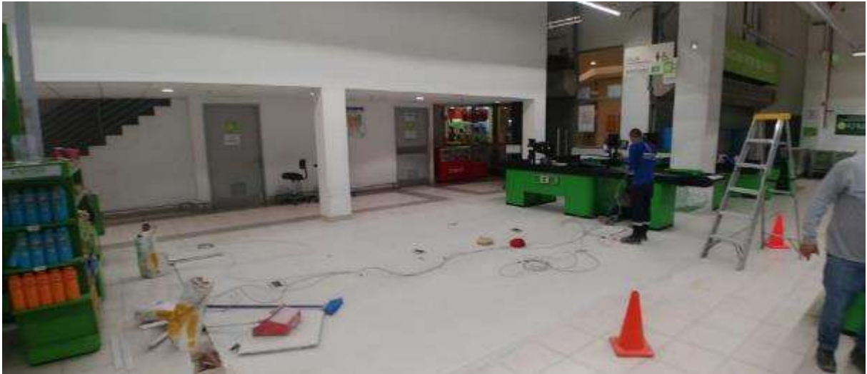
Figura 16. FOTO OBRA - Cambio de pisos en zona N°4
