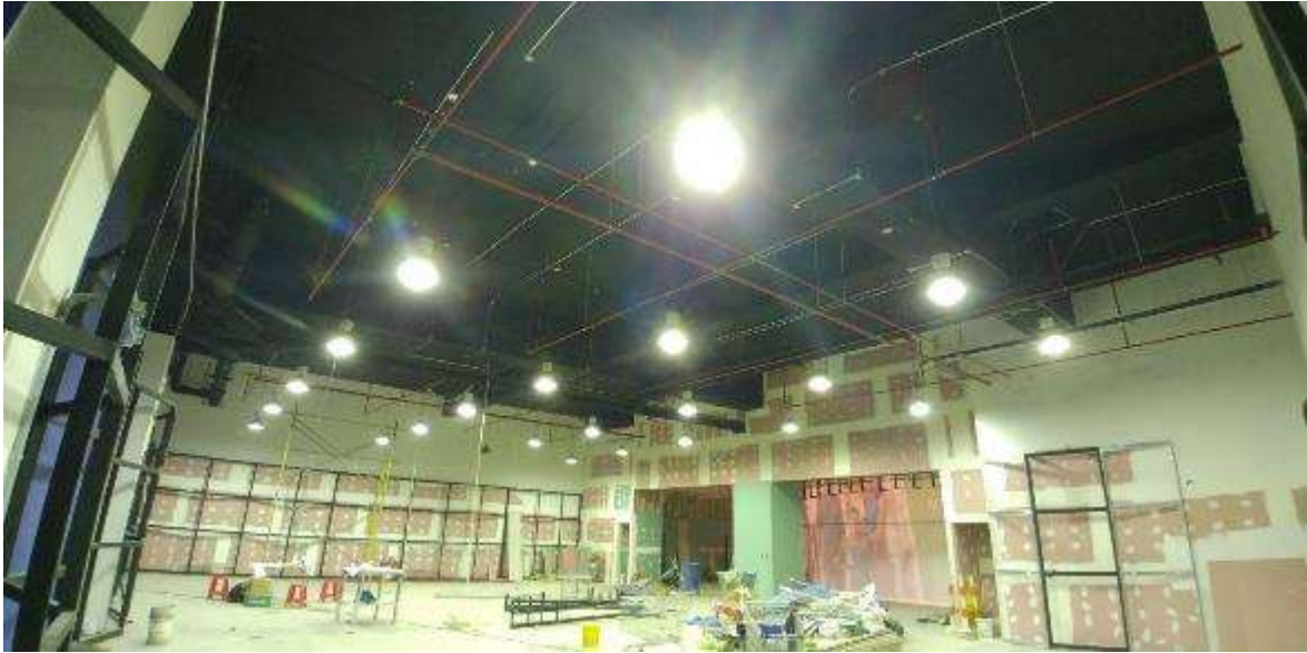
Figura 97. FOTO OBRA TEATRO - Instalación de troncales para ACI
