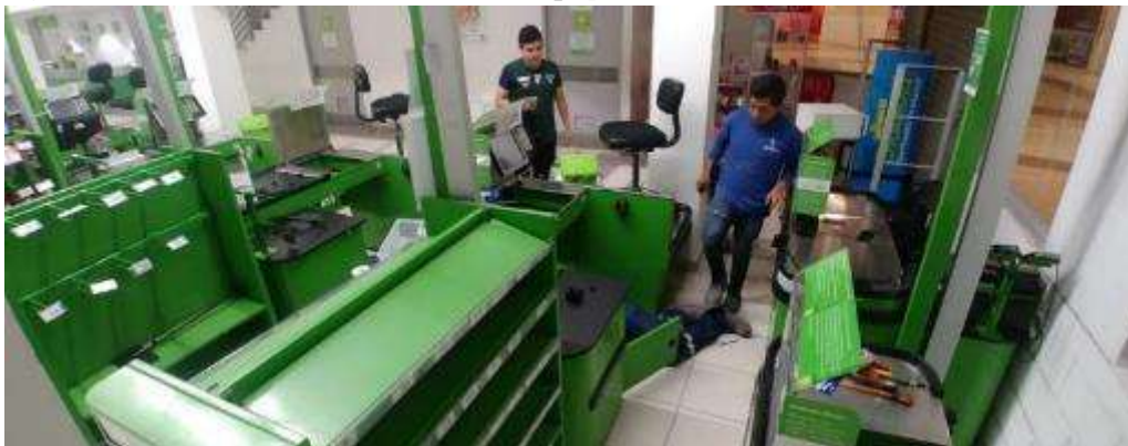
Figura 8. FOTO OBRA - Instalación de puntos eléctricos
