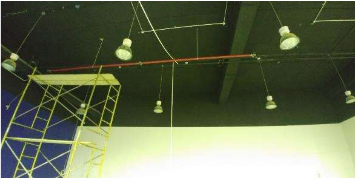
Figura 84. FOTO OBRA TEATRO - Instalación troncal ACI
