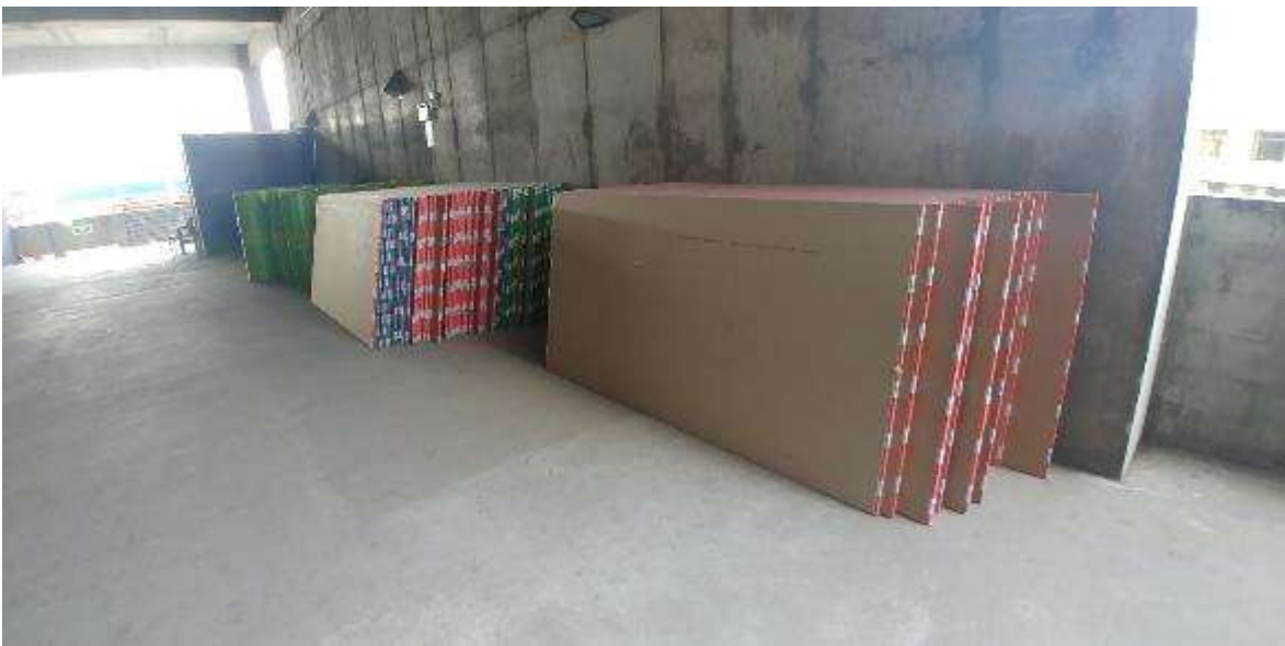
Figura 80. FOTO OBRA TEATRO - Acarreo de material drywall ST, RF y RH
