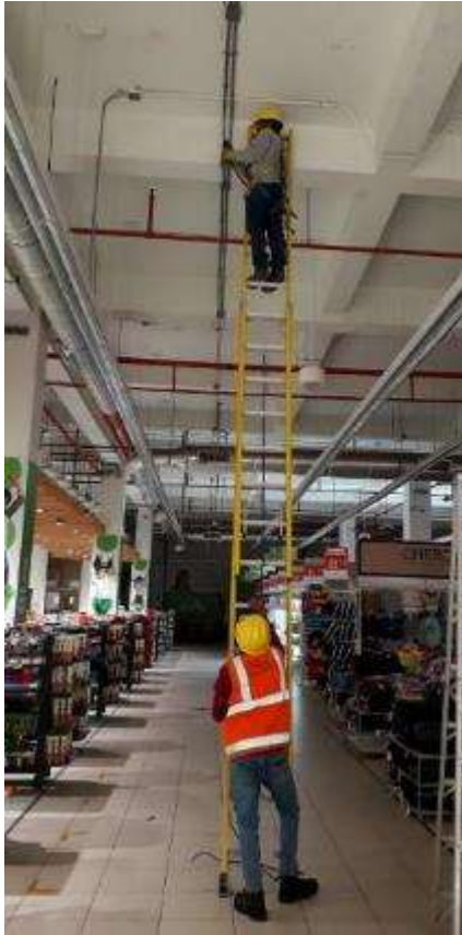
Figura 36. FOTO OBRA - Colocación señalética INDECI colgada
