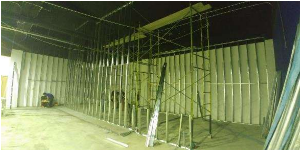
Figura 76. FOTO OBRA TEATRO - Instalación riel metálico para tabiques de drywall
