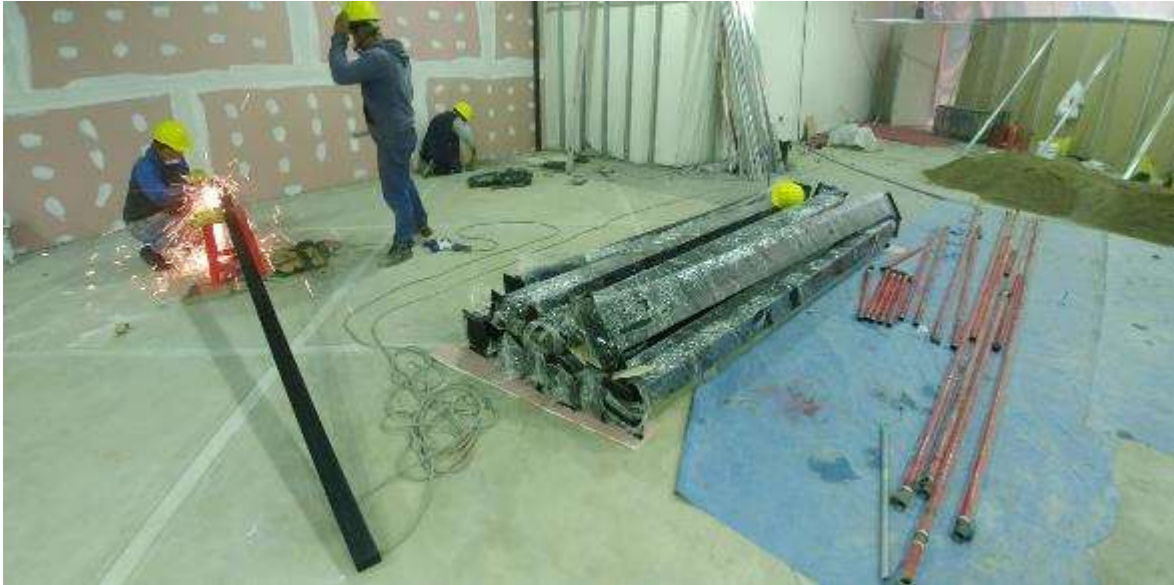
Figura 89. FOTO OBRA TEATRO - Suministro e instalación columnetas metálicas según diseño de arq.
