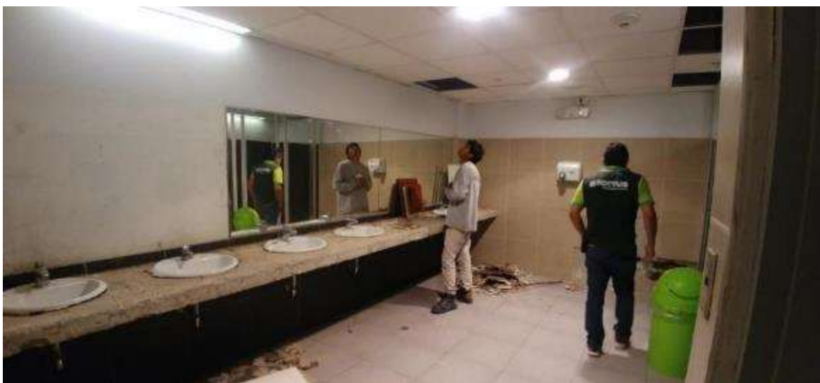
Figura 33. FOTO OBRA - Remodelación de ssh. clientes cambios de piezas en mesada y pisos
