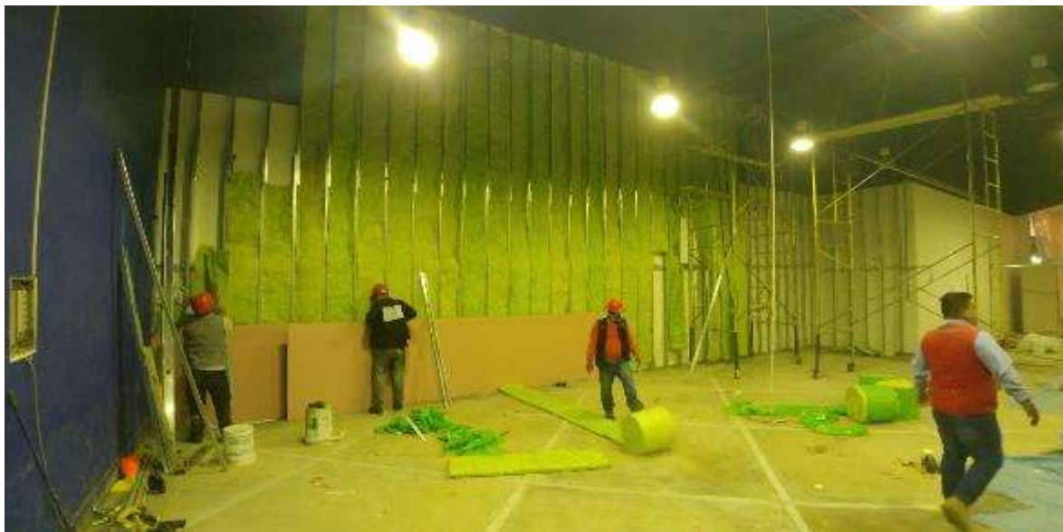
Figura 88. FOTO OBRA TEATRO - Colocación de drywall RF
