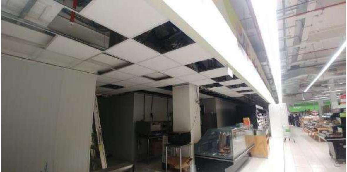
Figura 45. FOTO OBRA - Retiro de falso cielo raso dañado o deteriorado
