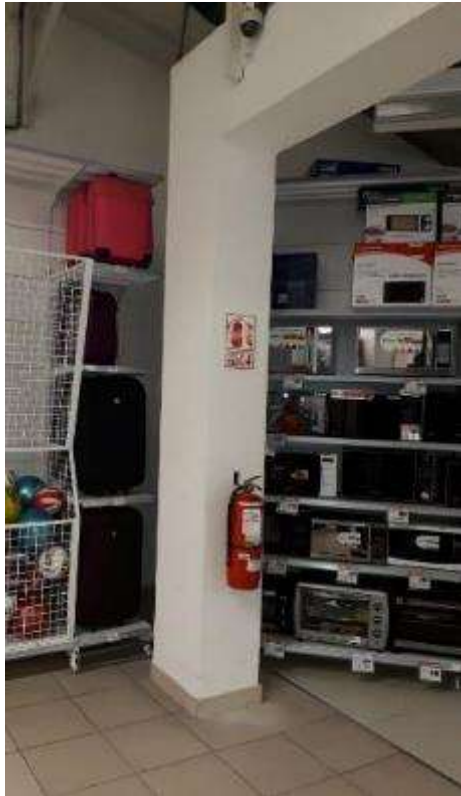
Figura 40. FOTO OBRA - Colocación señalética INDECI en columna
