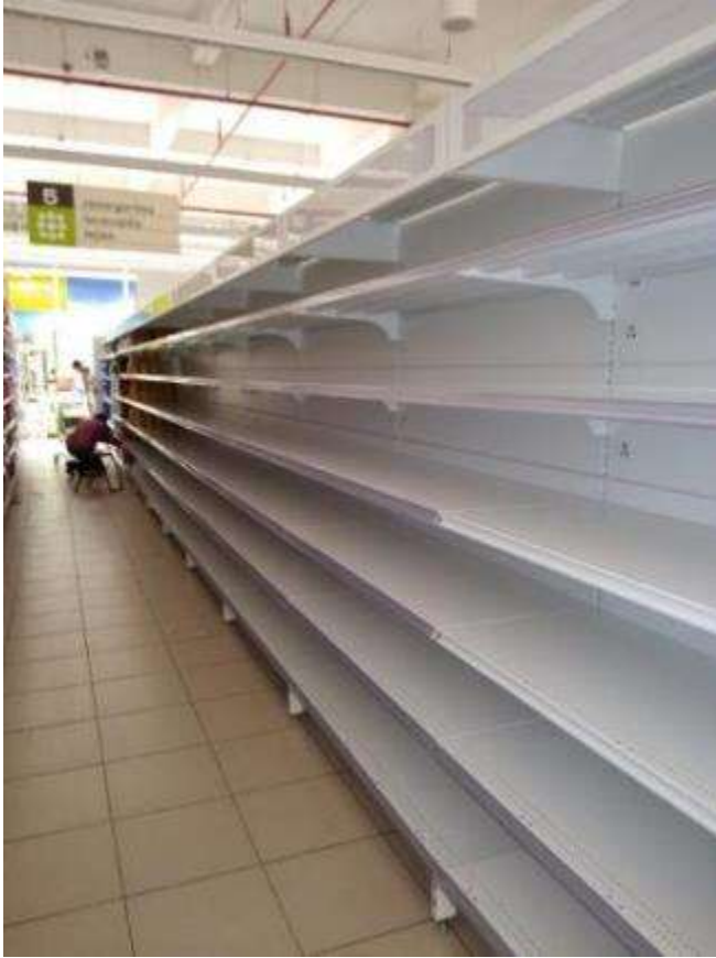
Figura 21. FOTO OBRA - Suministro e instalación góndola perfumería
