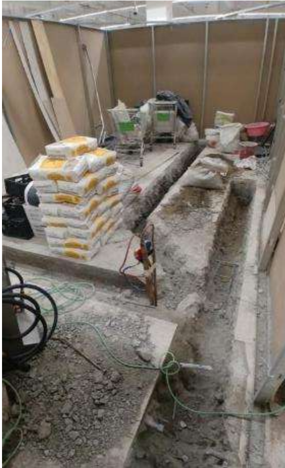
Figura 10. FOTO OBRA - Picado de piso para zanja y vaciado de poliuretano
