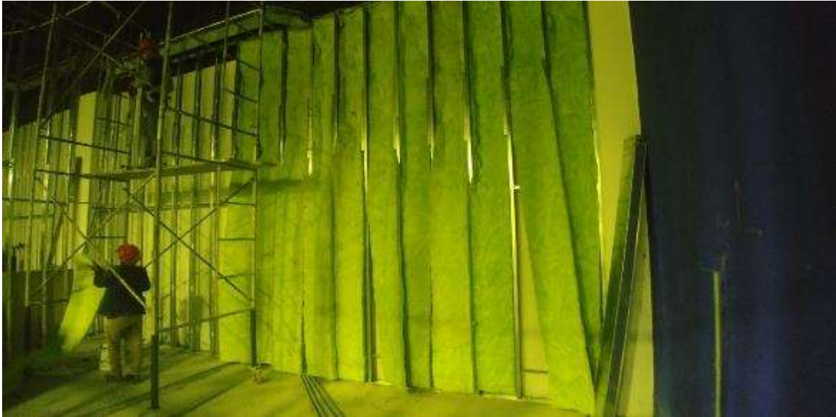
Figura 81. FOTO OBRA TEATRO - Instalación de lana de vidrio en muros de drywall RF
