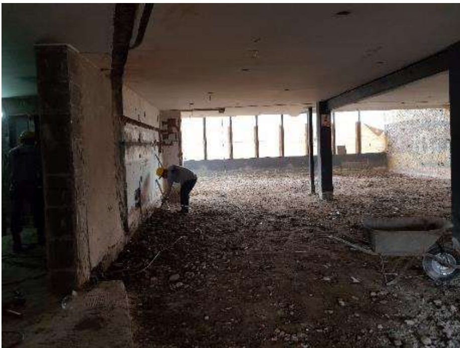
Figura 121. FOTO OBRA Tienda saludable - Eliminación de desmonte con carretilla
