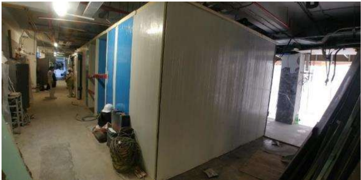
Figura 44. FOTO OBRA - Instalación de paneles en cámaras de frío
