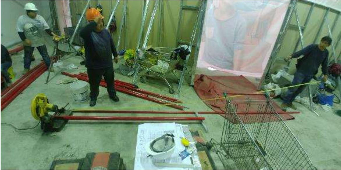
Figura 83. FOTO OBRA TEATRO - Suministro e instalación tuberías ACI
