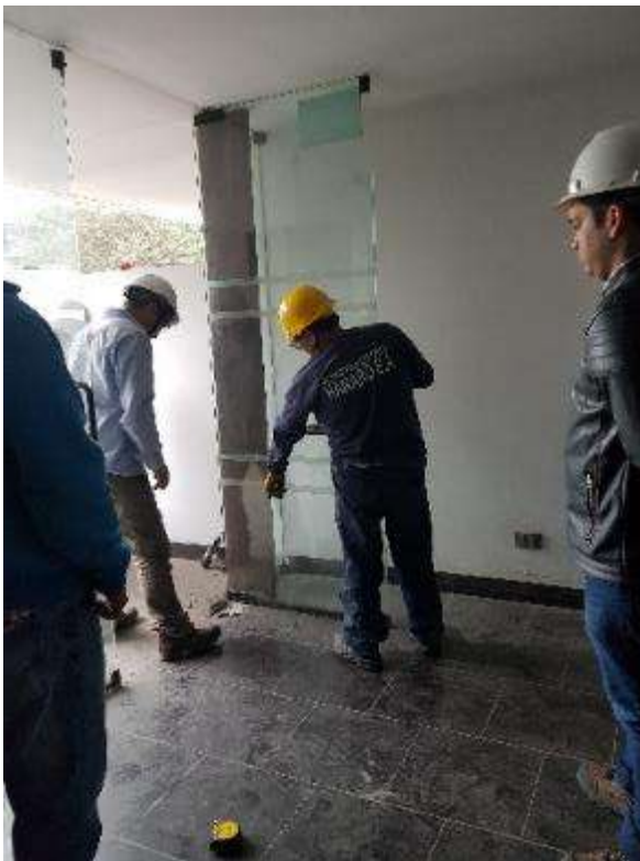
Figura 117. FOTO OBRA Tienda saludable - Desmontaje de Puertas de Vidrio
