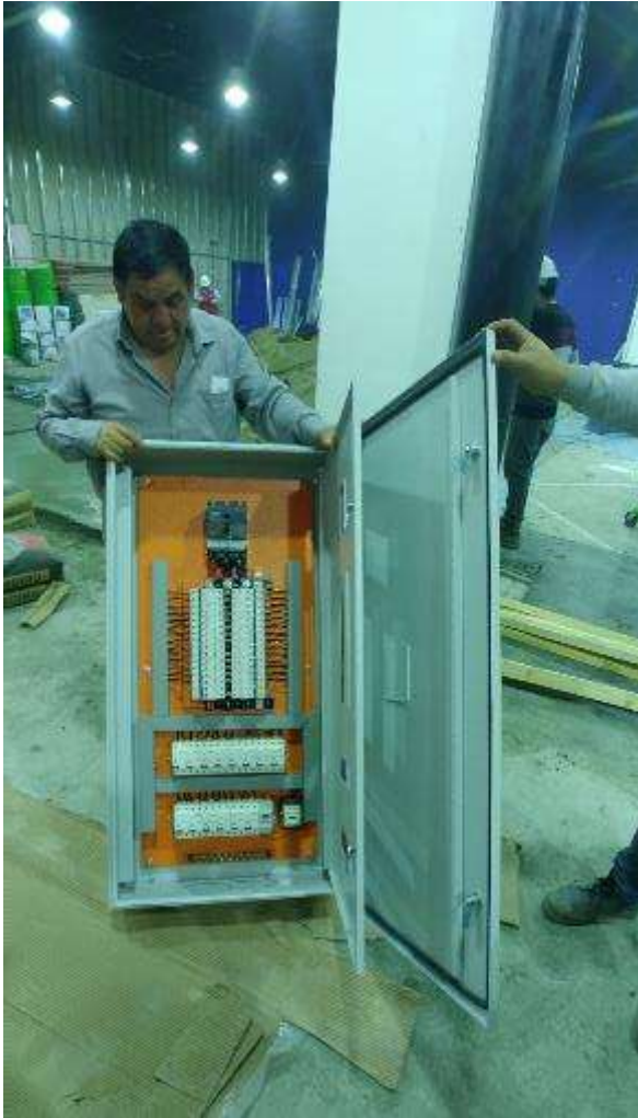
Figura 86. FOTO OBRA TEATRO - Suministro e instalación de tablero general eléctrico
