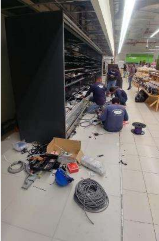
Figura 12. FOTO OBRA - Suministro e instalación de mural
