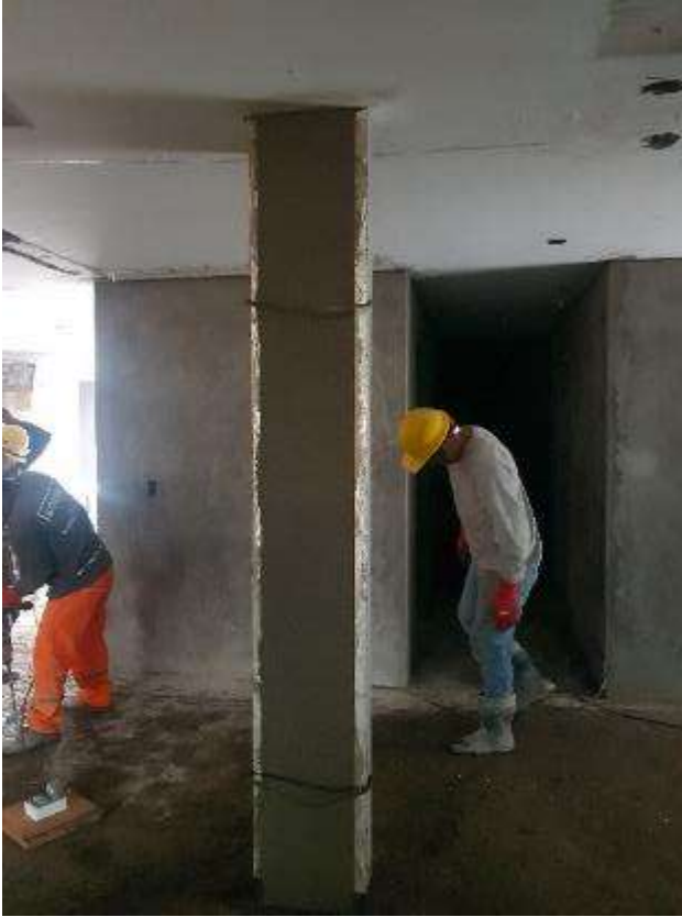
Figura 128. FOTO OBRA Tienda saludable - Tarrajeo de columnas
