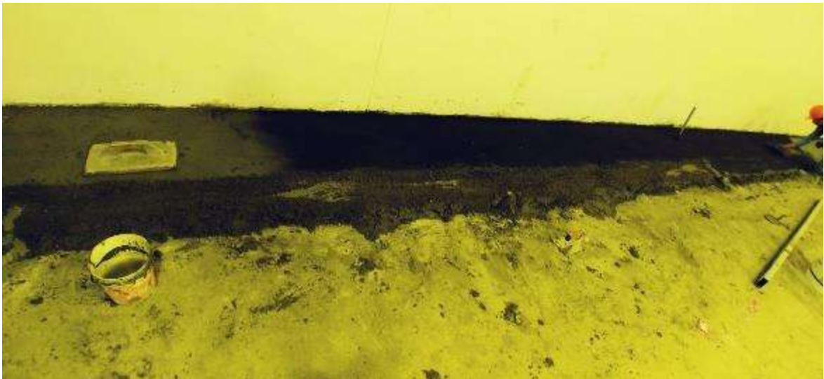
Figura 69. FOTO OBRA TEATRO - Colocación de ocre color negro
