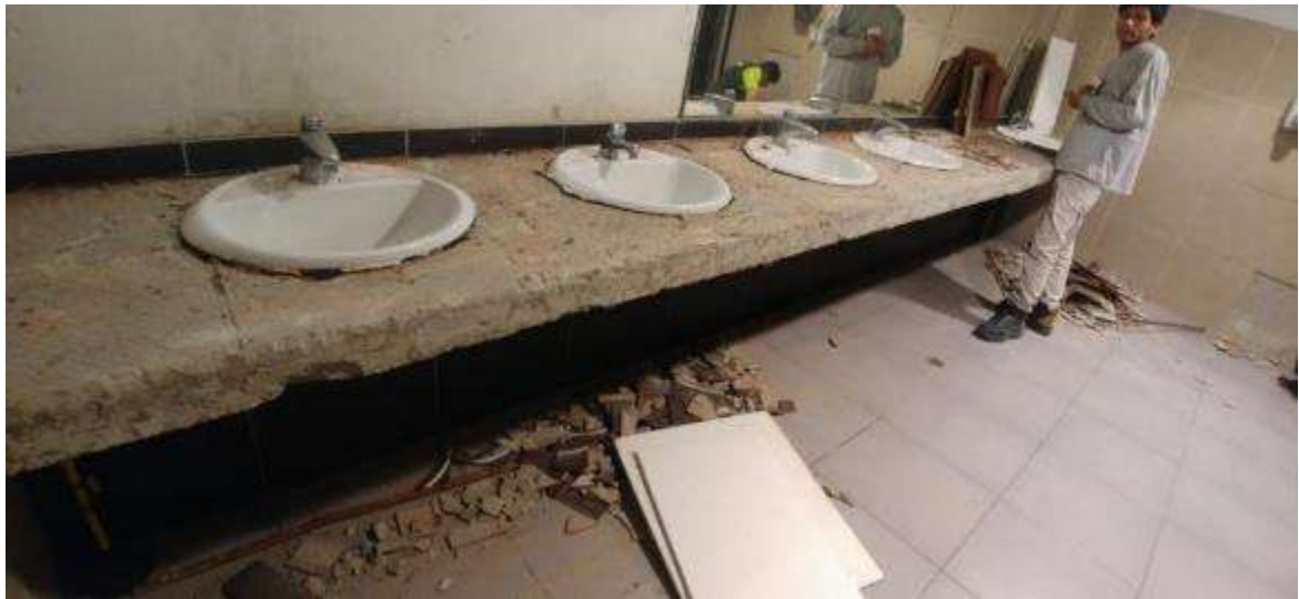
Figura 32. FOTO OBRA - Cambio de piezas en ssh clientes
