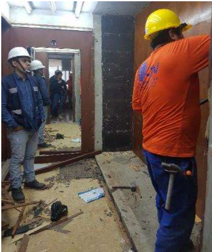
Figura 119. FOTO OBRA Tienda saludable - Desmontaje de carpintería de madera – closet
