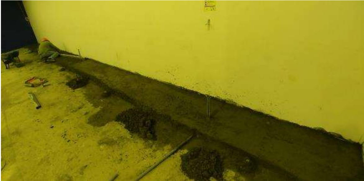
Figura 70. FOTO OBRA TEATRO - Vaciado de piso
