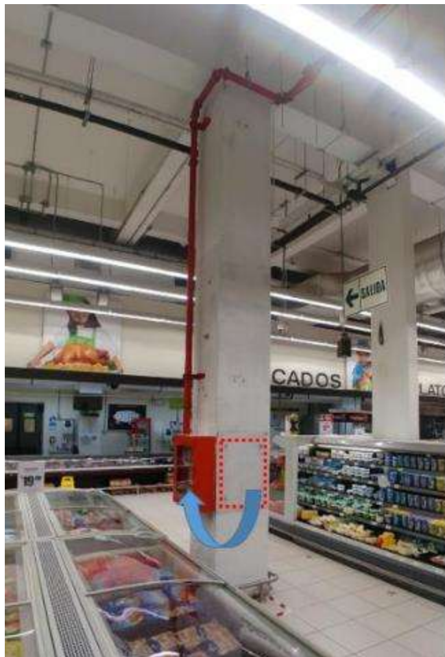
Figura 51. FOTO OBRA - Cambio de gabinete contra incendio
