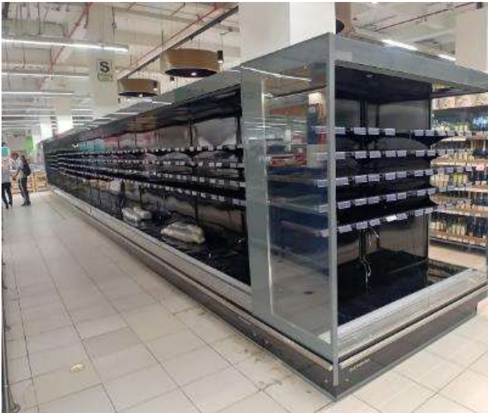
Figura 13. FOTO OBRA - Suministro e instalación de mural congelados (implica obra civil)
