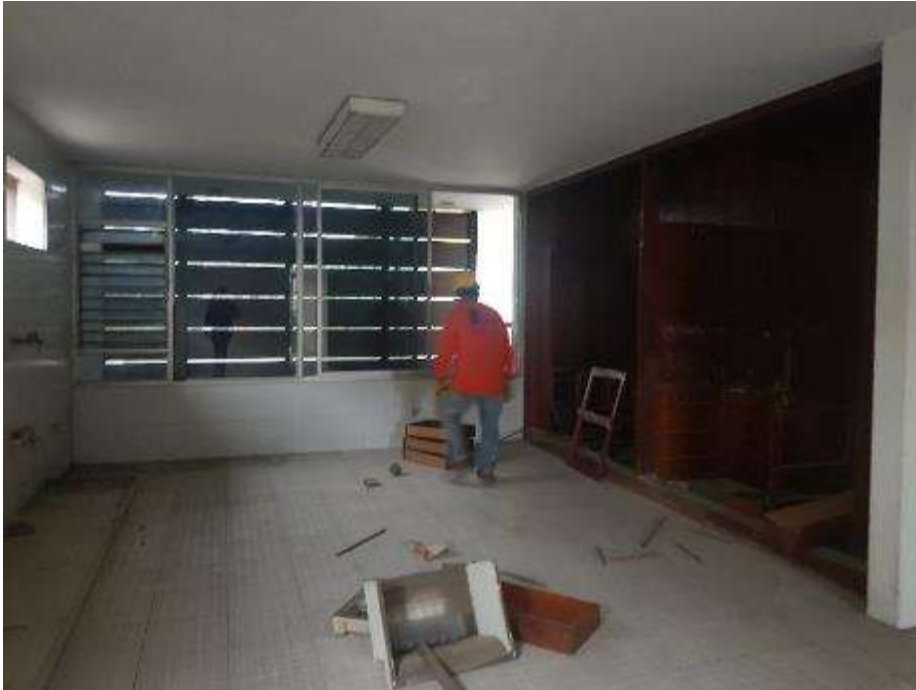
Figura 120. FOTO OBRA Tienda saludable - Desmontaje de closet
