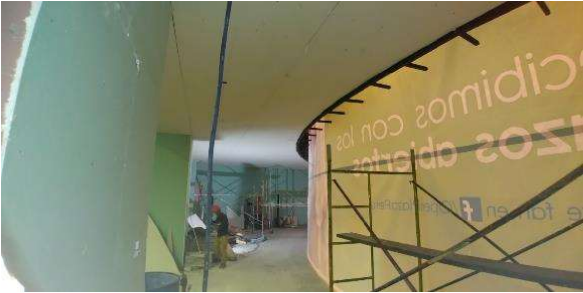
Figura 101. FOTO OBRA TEATRO - Suministro e instalación de FCR de drywall
