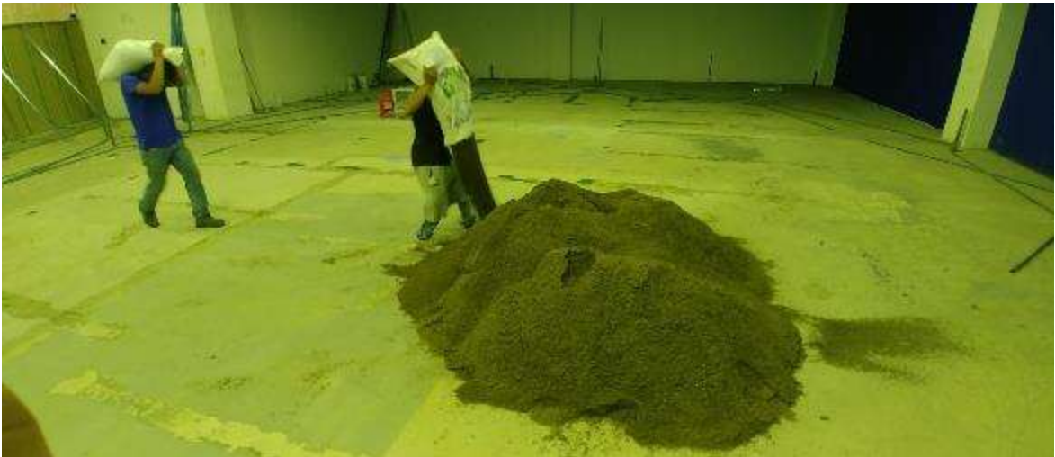
Figura 59. FOTO OBRA TEATRO - Acarreo de material
