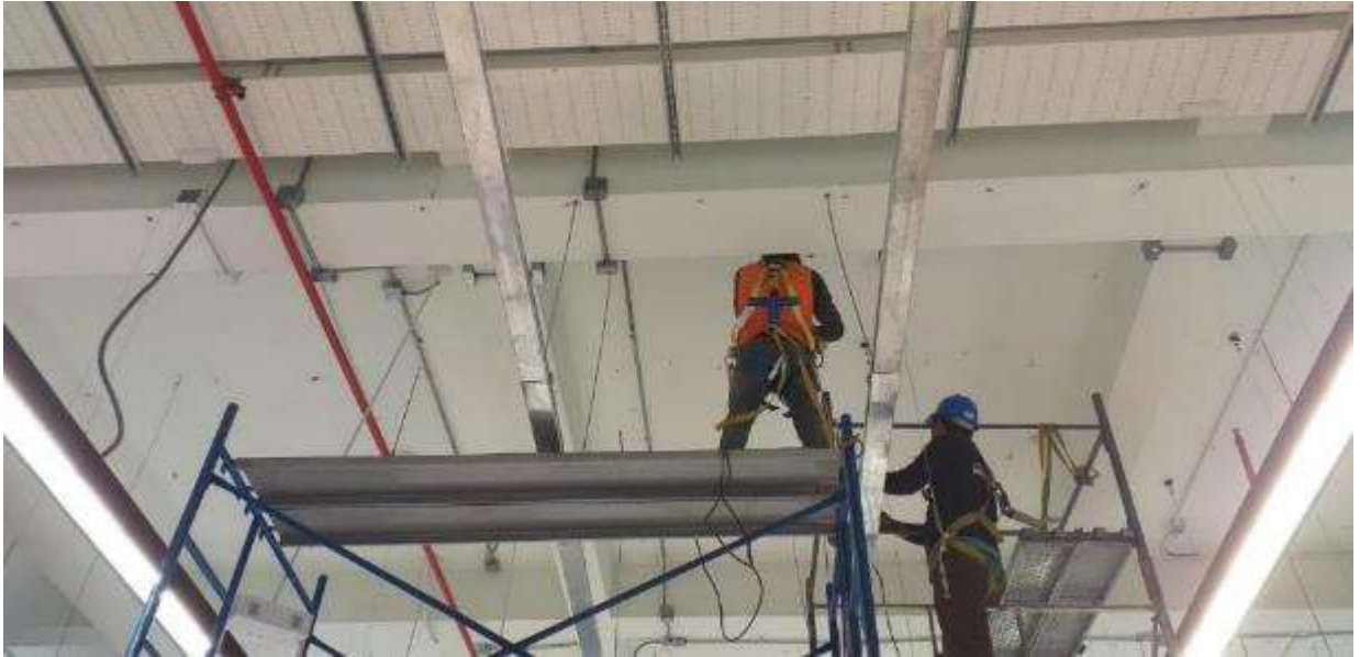
Figura 17. FOTO OBRA - Instalación tubería y cajas de pase IIEE
