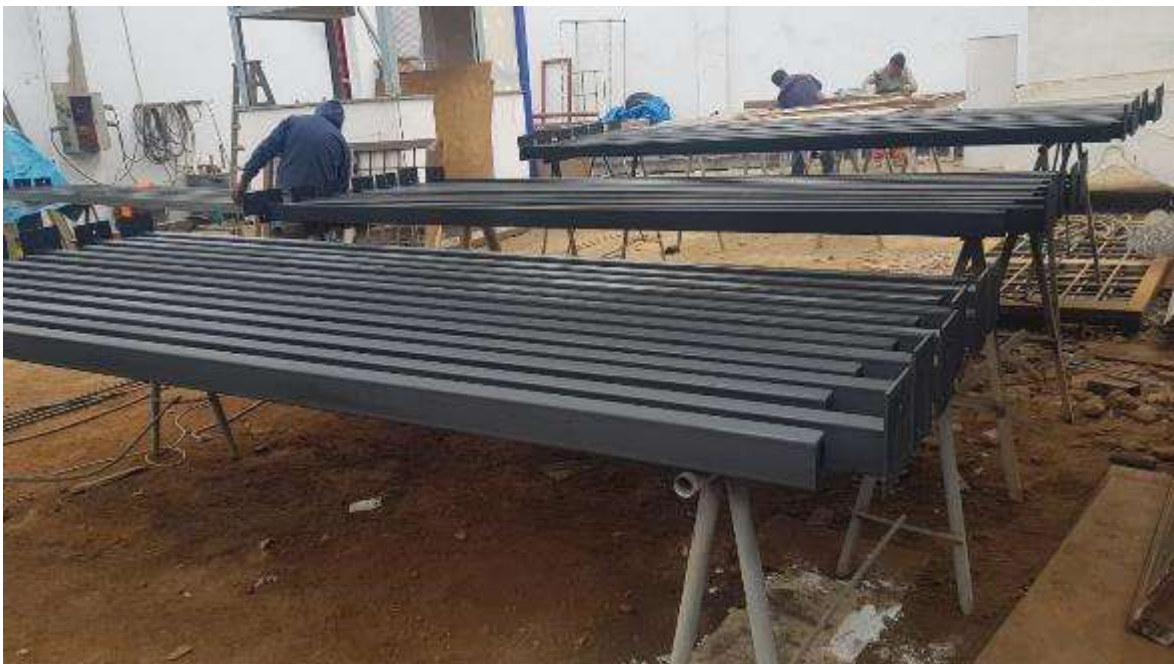
Figura 78. FOTO OBRA TEATRO - Pintado de columnas metálicas
