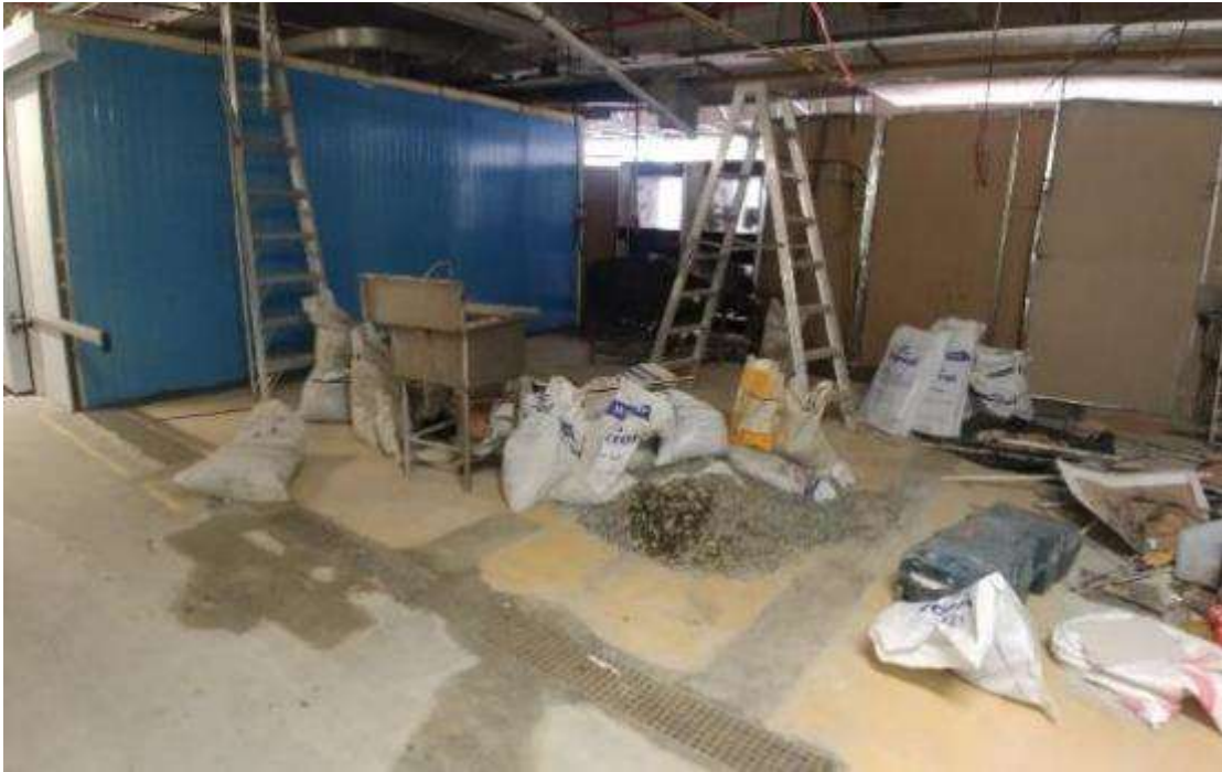
Figura 42. FOTO OBRA - Obra civil en cámaras de frío
