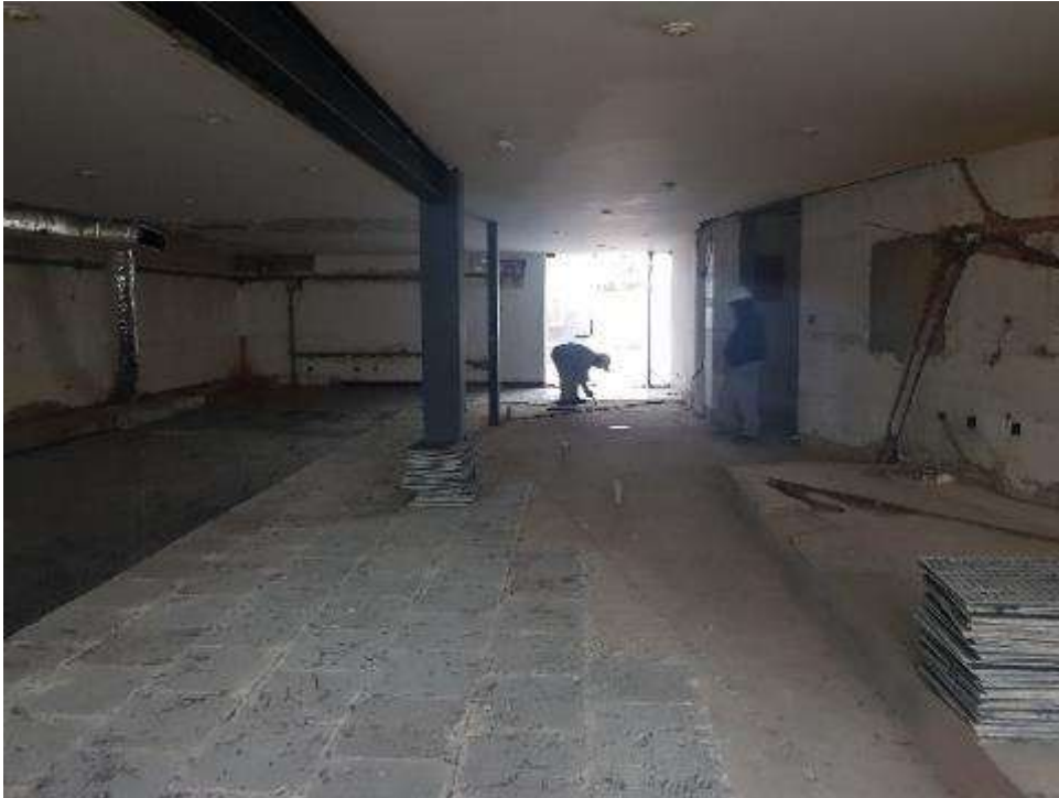
Figura 114. FOTO OBRA Tienda saludable - Retiro de enchape de piso
