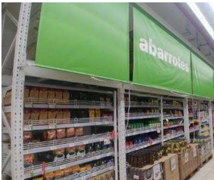
Figura 26. FOTO OBRA - Suministro e instalación de rollers en góndolas perimetrales
