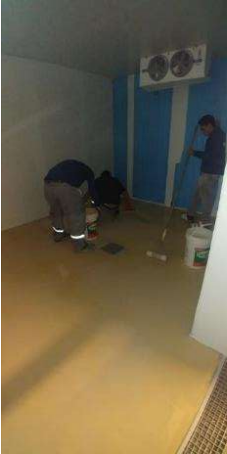
Figura 43. FOTO OBRA - preparado piso poliuretano en cámaras de frío
