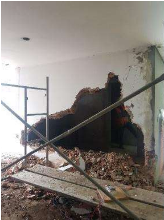
Figura 127. FOTO OBRA Tienda saludable - Demolición de muros
