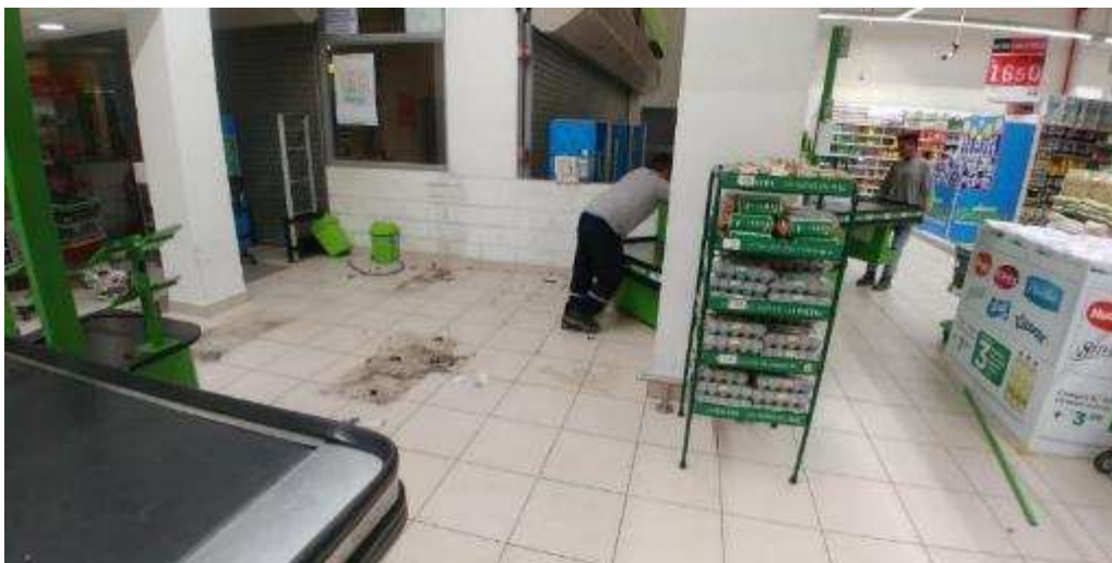
Figura 7. FOTO OBRA - Movimiento de equipamiento existente
