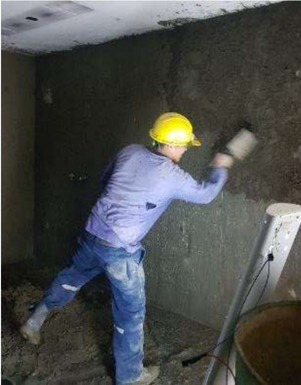
Figura 122. FOTO OBRA Tienda saludable - Tarrajeo de muros – 1° piso – zona de vitrinas.
