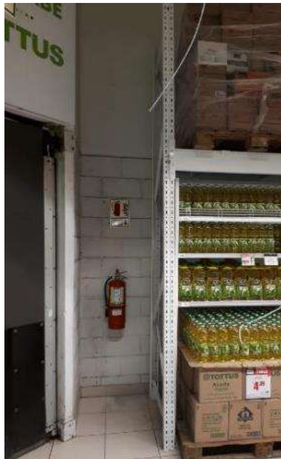
Figura 39. FOTO OBRA - Colocación señalética INDECI en muros perimetrales
