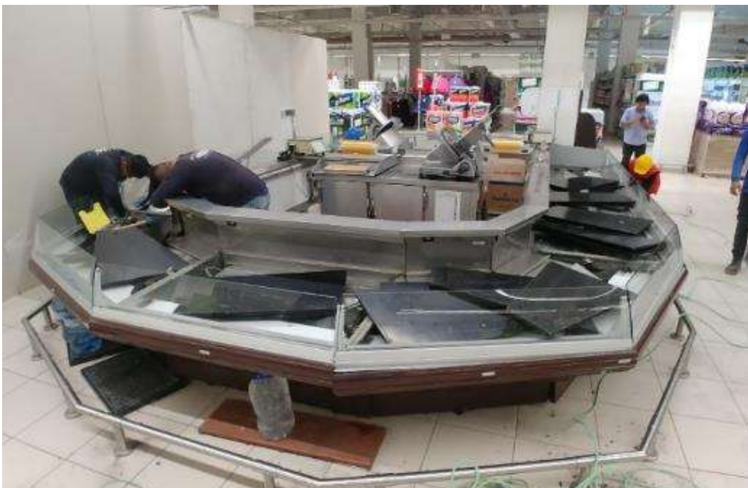
Figura 11. FOTO OBRA - Desmontaje y retiro de piezas. Para retirar isla de fiambres
