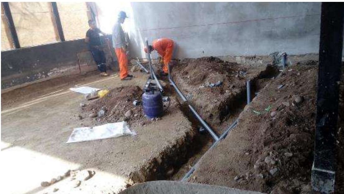
Figura 131. FOTO OBRA Tienda saludable - Excavación y entubado IISS – DESAGUE
