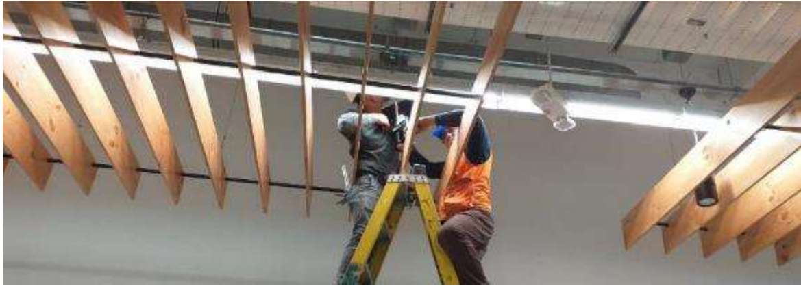
Figura 29. FOTO OBRA - Suministro e instalación tensores estructurales
