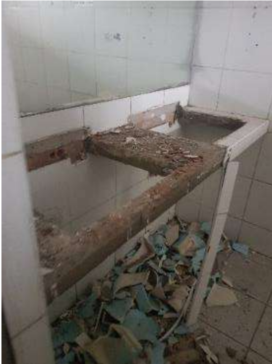
Figura 116. FOTO OBRA Tienda saludable - Retiro de enchape en pared – Baños
