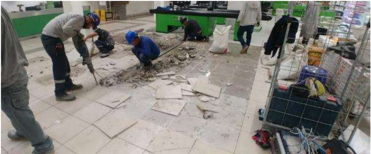
Figura 15. FOTO OBRA - Picado y cambio de piso en zona checks outs
