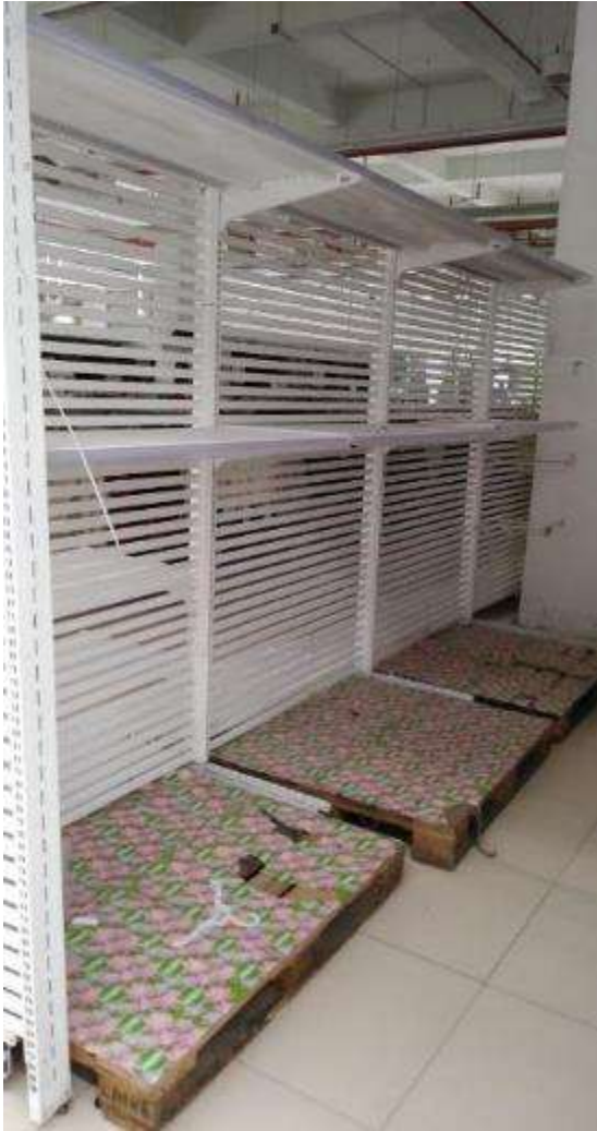
Figura 19. FOTO OBRA - Suministro e instalación de góndolas en nueva zona
