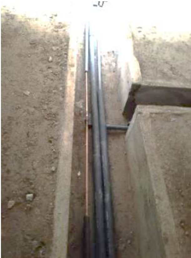
Figura 130. FOTO OBRA Tienda saludable - Tarrajeo en trincheras para ductería sistema de frío
