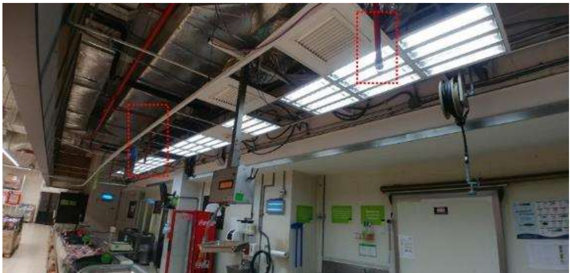
Figura 50. FOTO OBRA - Reubicación de troncales tuberías de ACI
