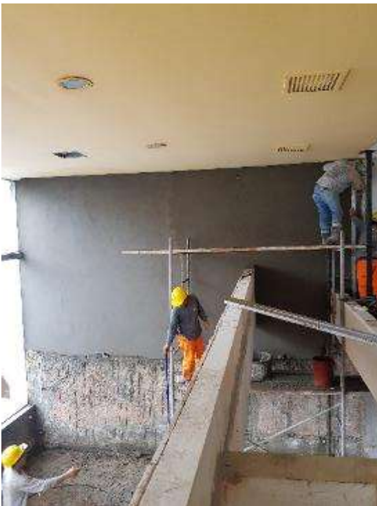
Figura 129. FOTO OBRA Tienda saludable - Tarrajeo de muro
