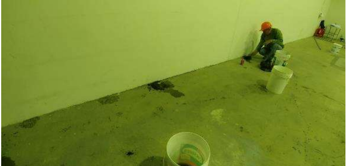
Figura 63. FOTO OBRA TEATRO - Colocación de tacos provisionales para nivelación de piso
