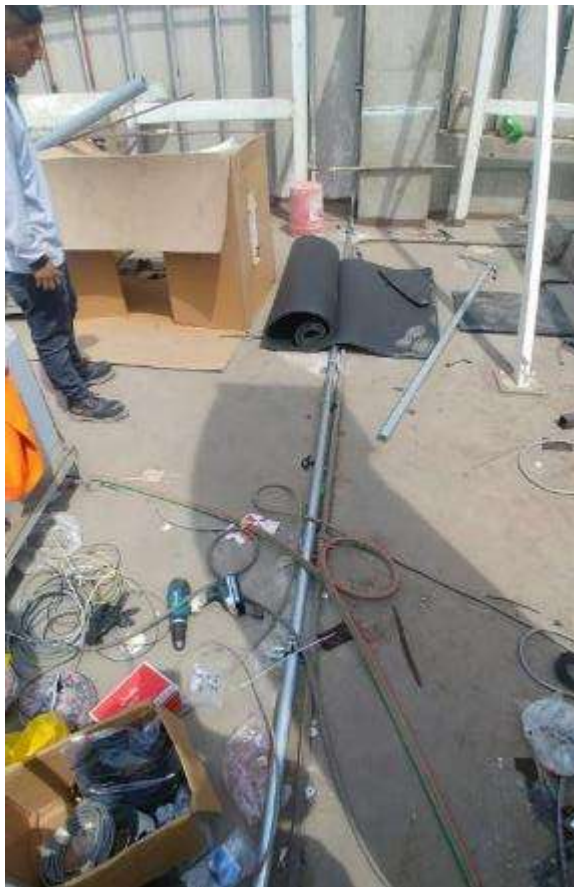
Figura 24. FOTO OBRA - Entubado para canalizado eléctrico
