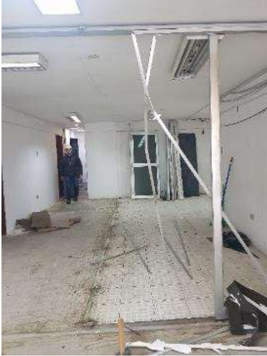
Figura 118. FOTO OBRA Tienda saludable - Desmontaje de carpintería de aluminio
