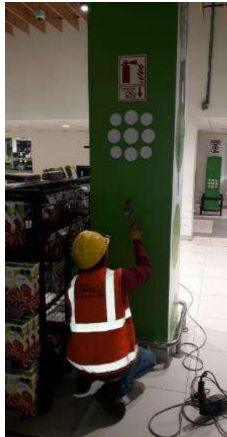
Figura 37. FOTO OBRA - Colocación señalética INDECI en columna
