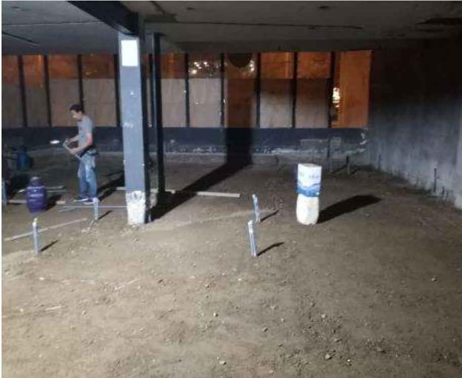
Figura 132. FOTO OBRA Tienda saludable - Entubado de IIEE en sala de ventas
