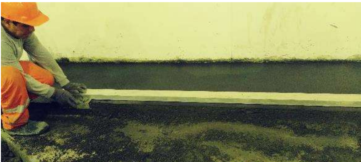
Figura 68. FOTO OBRA TEATRO - Nivelación piso
