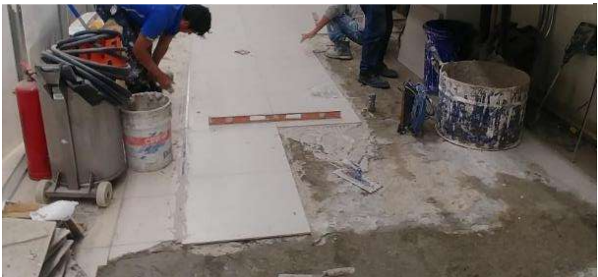
Figura 14. FOTO OBRA - Picado y cambio de piso en zona "frontal"
