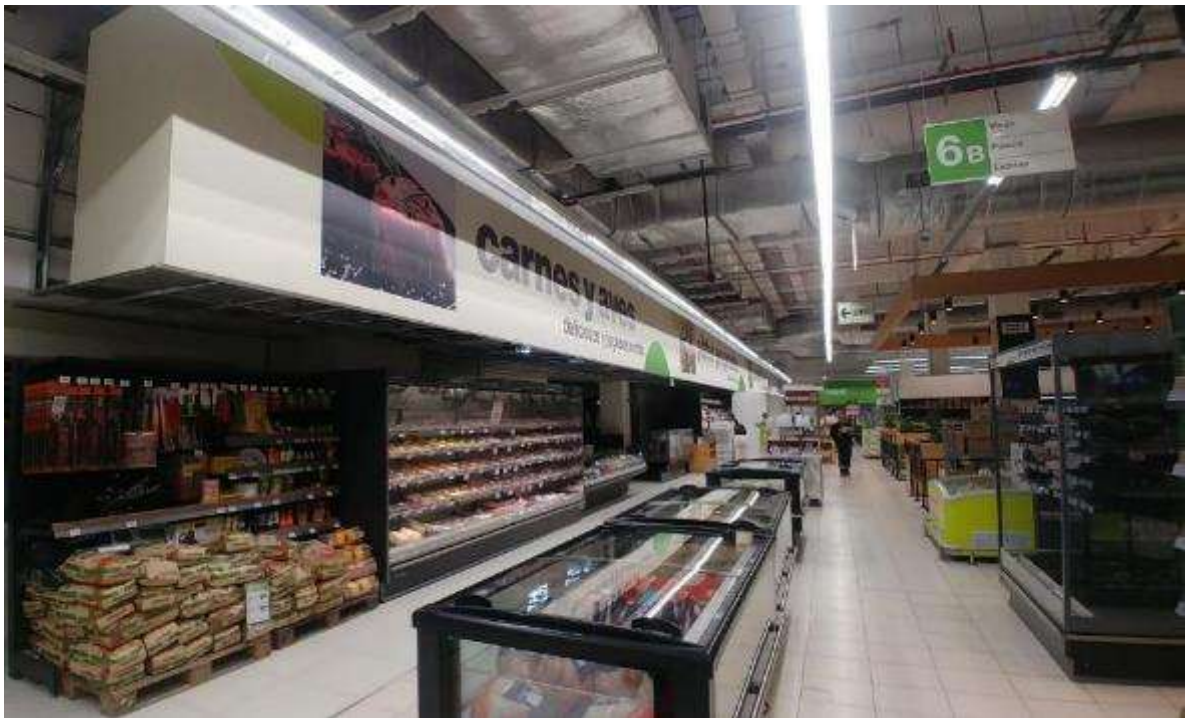
Figura 46. FOTO OBRA - Cambio y mejoramiento de todo el frontal, fcr, pintura y vinil
