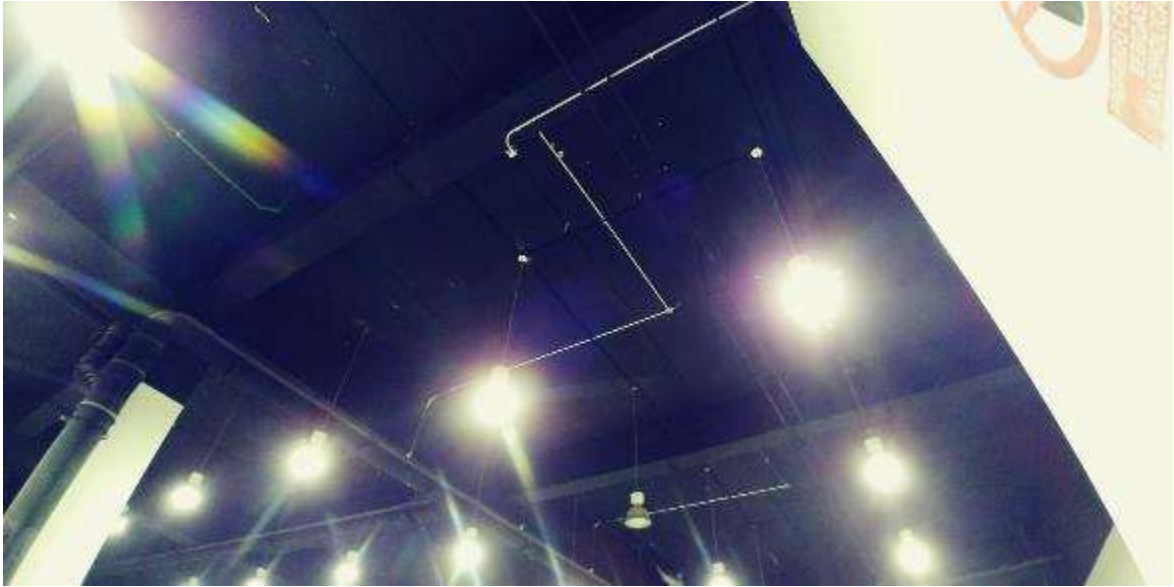
Figura 71. FOTO OBRA TEATRO - Colocación de cajas de pase y tuberías conduit para instalaciones eléctricas
