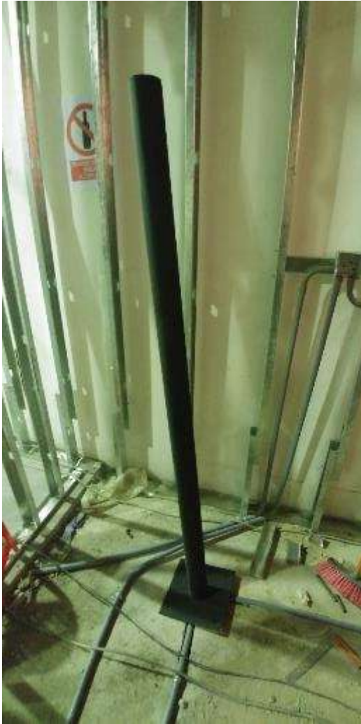
Figura 94. FOTO OBRA TEATRO - Entubado para cableado eléctrico en faroles
