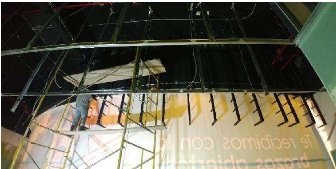
Figura 98. FOTO OBRA TEATRO - Instalación de perfilería metálica para marquesina
