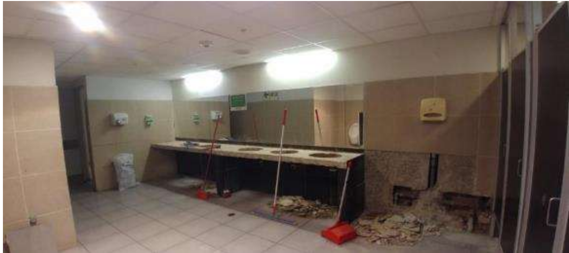
Figura 34. FOTO OBRA - Picado de pisos
