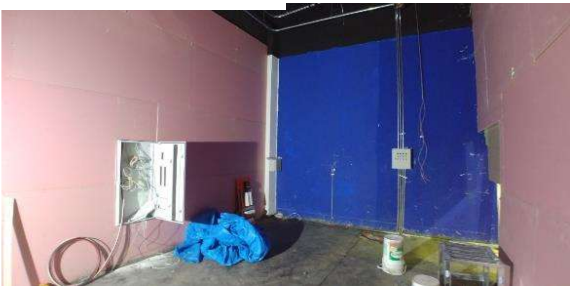
Figura 85. FOTO OBRA TEATRO - Colocación de nicho para tablero eléctrico
