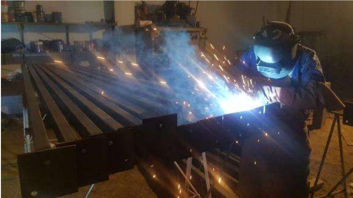
Figura 77. FOTO OBRA TEATRO - Preparación de columnas metálicas
