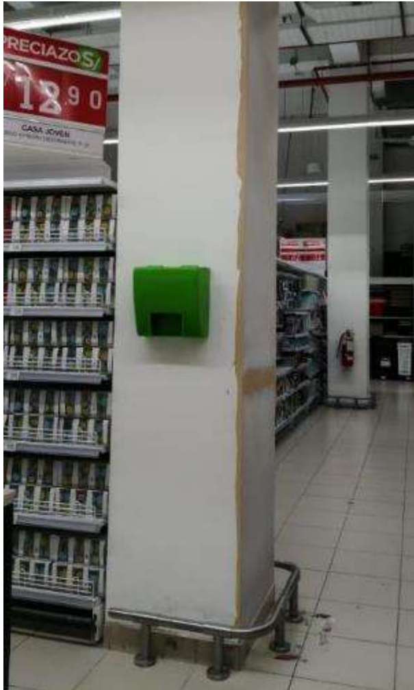
Figura 25. FOTO OBRA - Resane en muros para colocación de nueva gráfica
