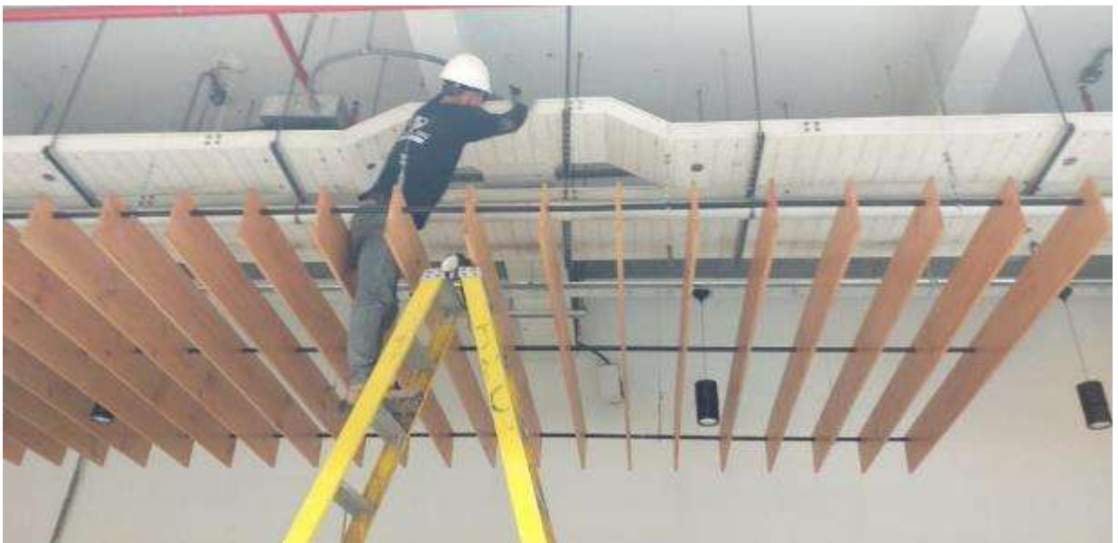
Figura 18. FOTO OBRA - Suministro e instalación de luminarias nuevas
