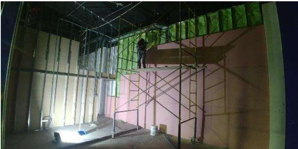
Figura 82. FOTO OBRA TEATRO - Instalación de drywall RF
