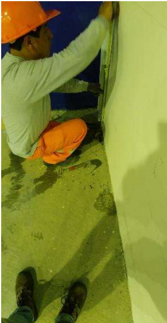
Figura 62. FOTO OBRA TEATRO - Nivelación y verificación altura de piso
