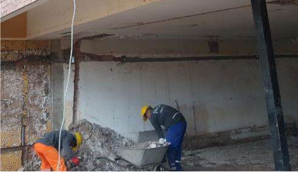
Figura 124. FOTO OBRA Tienda saludable - Acarreo de material de demolición
