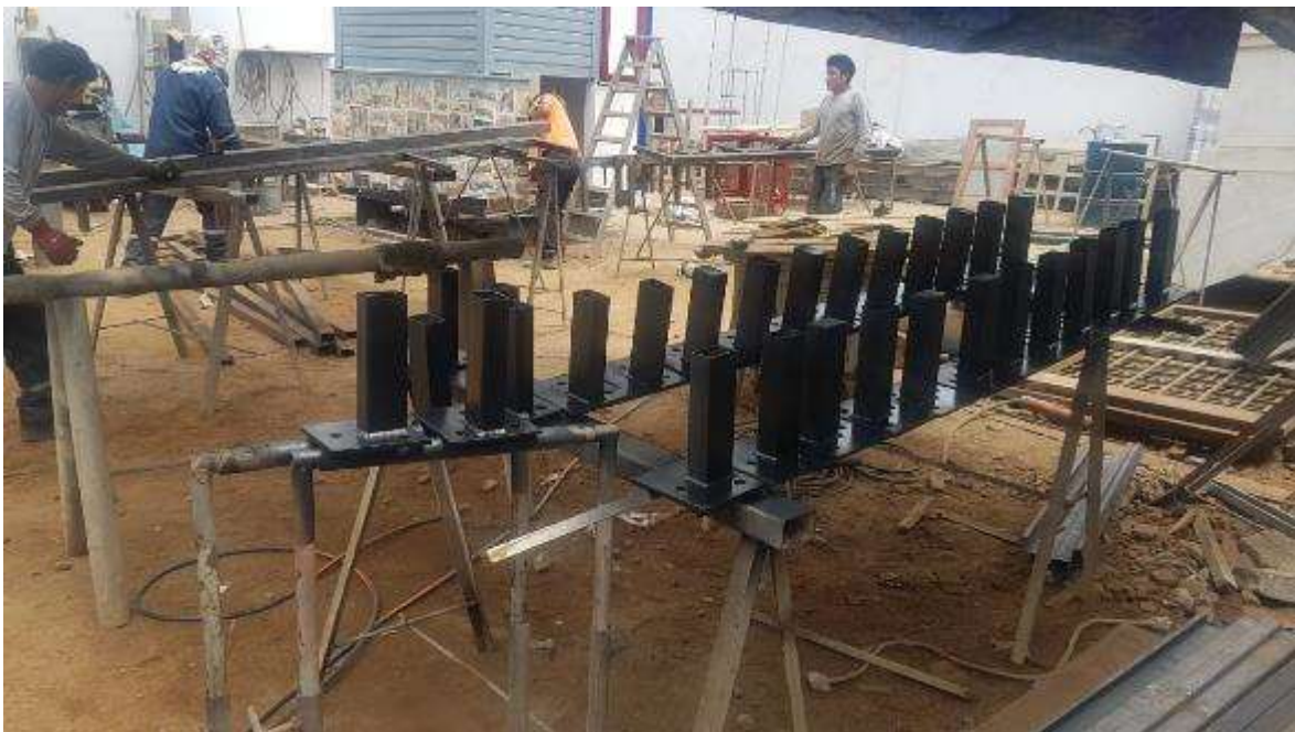
Figura 92. FOTO OBRA TEATRO - Suministro e instalación perfilería metálica para marquesina
