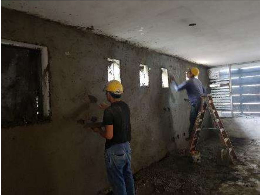
Figura 126. FOTO OBRA Tienda saludable - Tarrajeo de paredes
