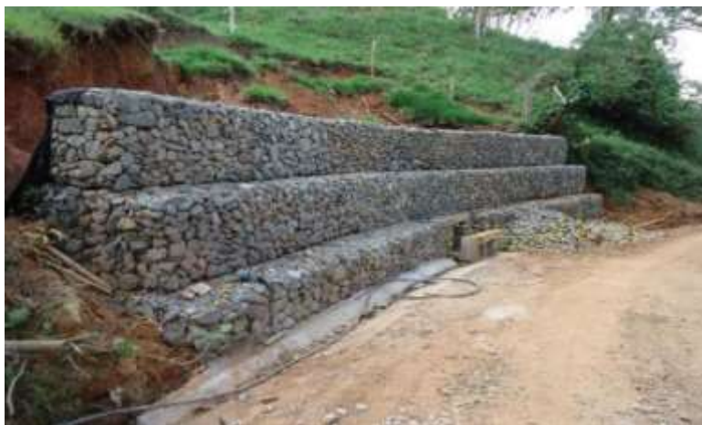
Figura 1: Estabilidad del terreno con Gaviones tipo Caja
