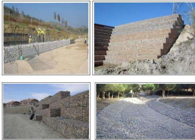
Figura 11: Tipo de gaviones y aplicaciones
