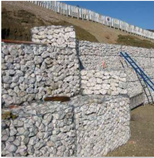
Figura 7: Detalle de piedras de relleno
