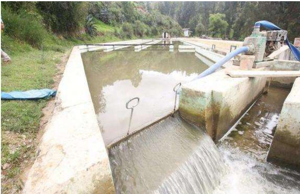
Figura 6. Captación en el sector El Ronquillo
