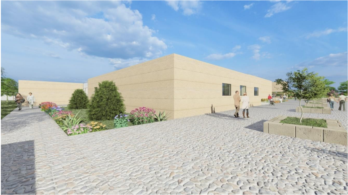
Figura 52. Vista de la zona administrativa.
