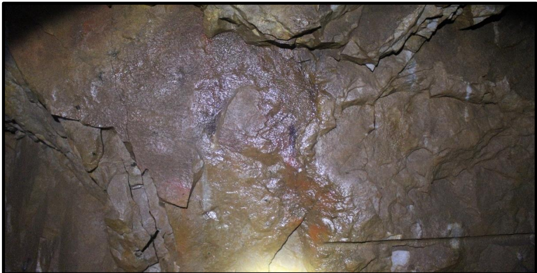
Figura 15: Presencia de agua en los macizos rocosos de la mina Nueva Esperanza Nv.2.
