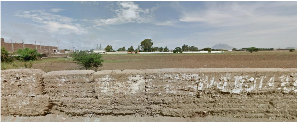
Figura 31: Vista desde la proyección de la Calle Héroes
