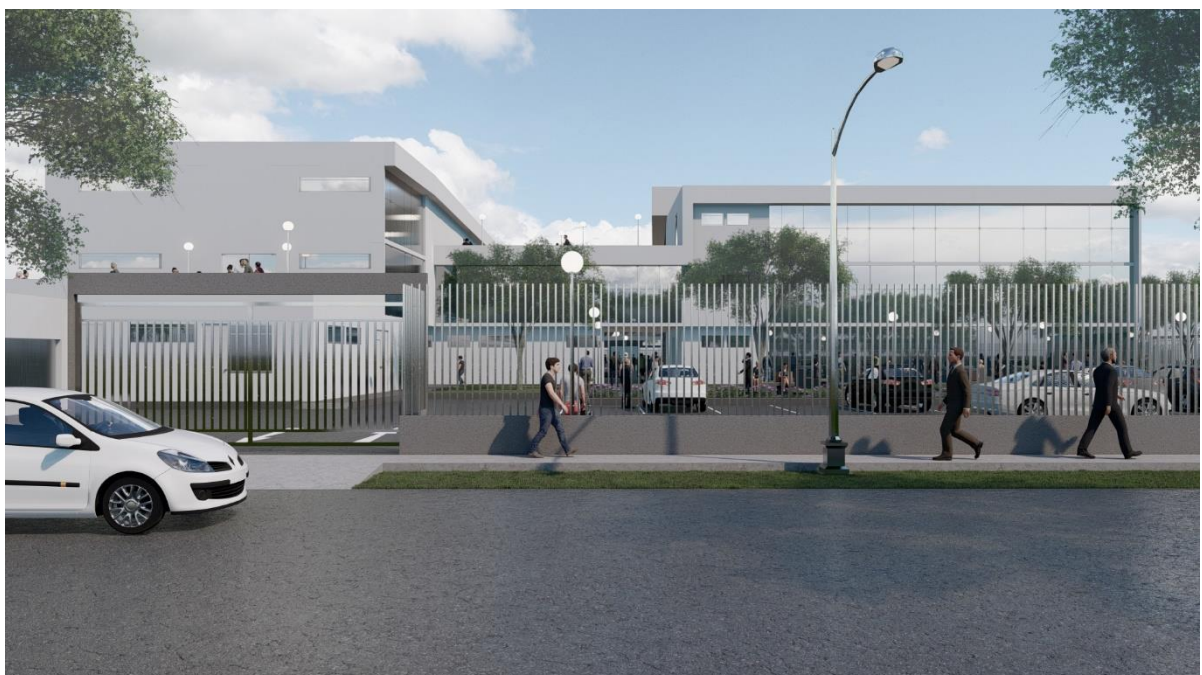
Figura 45. Vista fachada posterior
