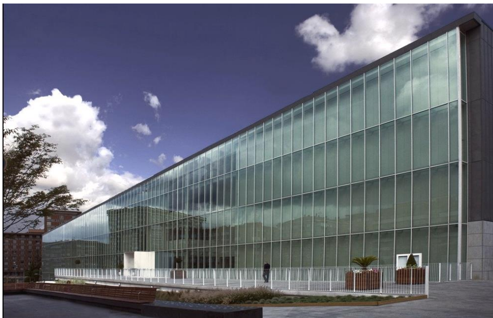
Figura 1. Vista general del caso 1
