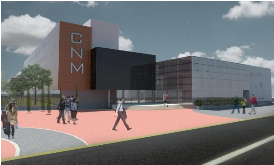
Figura 3. Vista general del caso 3
