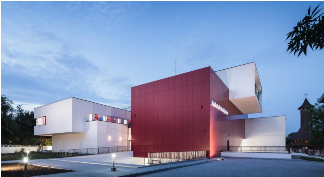
Figura 2. Vista general del caso 2
