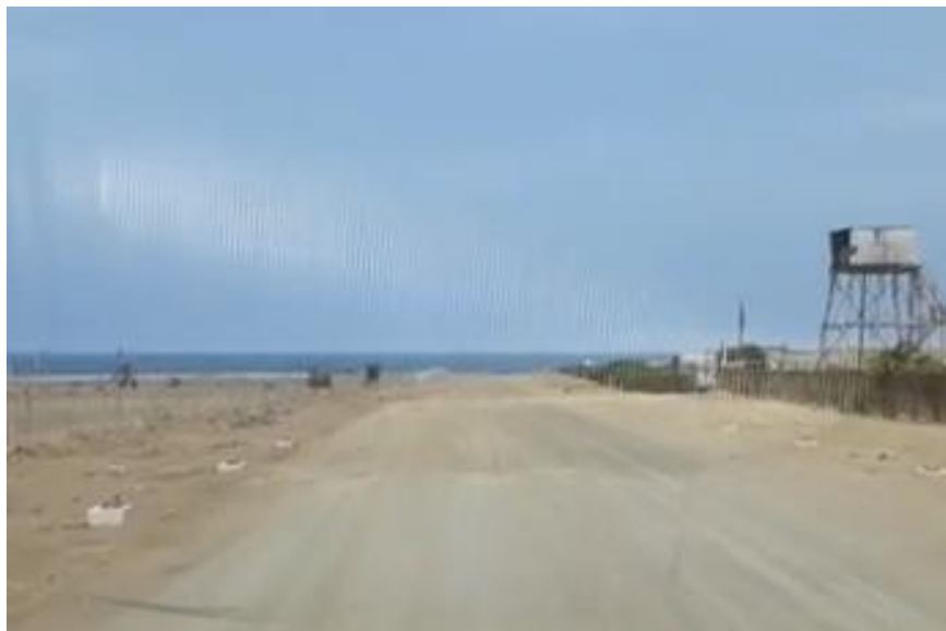
Figura 1. Vista del ingreso a Albúfera de Medio Mundo
