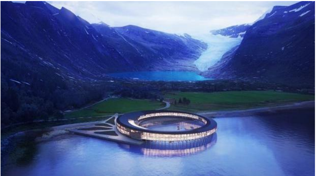
Figura 13. Vista aérea del caso 6
