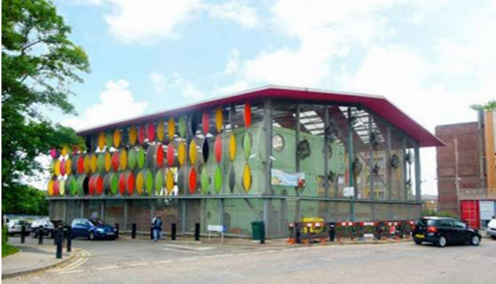
Figura 03: Vista De la fachada del Proyecto
