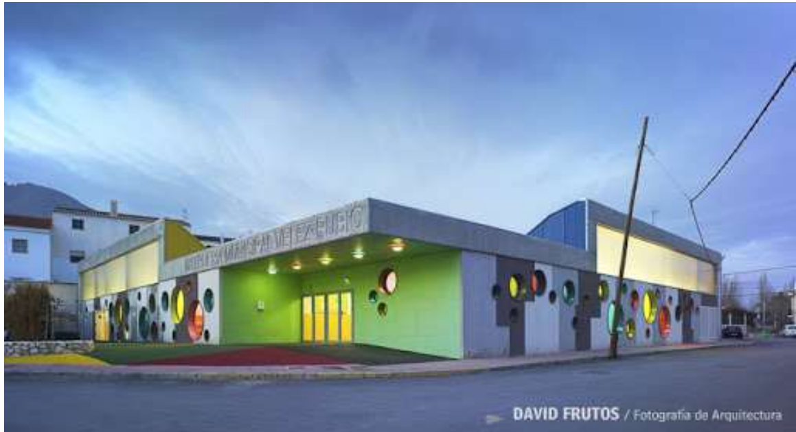
Figura 02: Vista Exterior de la escuela Infantil
