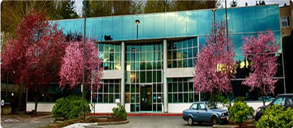
Figura 04: Vista De la fachada del Proyecto
