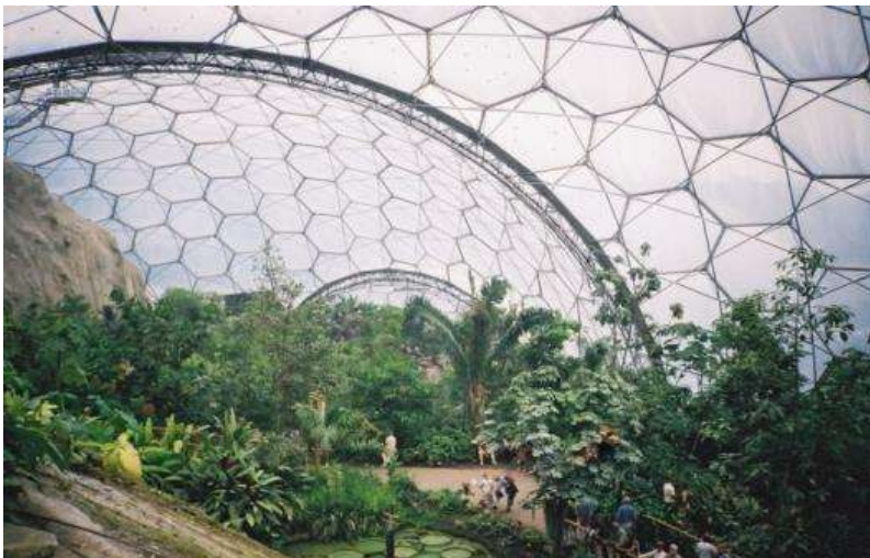
Figura 26. Uso de tubos de acero en la estructura.
