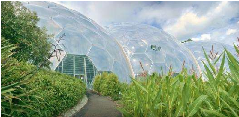
Figura 24. Sistema constructivo del proyecto.
