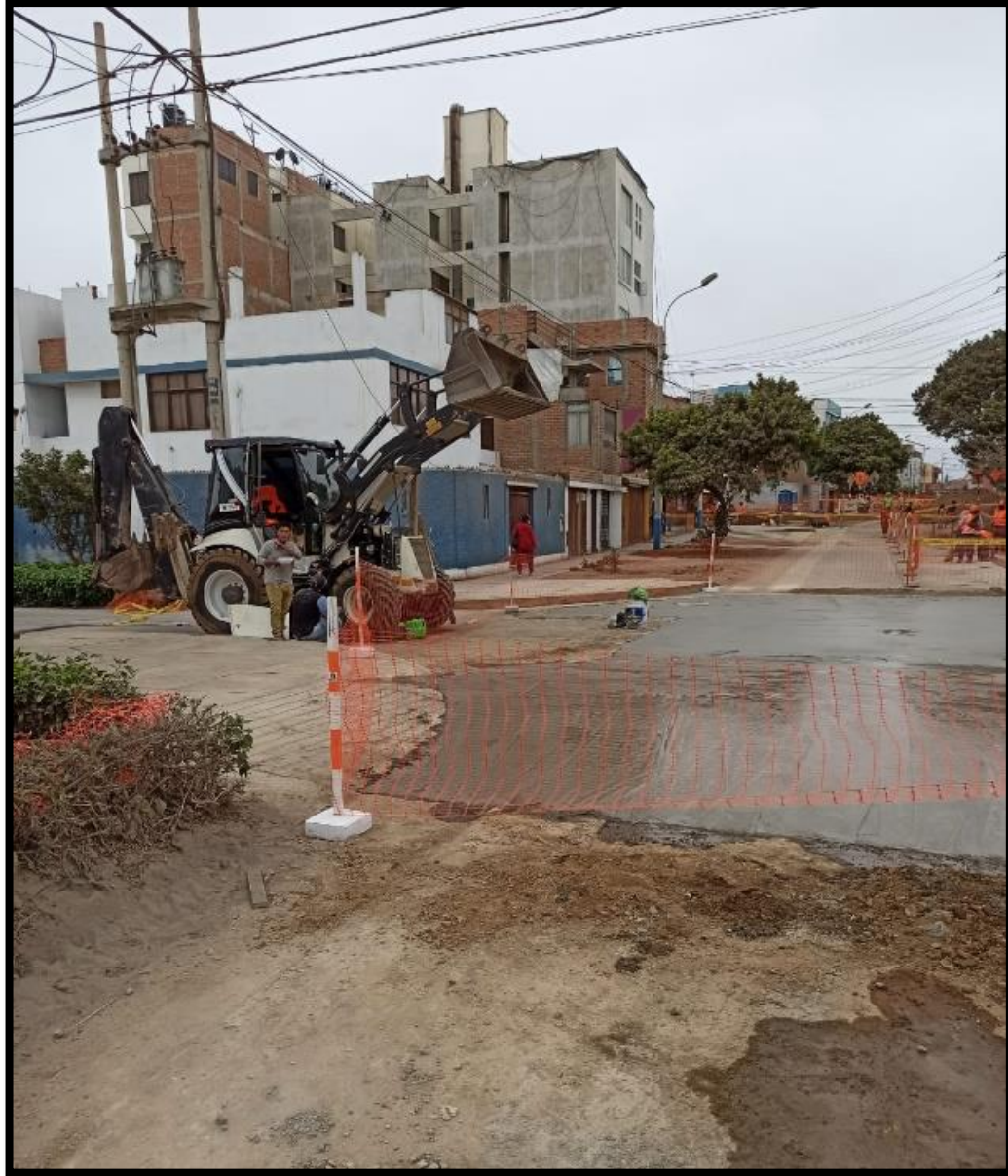
Figura 15. Vaciado de mayores metrados de concreto.
