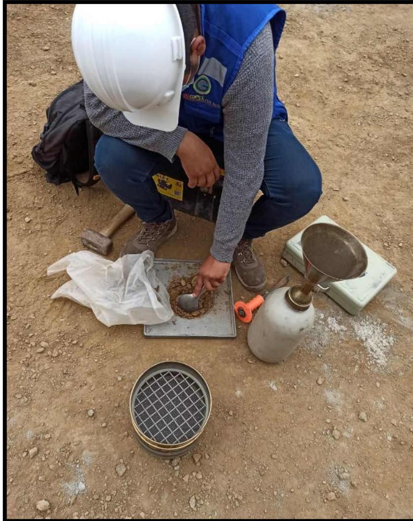
Figura 12. Ensayos de compactación para los mayores metrados.
