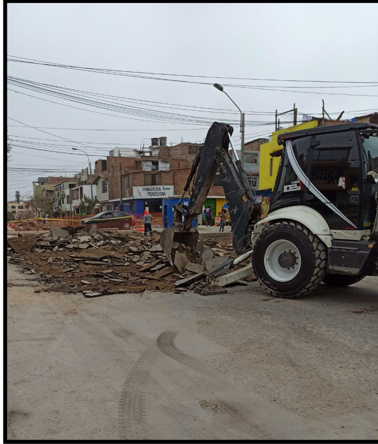
Figura 8. Mayores metrados de demolición de pavimento flexible.
