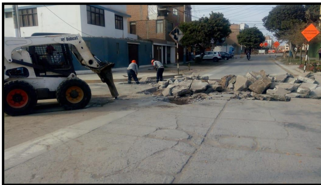
Figura 7. Mayores metrados de demolición de pavimento rígido.
