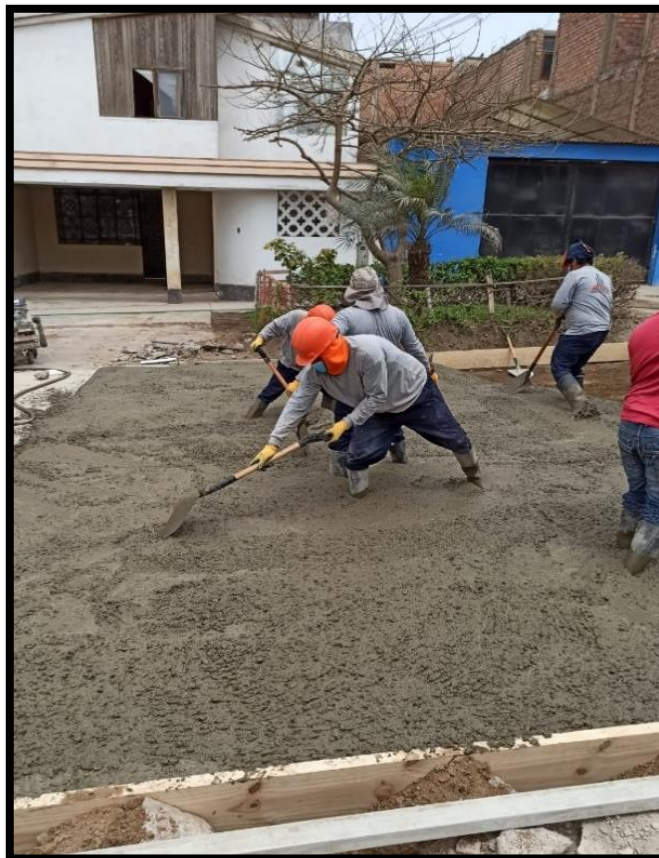
Figura 14. Vaciado de mayores metrados de concreto.
