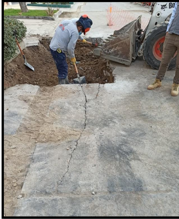
Figura 10. Mayores metrados de excavación has nivel de subrasante.
