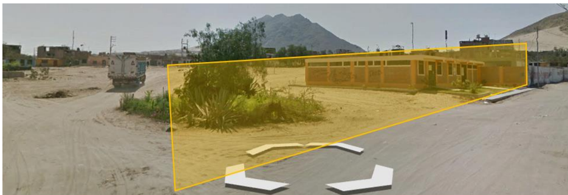
Figura 25. Vista del terreno desde la calle Huayna Capac
