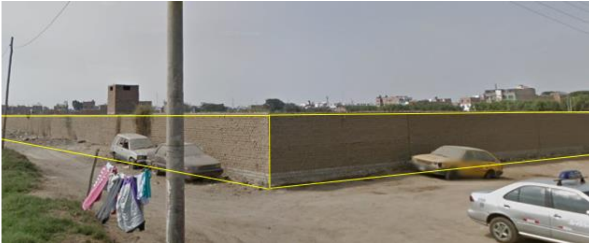
Figura 32. del terreno de la intersección de Ca. S/N 1 y Ca. S/N 2.
