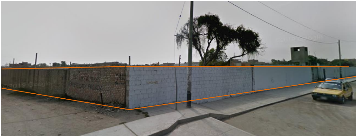
Figura 31. Vista de terreno desde la Av. Juan Pablo II
