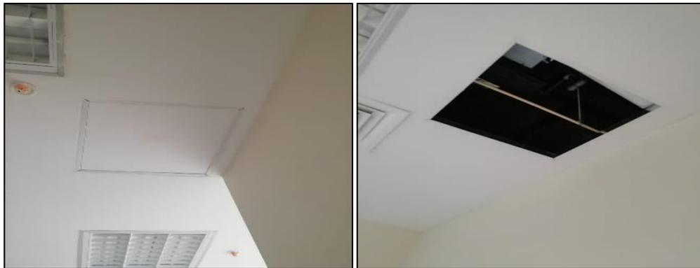
Figura 27 y 28. Ejemplo de tapas de inspección en falsos cielos rasos existentes
