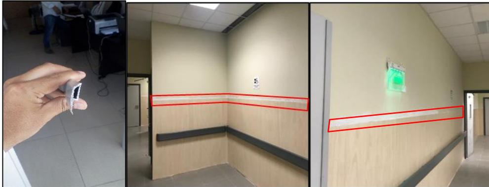
*Figura 29, 30 y 31. Medrado de zócalos de vinilo sin capping*
