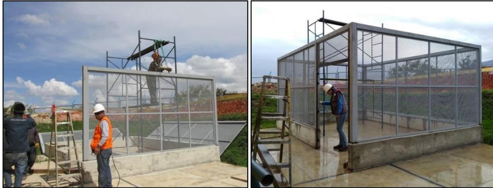
*Figura 102 y 103. Instalación de cerco perimétrico - Central de Oxígeno*
