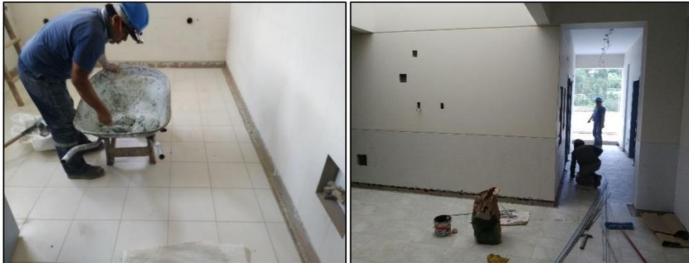
*Figura 90 y 91. Vaciado de contrazócalo terrazo – Bloque “A”*
