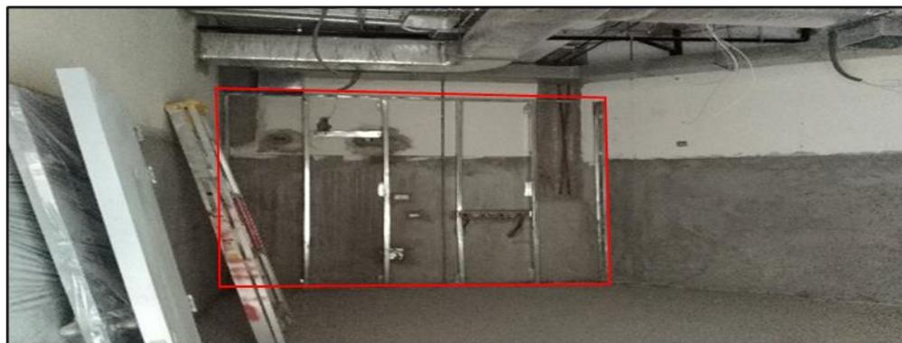
*Figura 83. Muro de tabiquería seca en Sala de Operaciones - Centro Quirúrgico*
