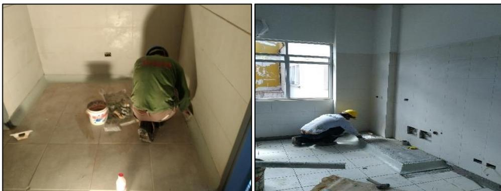
*Figura 92 y 93. Alisado de contrazócalo terrazo – Bloques “A” y “C”*
