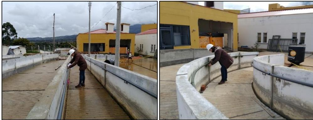
Figura 105 y 106. Verificación de medidas y acabados en baranda de rampas peatonal de acceso a Emergencia.
