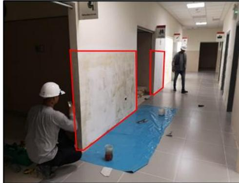
*Figura 26.* Muros pendientes de instalación de zócalos de vinilo
