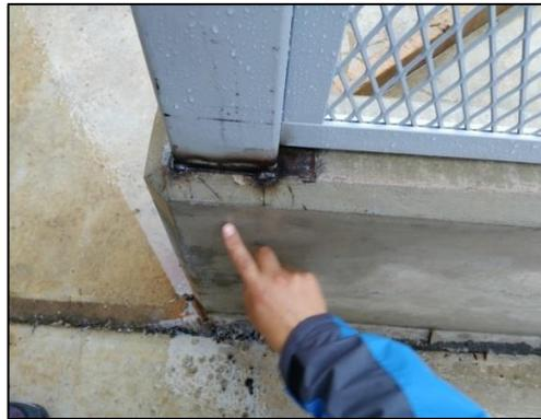
*Figura 104. Anclaje y soldadura de cerco perimétrico - Central de Oxígeno*
