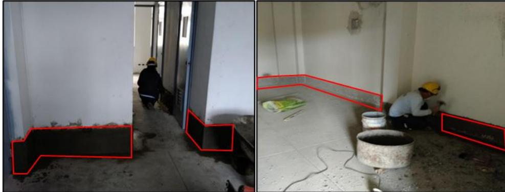
Figura 88 y 89. Aplicación de contrazócalo de cemento pulido en Talleres - Bloque “E”
