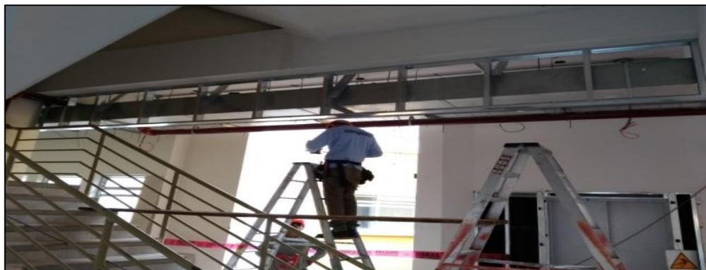
*Figura 78. Instalación de dinteles Bloque “A”*
