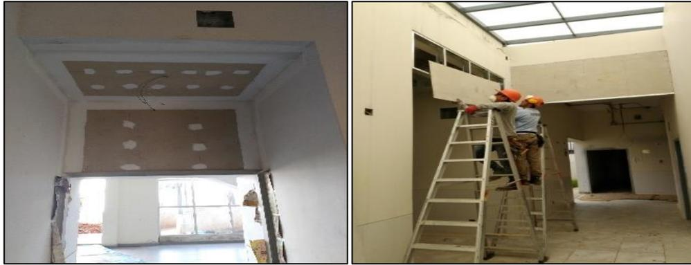
*Figura 79 y 80. Instalación de dinteles Bloque “B”*
