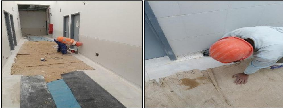
Figura 94 y 95. Pulido y limpieza de contrazócalo terrazo – Bloque “A”
