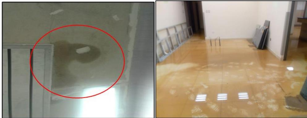
Figura 24 y 25. Ambientes con filtraciones pluviales
