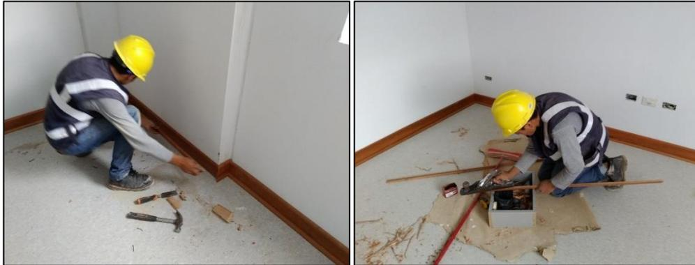
Figura 96 y 97. Instalación de contrazócalo madera – Bloques “A” y “C”
