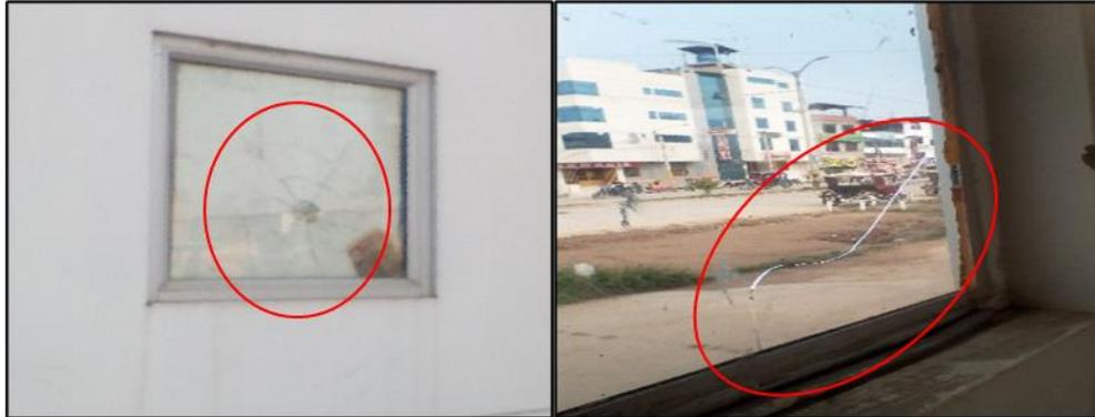
*Figura 41 y 42. Vidrios de casetas de control fisurados*
