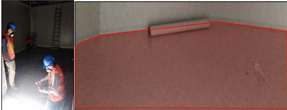
Figura 86 y 87. Instalación de piso vinílico conductivo en Salas de Operaciones
