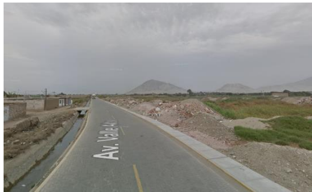
Figura 36: Vista Av. Valle Alto / Fuente: Google maps
