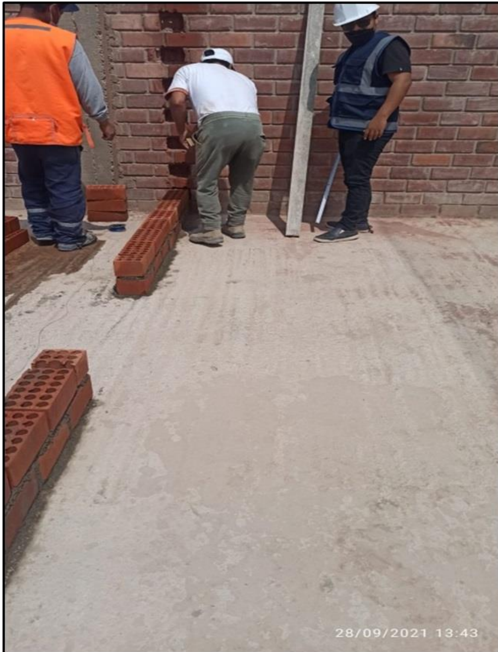
FIGURA N°216 – ASENTADO DE LADRILLO EN AREA DE COCINA
