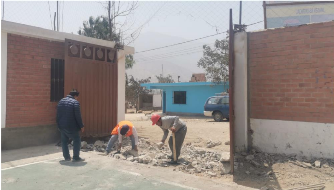
FIGURA N°211 – LIMPIEZA DE TERRENO MANUAL
