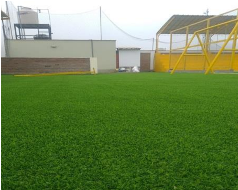
FIGURA N°237 – INSTALACION DE GRASS SINTETICO
