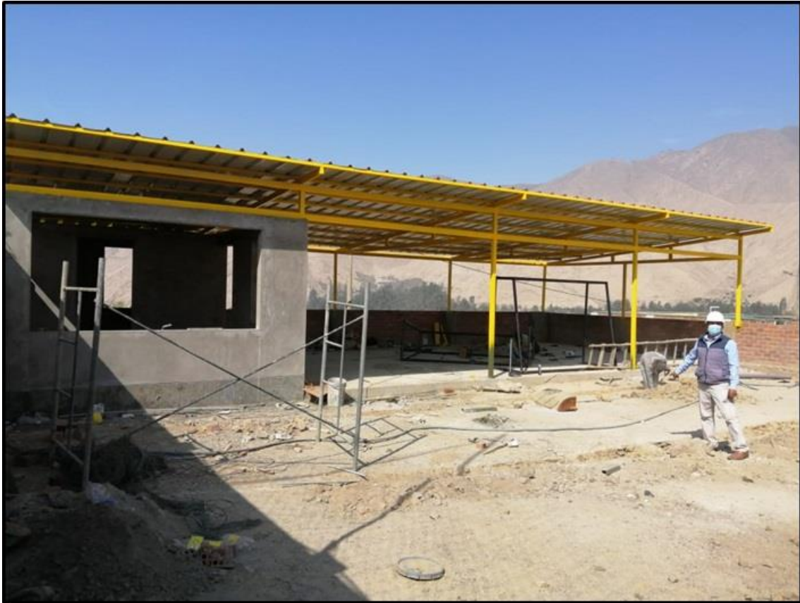
FIGURA N°226 – ARMADO DE COBERTURA METALICA EN COMEDOR
