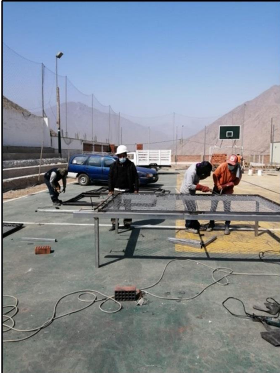
FIGURA N°218 – ARMADO DE ESTRUCTURA METALICA DE CERCO
