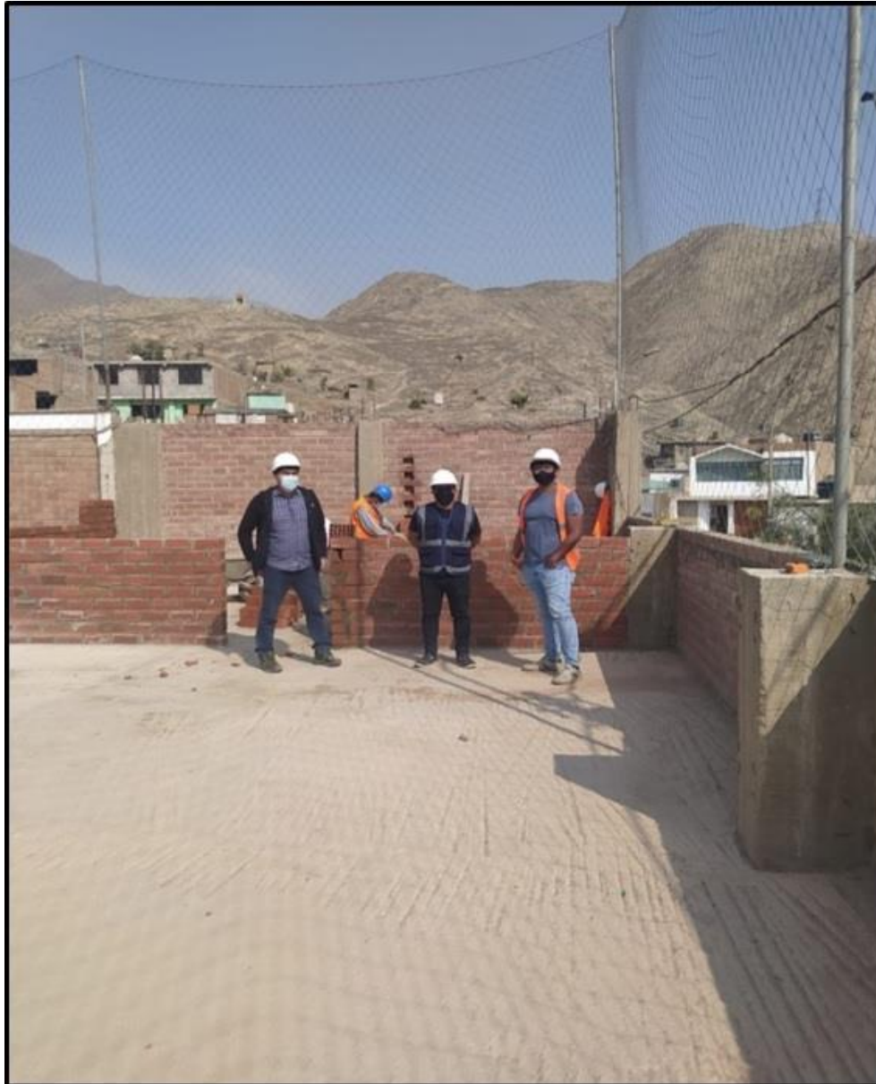
FIGURA N°214 – ASENTADO DE LADRILLO EN AREA DE CAFETERIA
