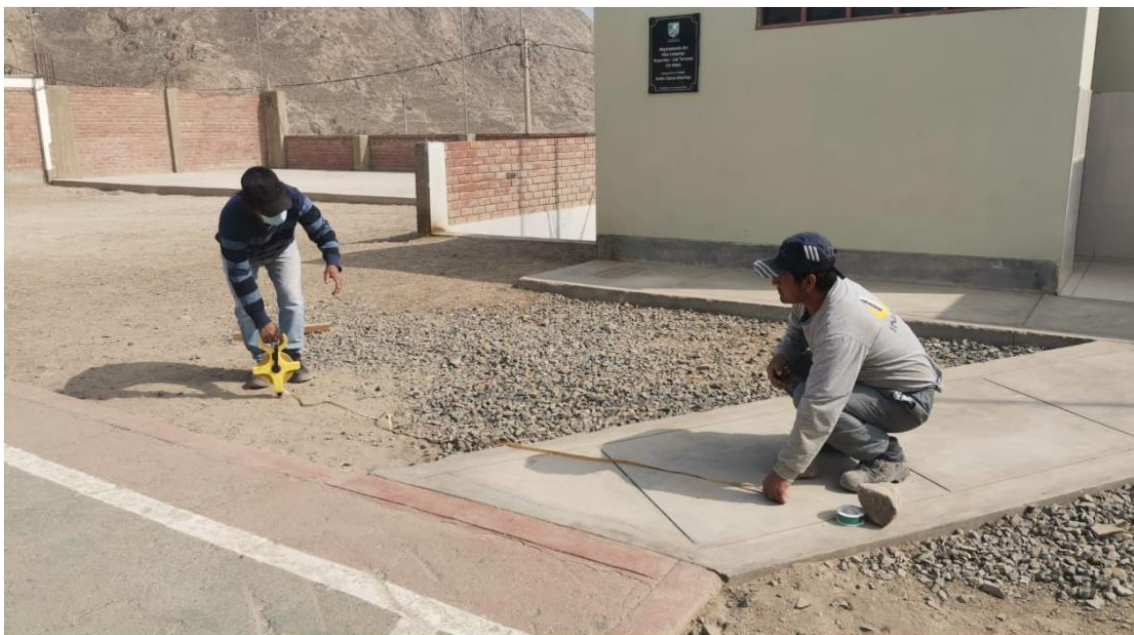
FIGURA N°212 – TRAZO Y REPLANTEO PRELIMINAR
