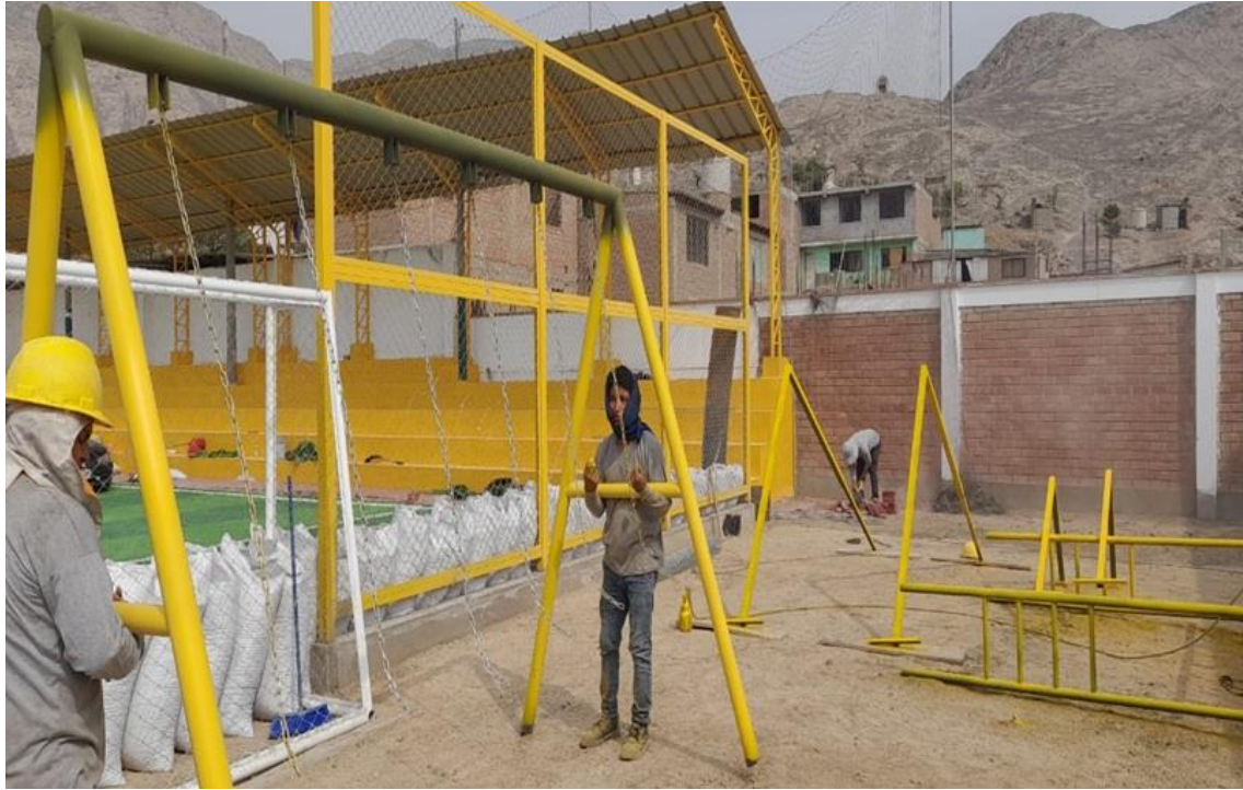
FIGURA N°236 – INSTALACION DE JUEGOS INFANTILES
