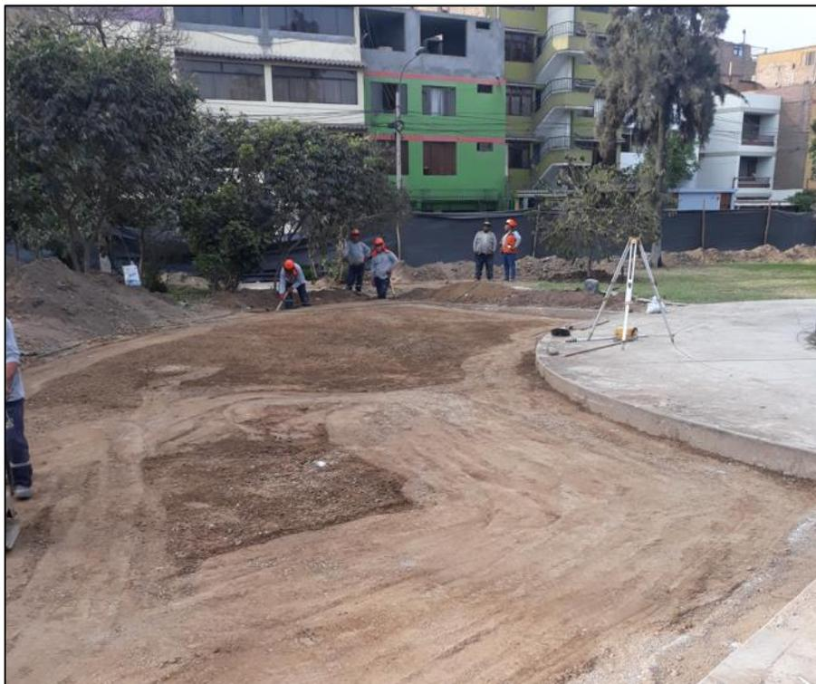
16/11/2022: Se continuó con las excavaciones para el sardinel peraltado perimétrico alrededor de la losa deportiva. -Se realizó el trazado de la proyección de losa deportiva in situ. Se continuó con las actividades de limpieza del parque san Cristóbal. - Se termino con la actividad de excavación de zanjas para tuberías eléctricas perfilándose a una altura de 0.70m.
