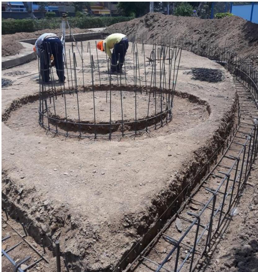
Habiéndose Autorizado por la supervisión el vaciado de concreto en sardinel peraltado 0.15x0.45m (perímetro parque paralelos a la ca. San Ramón y ca. San marcos), en sardinel peraltado 0.30 x 0.60m (perímetro de losa deportiva) y en vereda de concreto ubicado en la rotonda para gruta, se procedió a la ejecución del mismo de concreto  $f'c=210$  kg/cm<sup>2</sup> tipo v.
