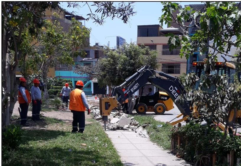
29/10/2022: Se continuó parcialmente con el corte a nivel de subrasante para veredas. Se continuó con el perfilado y compactado de subrasante. -Se da inicio a las actividades de conformación, nivelado y compactado de base en vereda e=15cm en la ca. San Ramón. Se continuó con la actividad de picado de concreto en tribuna.
