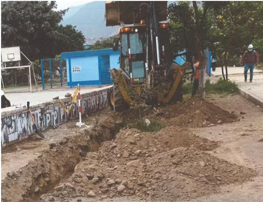
17/11/2022: Se realizo el replanteo del trazo de proyección en el área deportiva. - Se continuó con las excavaciones para el sardinel peraltado de la losa deportiva. -Se realizo parcialmente el tendido de cama de arena y tubería pesada en el recorrido de las zanjas para las instalaciones eléctricas. - Se continuó con la fabricación y habilitado de los postes para las luminarias del parque. - Se continuó con las actividades de limpieza.
