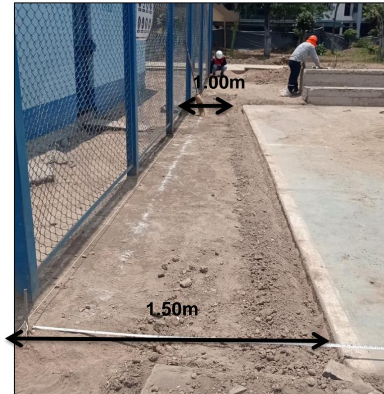
*Por lo que se planteó realizar el corte de unos 20cm del ancho de tribuna para ganar espacio de acceso de 2.50m según plano y de esta manera el alineamiento del cerco perimétrico moverlo unos 20cm para quedar paralelo y lineal a la losa sin interferir con el cerco inclinado de sedapal.*
