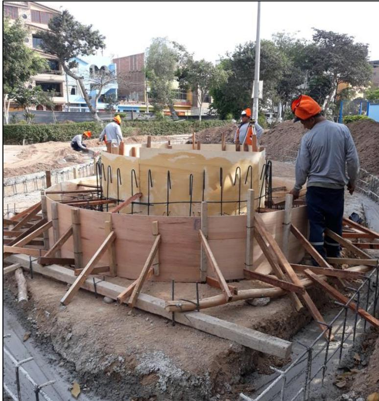
24/11/2022: Se culminó con las actividades del encofrado del sardinel peraltado 0.30x0.60m ubicado en la losa deportiva. -Se culminó el encofrado parcial para los dados de concreto de los postes del cerco metálico. se solicitó la autorización de los tramos paralelos a la ca. San Ramón y ca. San marcos a supervisión para su posterior vaciado de concreto.
