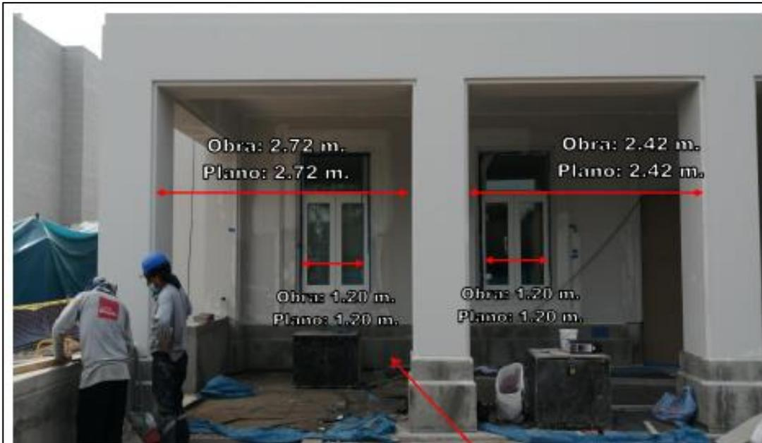
**Missionary:** Se verifica medidas en fachada en eje A, cumpliendo con medidas del plano aprobado A-26, incluyendo medida de ventanas V-02
