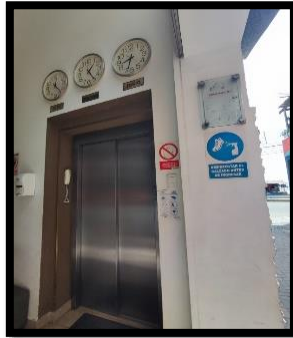
VISTA DEL ELEVADOR DESDE RECEPCIÓN
