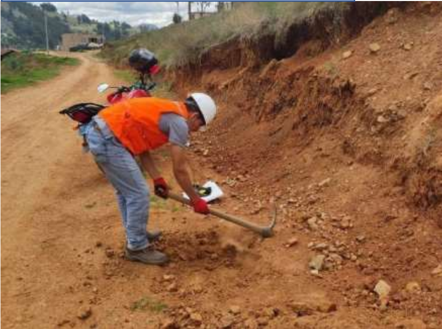
Excavación de calicatas
