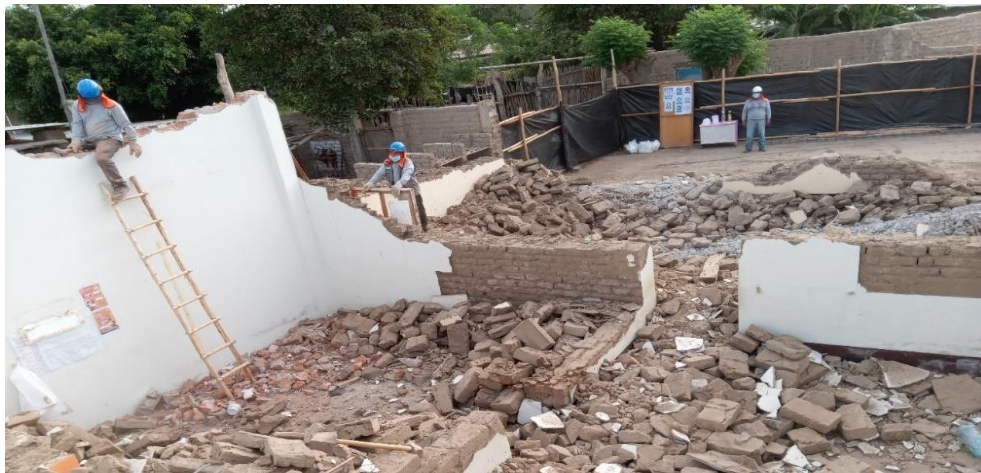
Figura 15. Demolición de modulo A
