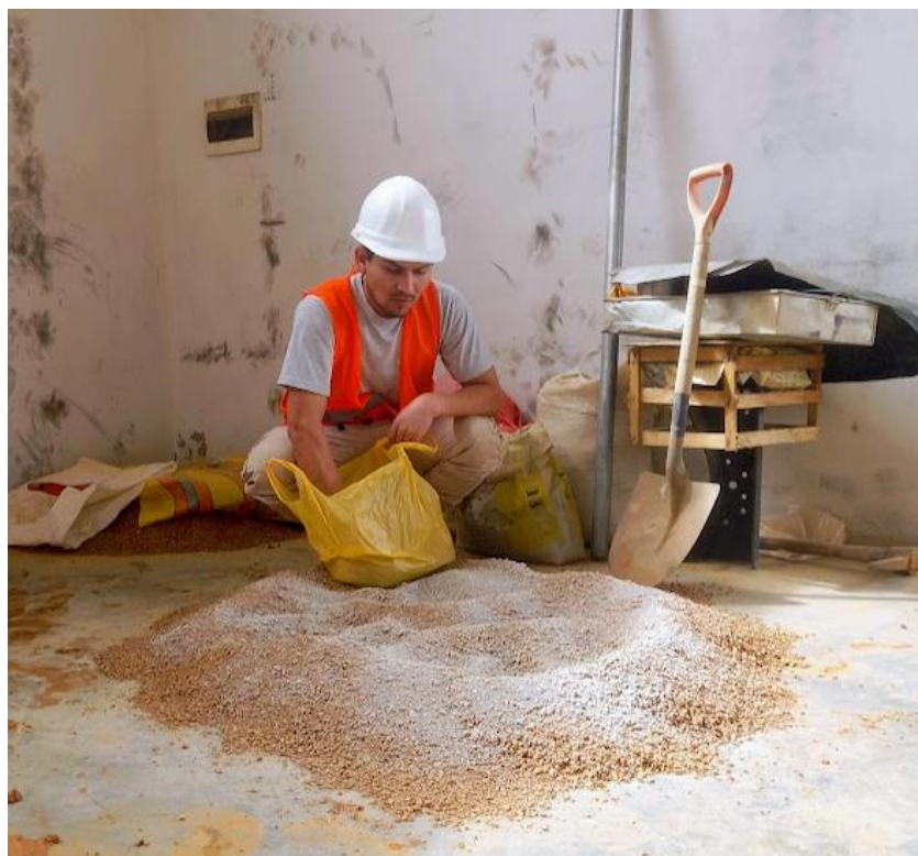
Figura 46: Adicionamiento de la piedra caliza triturada en la mezcla de la elaboración de
