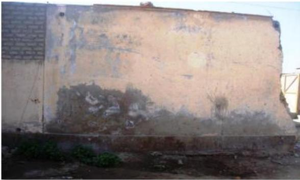
*Nota.* En la presente figura se puede apreciar la eflorescencia en un muro de albañilería confinada.
