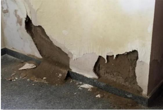
*Nota. En esta imagen se observa la humedad capilar en gran daño al muro portante. Fuente: Parra y Vásquez (2014).*
