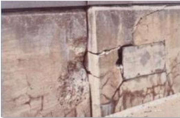
*Nota.* Se puede apreciar la distorsión entre dos sobrecimientos de muros colindantes de concreto armado. Fuente: Jiménez (2016).
