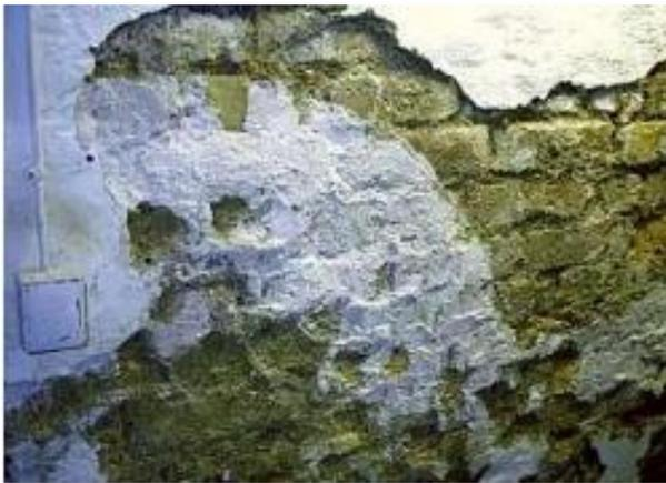
*Nota.* Figura donde se aprecia la criptoflorescencia de un muro. Fuente: Parra y Vázquez (2014).
