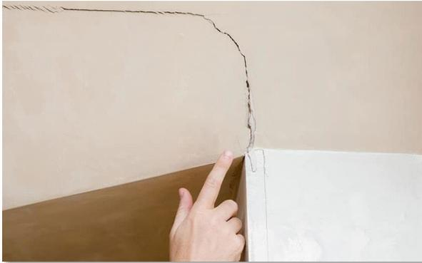
*Nota.* Se observa una grieta común con grado patológico en un muro. Fuente: Jiménez (2016).
