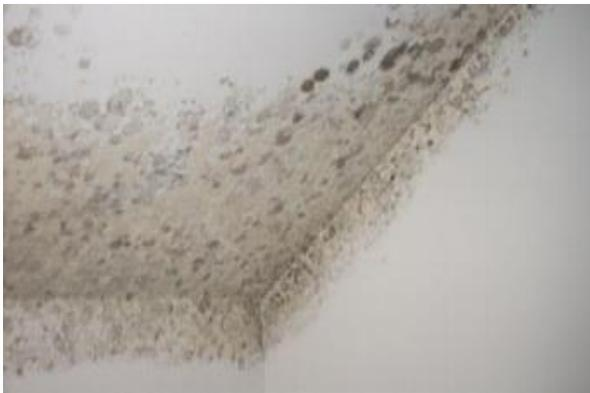
*Nota. En esta imagen se aprecia el grado de afección que por filtración daña al mismo tiempo el muro y losa aligerada. Fuente: Parra y Vásquez (2014).*
