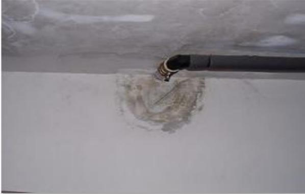
*Nota.* En esta figura se puede apreciar la humedad por accidente de una tubería interna. Fuente: Parra y Vásquez (2014).
