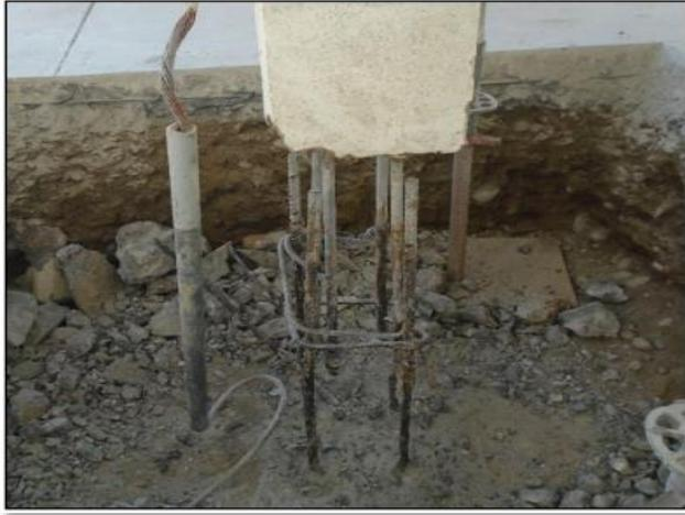
*Nota.* Se aprecia el óxido del acero en columna del último piso. Fuente: Cuzcano, (2021).
