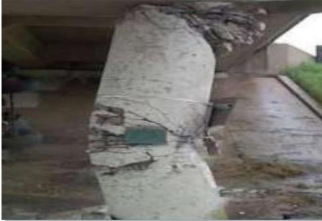
*Nota. Se observa la deformación por pandeo de una columna típica de un puente por sobrecargas y descontrol. Fuente: Villanueva (2018).*
