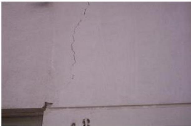
*Nota.* Figura donde se aprecia la presencia de una fisura de mayor grado en el muro del primer piso. Fuente: Jiménez (2016).
