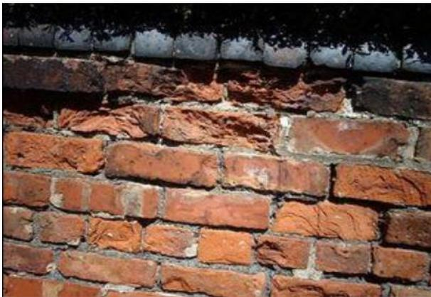
*Nota.* En la figura se aprecia la erosión en un muro de albañilería confinada. Fuente: Cuzcano (2021).
