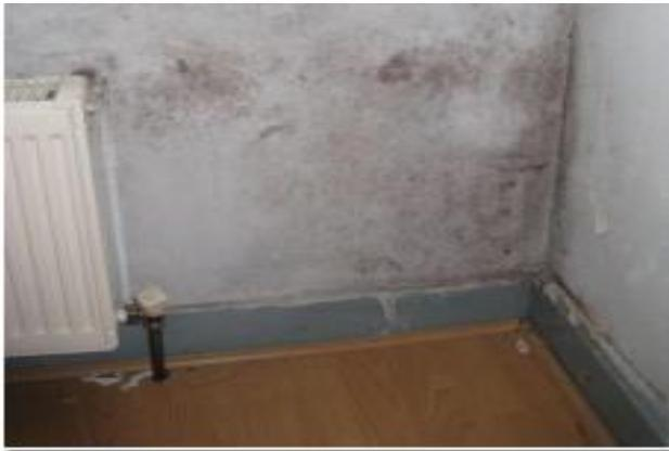
*Nota.* Esta figura es aquella donde se puede apreciar la humedad por condensación en el primer piso. Fuente: Parra y Vásquez (2014).
