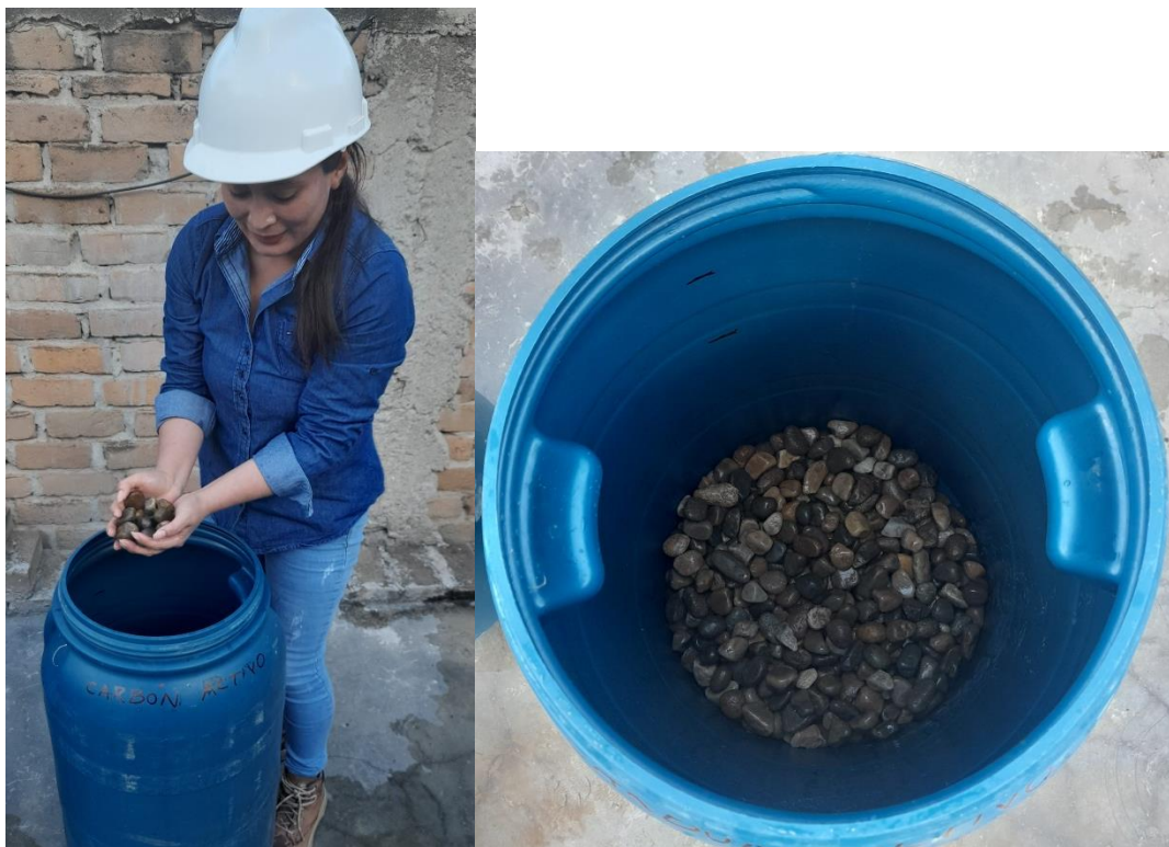
Fotografías N° 5 y 6: Ubicación de la piedra para el filtro de carbón activado
