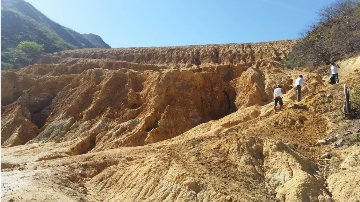
Toma fotográfica N° 1: Presa de acumulación de relave minero (Ex unidad minera Paredones)
