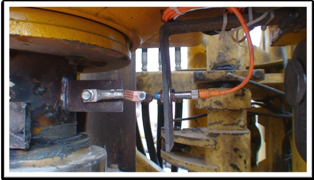
Figura N° 12. Reinstalación del sensor RPM de la perforadora Reedrill SKS-12.
