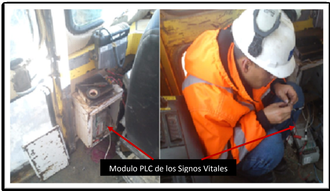
Figura N° 09. PLC de los signos vitales de la perforadora Reedrill SKS-12
