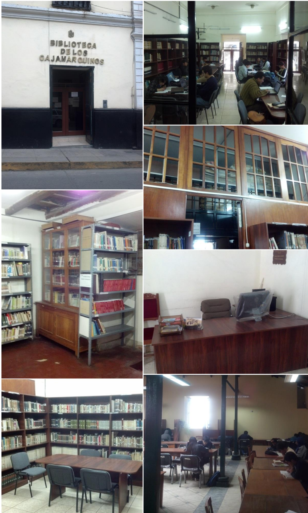
FOTO N° 1. Estado actual de la Biblioteca Municipal “José Gálvez”
