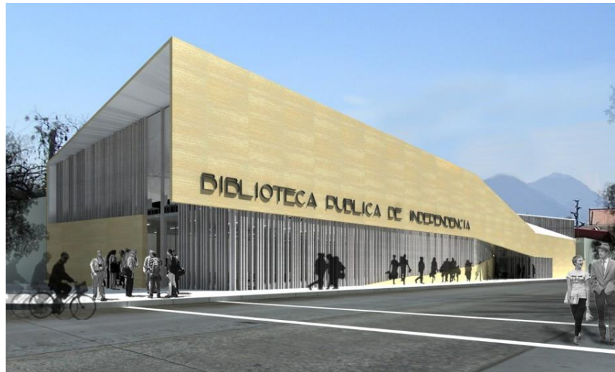
FOTO N° 6. Vista en esquina de la Biblioteca Pública de Independencia.
