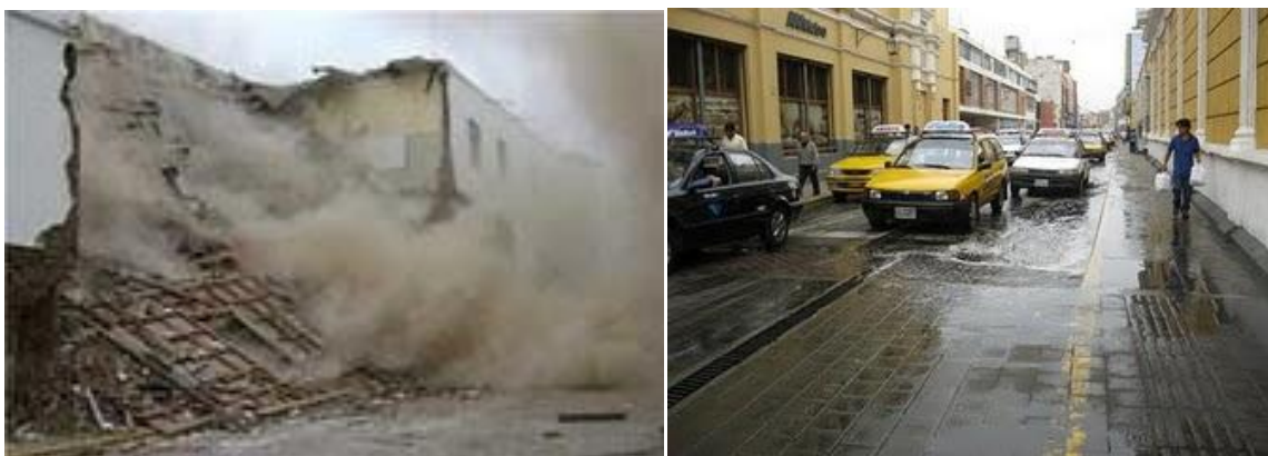
Ilustración 10 e Ilustración 11: Imágenes que muestran las consecuencias a causa de lluvias en el Centro Histórico de Trujillo
