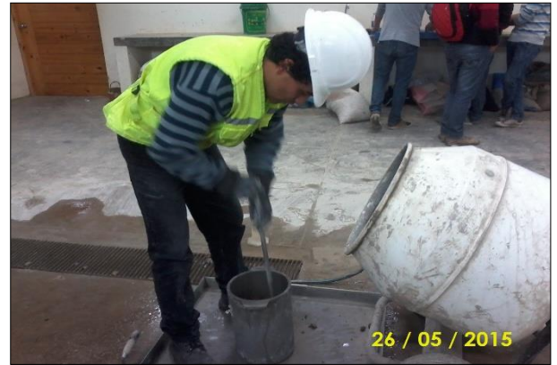
Fotografía N° 21: Prueba de control de peso unitario del concreto
