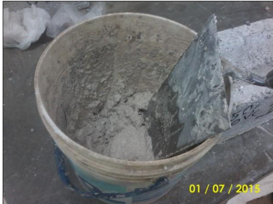
Fotografía N° 36: Preparación de mezcla yeso – cemento para refractar los ladrillos
