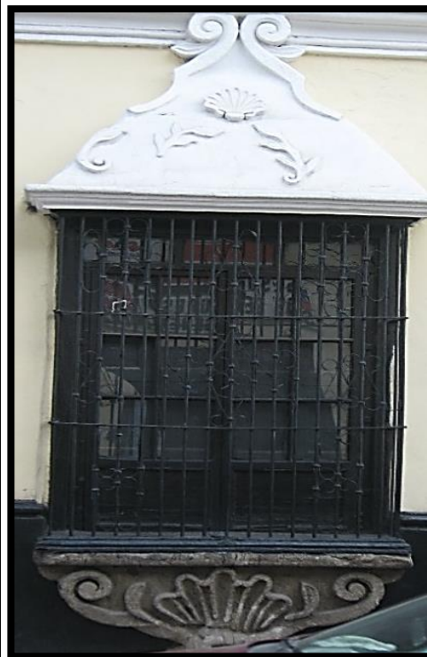
Fig. 27: Detalle de las ventanas principales de la casona Espinach.
