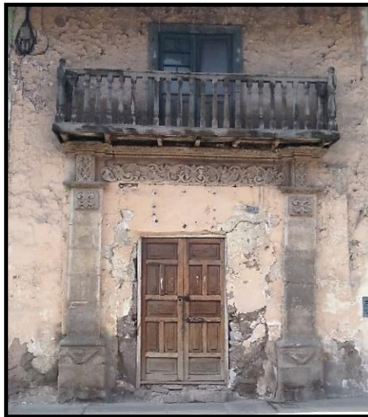
Fig. 4: Distorsión estructural.
