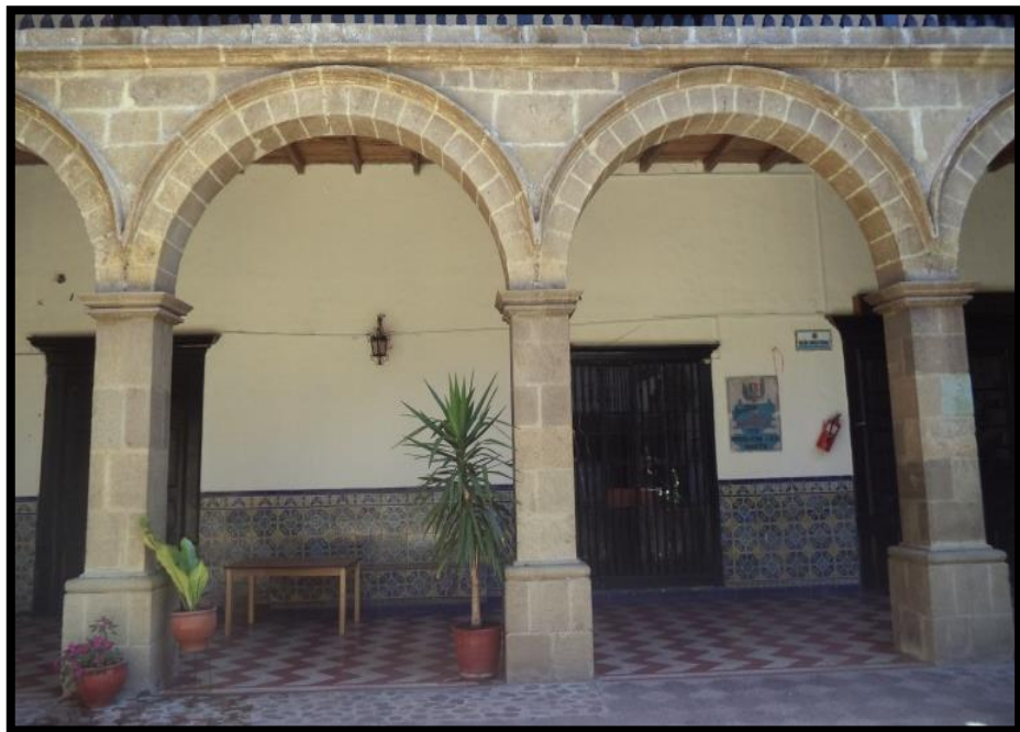
Fig. 37: Arquería de piedra de patio principal de la casona Espinach.
