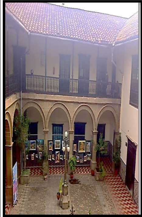
Fig 32: Techo de casona vista superior.
