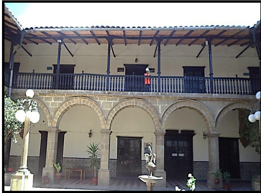
Fig. 35: Balcón corrido patio principal de la casona Espinach.
