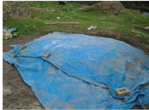
Masa en reposo cubierta con plástico para protegerlo de la lluvia.
