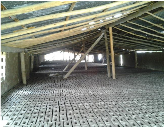
Ladrillos almacenados en un terreno espacioso y plano, cubierto con calaminas para protección de la lluvia.
