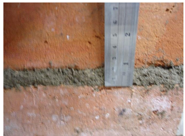
Foto 30. Medida del espesor de la junta.
