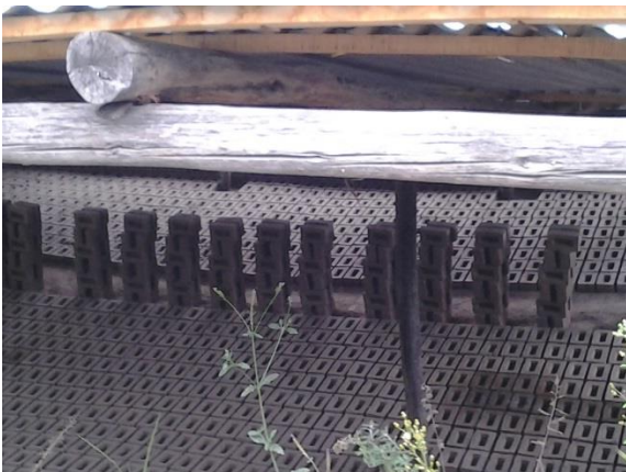
Se va colocando los ladrillos uno encima de otro como torres.
