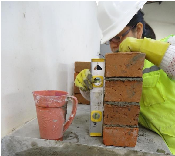
Foto 31. Verificación la pila nivelada.
