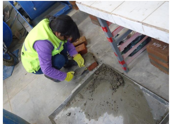
Foto 28. Construcción de las pilas.
