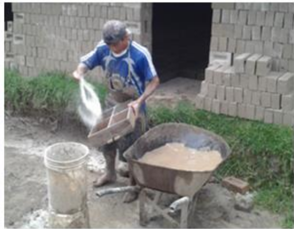
Poner arena a las gaberás para que no se pegue la mezcla
