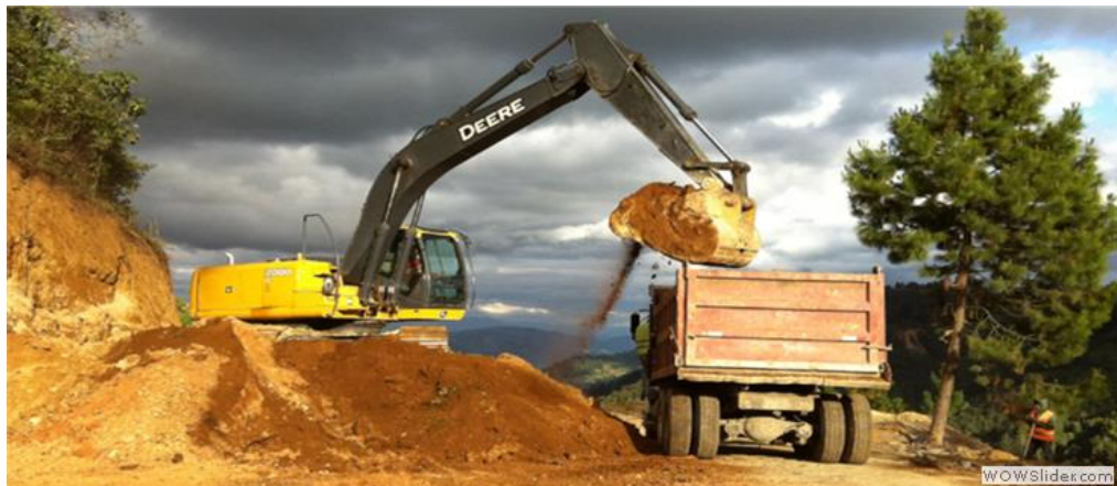
Figura N° 15: Extracción de arcilla con maquinaria.
