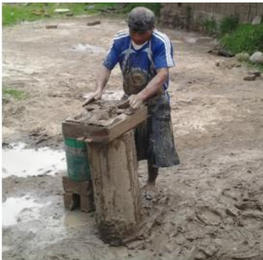
Amasado de la mezcla en el molde.
