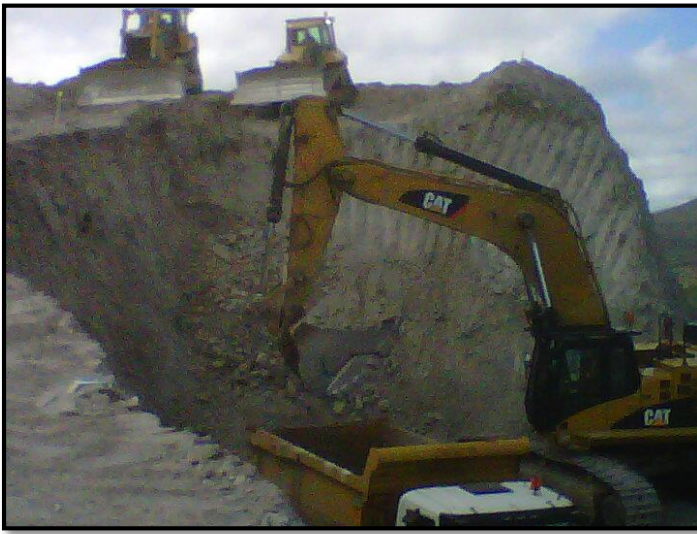
Foto 01: Carguío de volquete en minado
