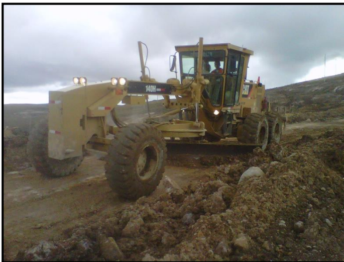
Foto 05: Corte y nivelación de vía
