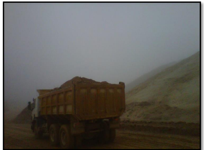
Foto 02: Acarreo de material
